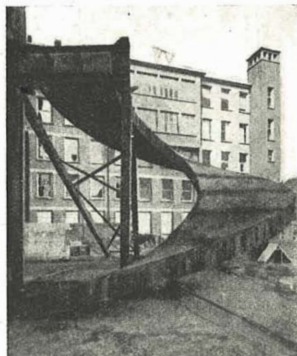
Fig. 5.—Al no existir fórmulas apropiadas para el cálculo de esta escalera, fué preciso construir un modelo a escala natural y ensayar su comportamiento bajo carga.
