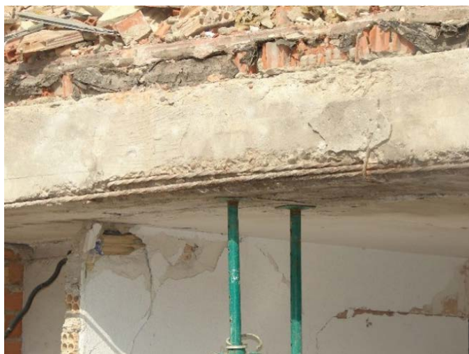
Desconchones en el hormigón.
