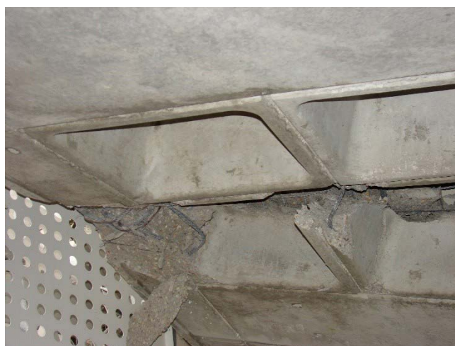
Figura 4. Rotura por cortante en una alineación de nervios de forjado a la salida del ábaco (Aparcamiento en Aeropuerto de Barajas, Madrid, 2006).
