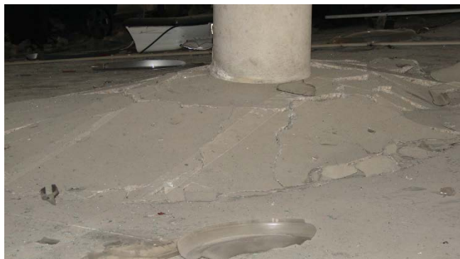
Figura 5. Daños por punzonamiento (Aparcamiento en Aeropuerto de Barajas, Madrid, 2006).
