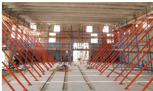
Figura 12. Subestación eléctrica totalmente prefabricada.
