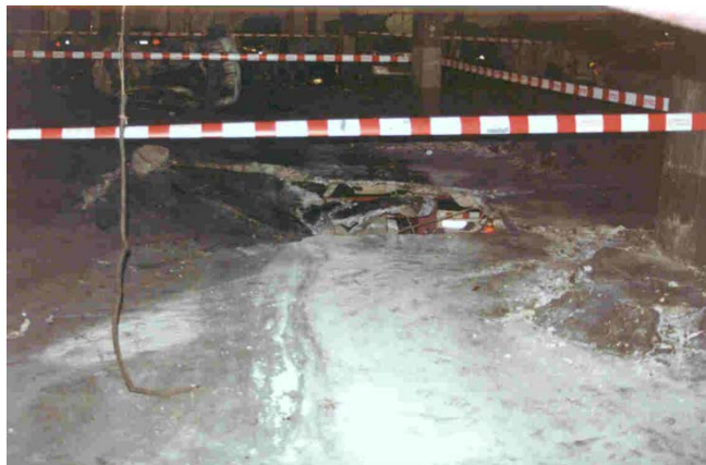
Aparcamiento Pza. Colón, Madrid. 2001.
