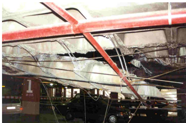
Aparcamiento P2 Aeropuerto Barajas, Madrid. 1998.
