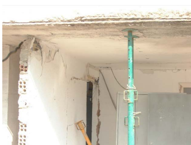
Desconchones en el hormigón.
