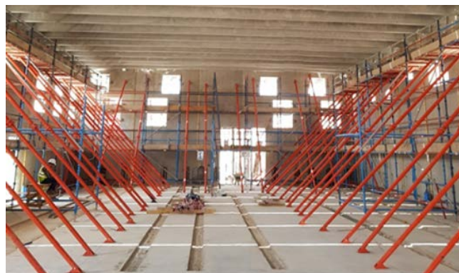
Figura 12. Subestación eléctrica totalmente prefabricada.
