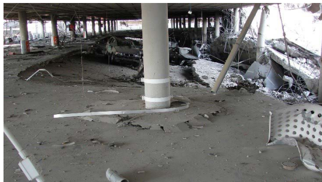
Figura 5. Daños por punzonamiento (Aparcamiento en Aeropuerto de Barajas, Madrid, 2006).
