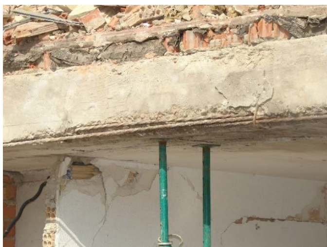
Desconchones en el hormigón.
