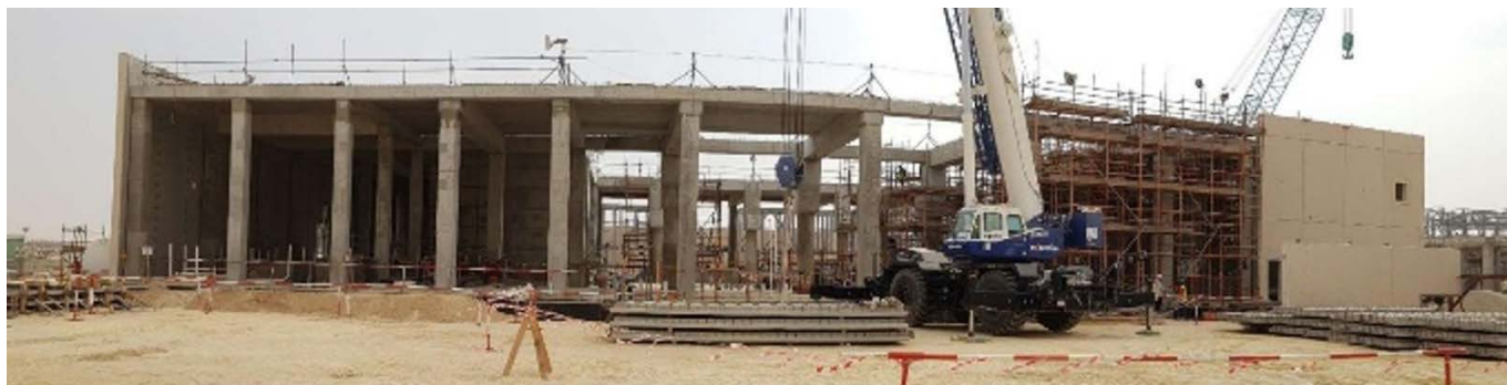
Figura 11. Edificio de control con solución híbrida.
