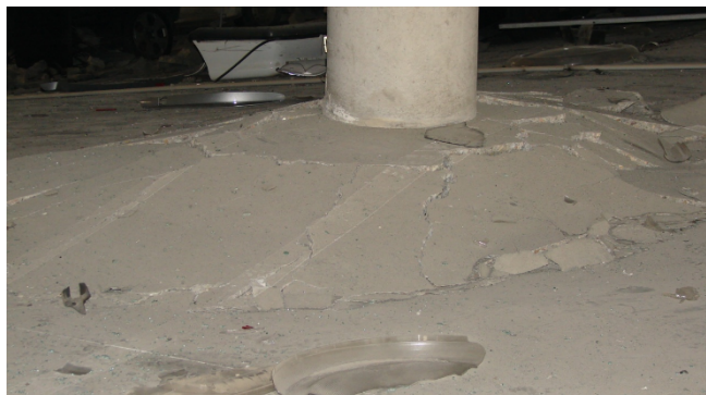
Figura 5. Daños por punzonamiento (Aparcamiento en Aeropuerto de Barajas, Madrid, 2006).
