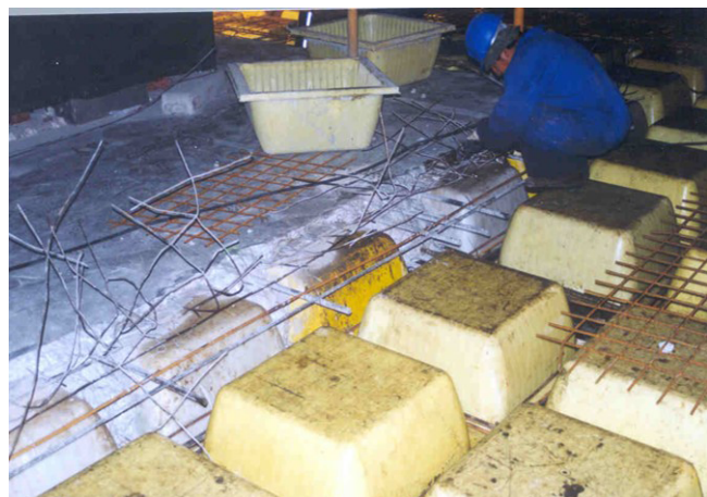
Figura 34. Aparcamiento P2. Encofrado y disposición de armadura de las zonas a reconstruir.
