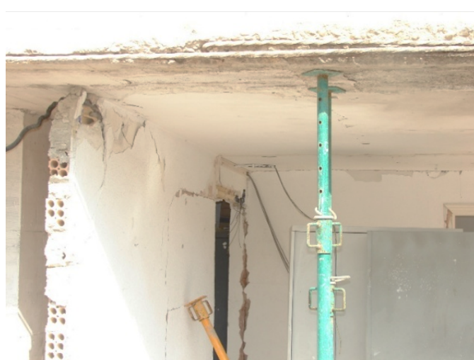
Desconchones en el hormigón.
