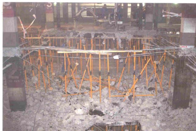
Figura 32. Aparcamiento P2. Proceso de demolición en la zona con daños irreversibles.
