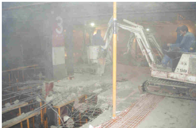
Figura 32. Aparcamiento P2. Proceso de demolición en la zona con daños irreversibles.
