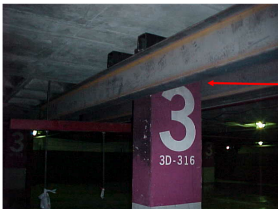
Figura 30. Aparcamiento P2. Apeo de los forjados de los pisos superiores en los que no se realizaban demoliciones.
