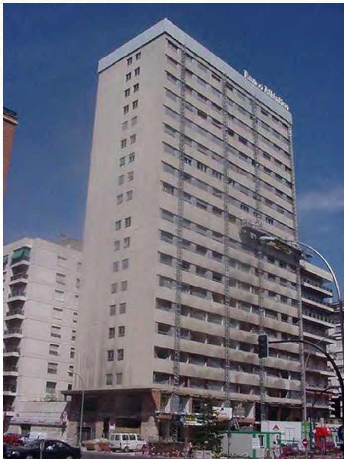
Figura 9. Fallo en los voladizos de un edificio por una explosión bajo ellos en planta baja (Edificio en la Gran Vía de Logroño, 2001).
