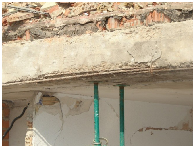
Desconchones en el hormigón.
