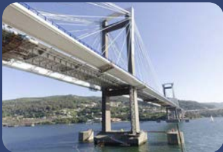
Ampliación del puente de Rande Pontevedra, España
