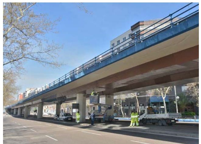
Figura 4. Perspectiva del tronco principal del viaducto, 13 de marzo de 2020 (foto de los autores).
