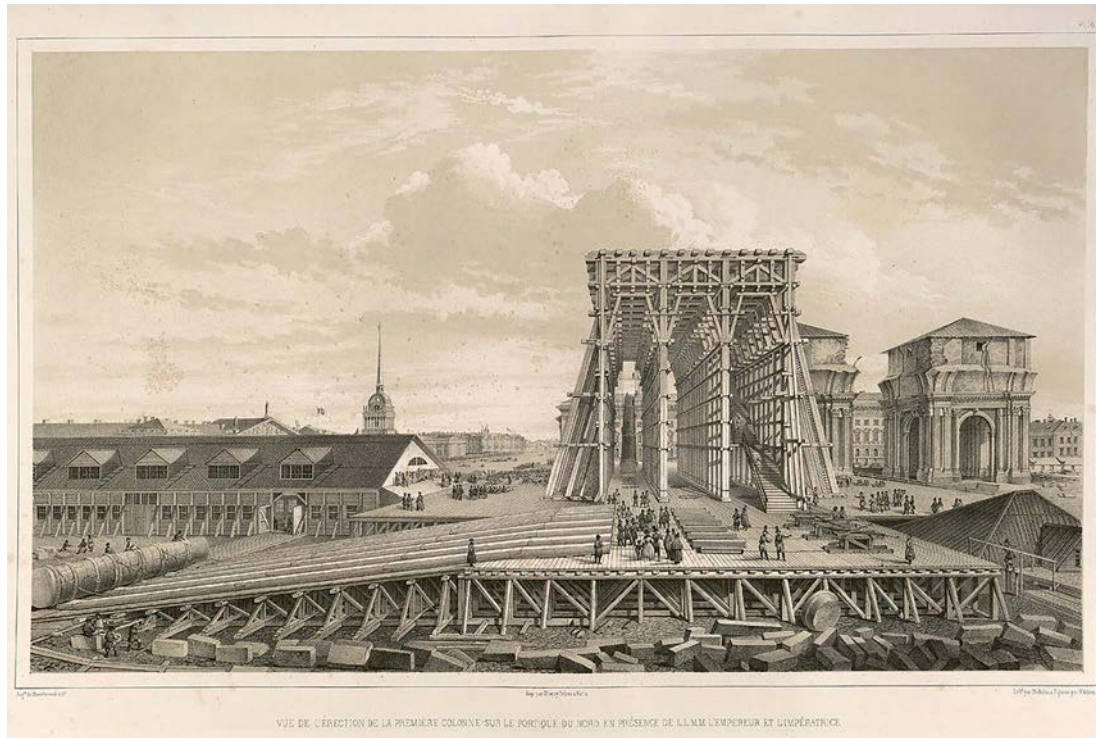
Figura 2. Vista de las operaciones de erección de la primera columna en un pórtico de la catedral de San Isaac en San Petersburgo. Colaboración del ingeniero Augustin de Betancourt con el arquitecto Auguste de Montferrand [1].
