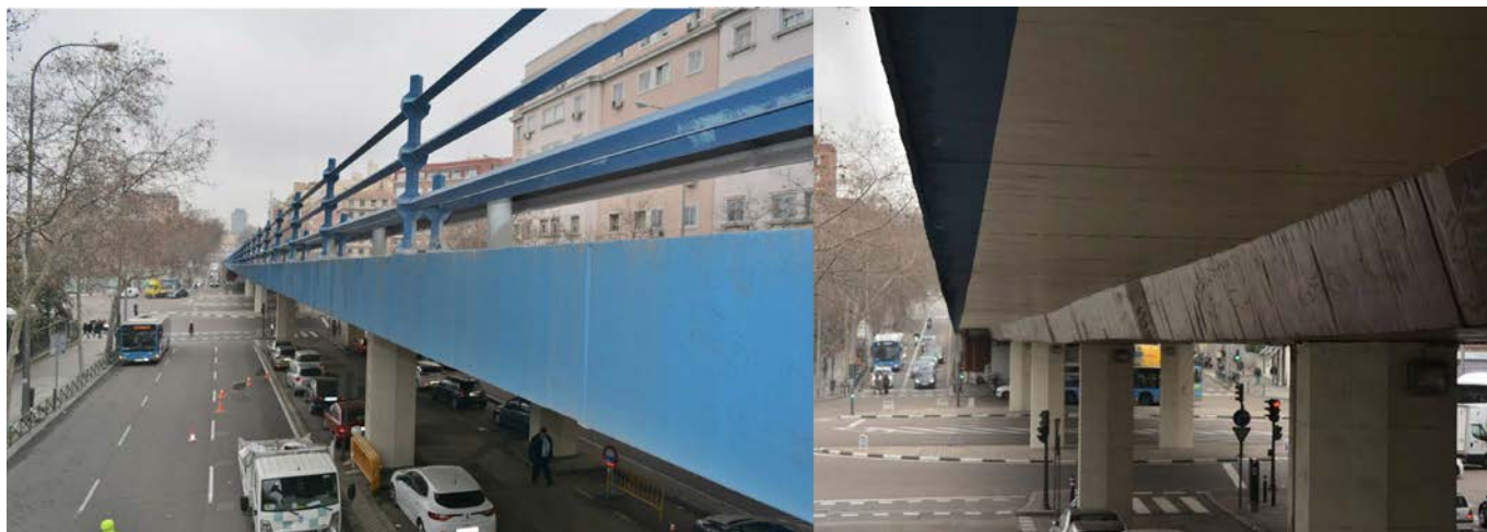
Figura 26. Correcta alineación de la estructura, sin flechas apreciables, o incluso aún con contraflecha. Fotos de los autores 12.02.2020.
