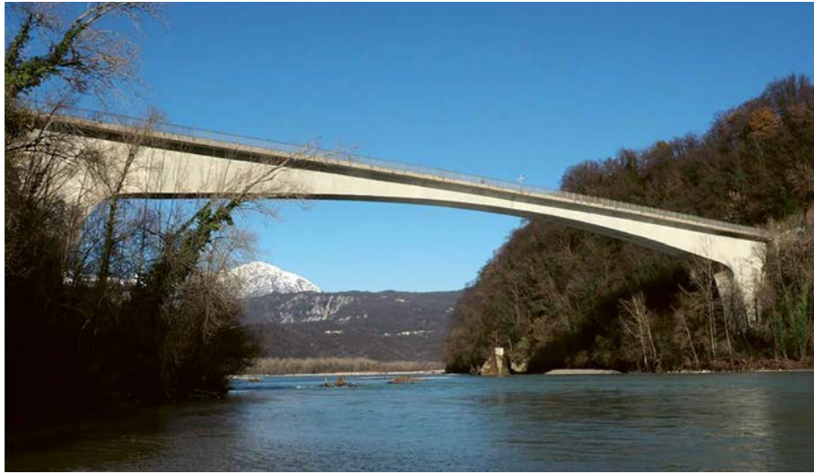
Figura 19 - Puente de Pinzano (1968-1969) (Reproducida de [37]).
