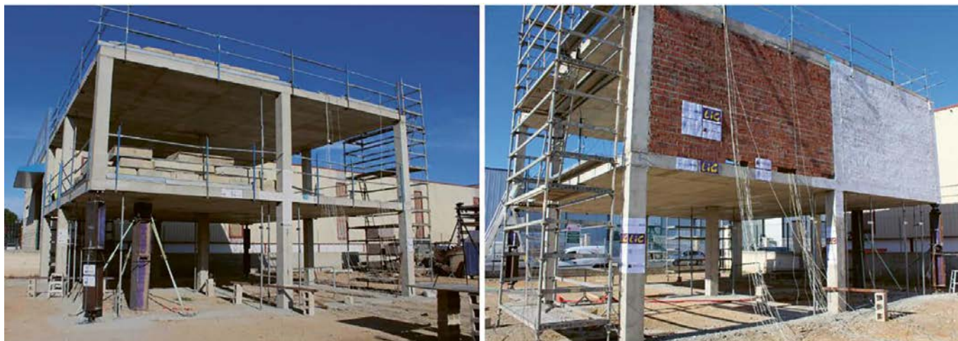
Figura 9. Fotos del edificio con el cerramiento de tabiquería ensayado con la financiación de la beca Leonardo.
