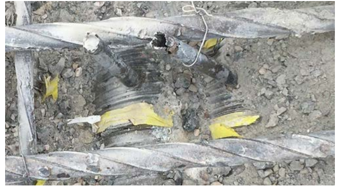
Figura 16. Vainas y tubos de purga sobre pila 6. Armadura pasiva estirada en frío, típica de la época (foto de los autores, 12.02.2020).
