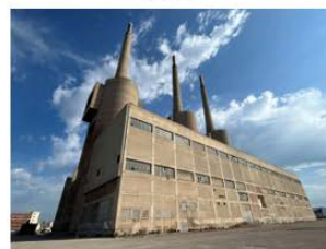
Chimeneas Central Térmica Sant Adrià del Besòs 2018
