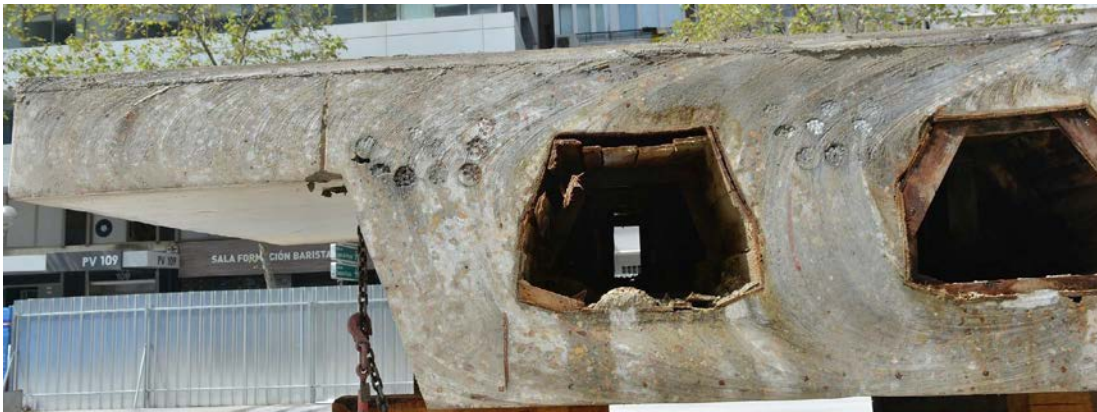
Figura 8. Sección de una de las dovelas cortadas, en el proceso de desmontaje, en las proximidades de un apoyo. La altura de los alvéolos es de apenas 0.55 m (el canto total de la sección, constante, es de 1.20 m, con una esbeltez de L/28.15 ) (foto de los autores).
