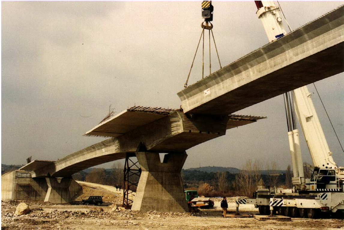
Figura 11. Construcción del Puente de Las Pilas sobre el río Cinca (Huesca).
