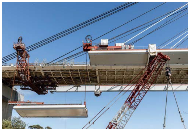
Figura 21. Dovela de la ampliación del tablero durante el izado. Puente de Rande ampliado.
