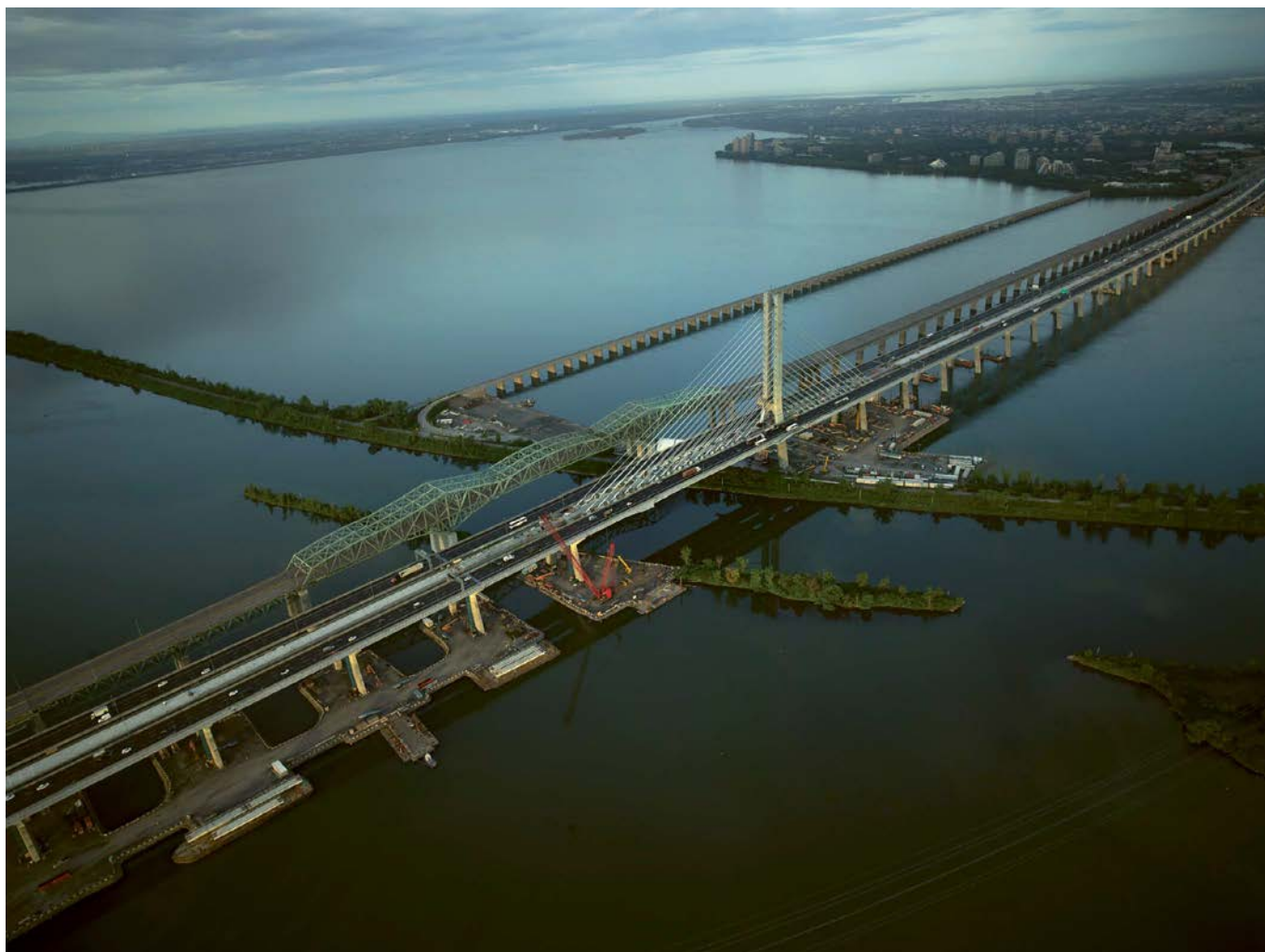
Figura 25. Nuevo Puente Samuel de Champlain. ©Thomas Heinser.
