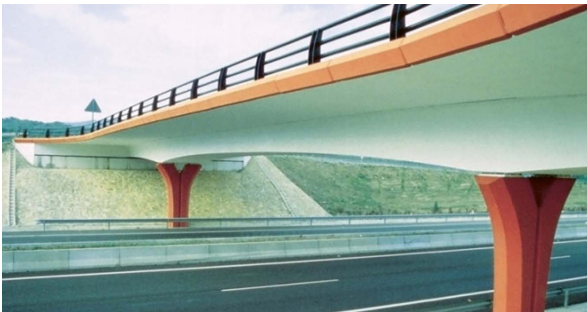
Figura 10. Paso superior prefabricado continuo en la Autovía A-10.
