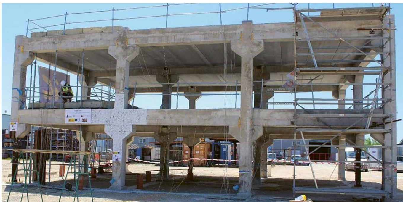
Figura 10. Foto de edificio de hormigón prefabricado ensayado con la financiación dentro del proyecto PREBUST [51].
