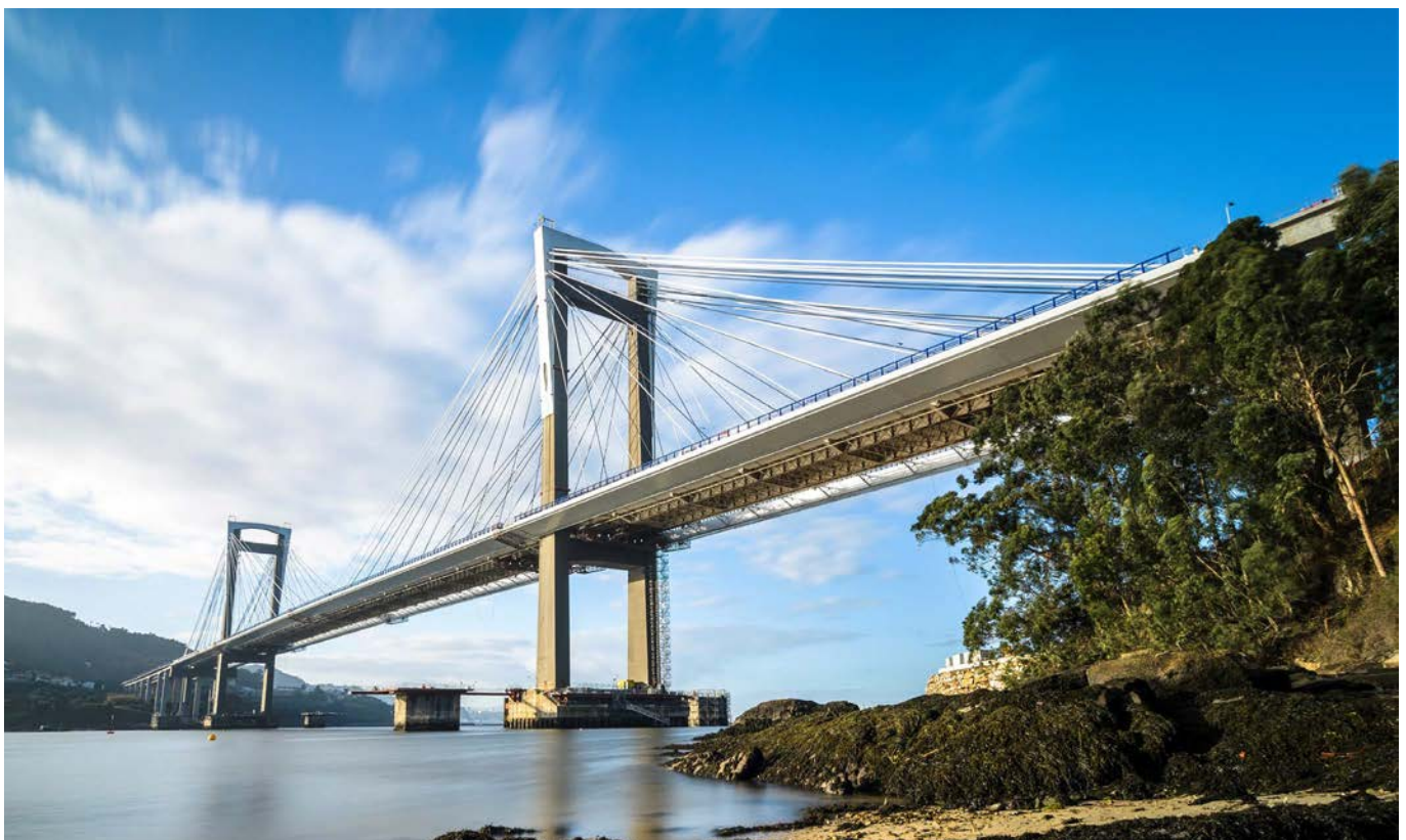
Figura 17. Puente de Rande ampliado.
