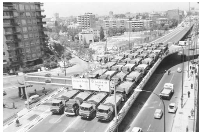
Figura 10. Prueba de carga del viaducto, 13 de mayo de 1970.
