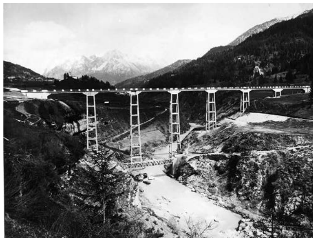
Figura 11 - Viaducto de Vallesella sobre el Piave (1949) (Reproducida de [28]).
