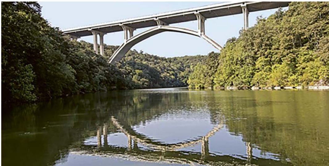
Figura 18 - Viaducto de Levane (1962-1963) (Reproducida de [34]).
