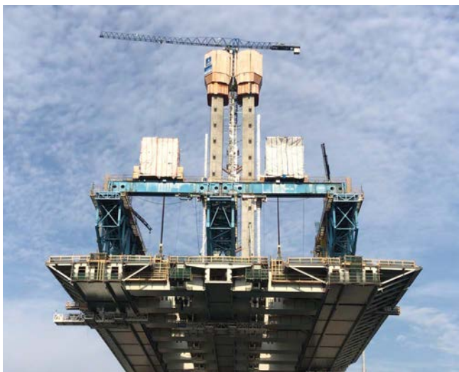
Figura 32. Vista frontal del tablero con el carro de izado de dovelas. Puente de Champlain.
