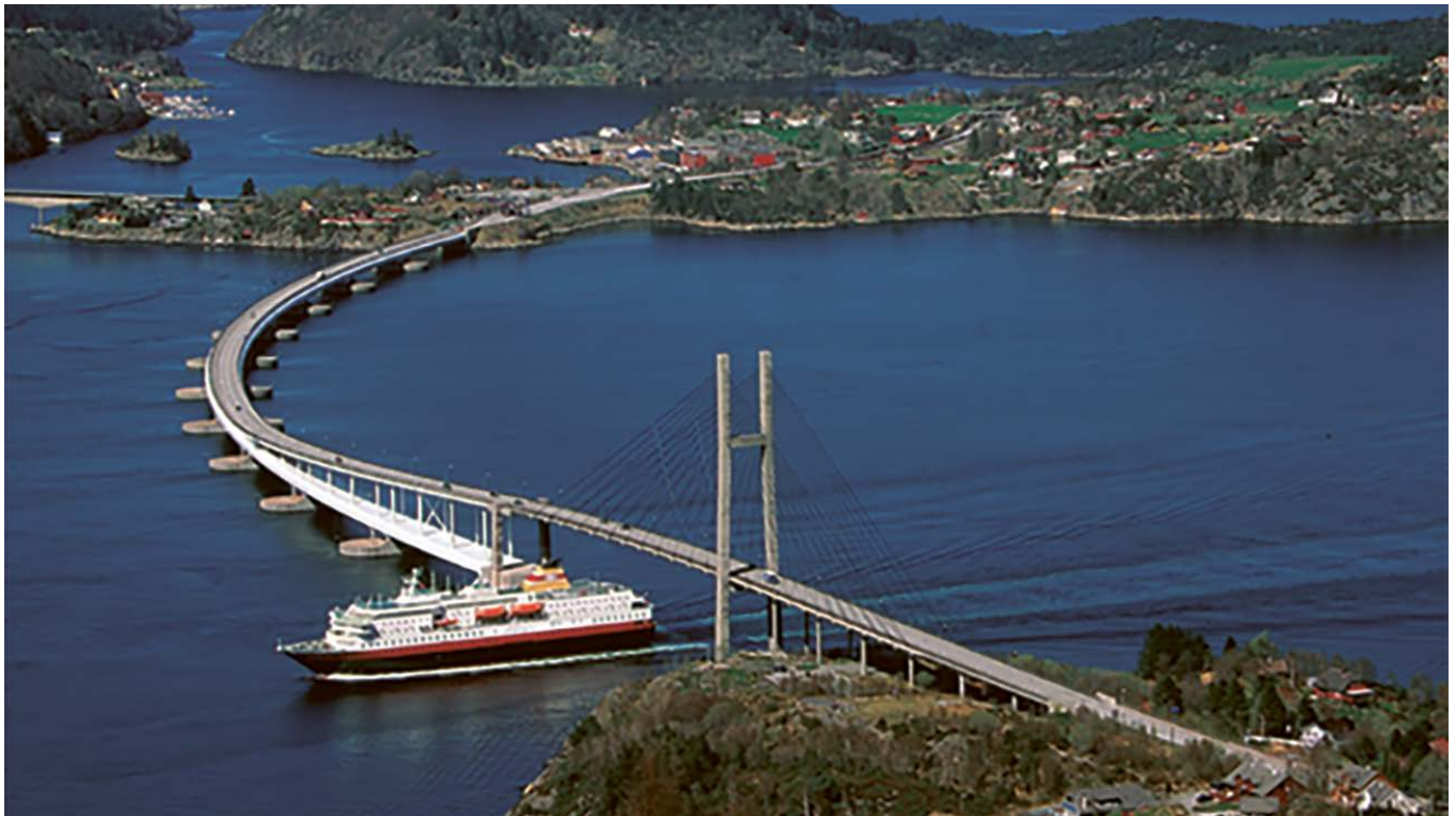
Figure 2. Nordhordland bridge – Aas Jakobsen.
