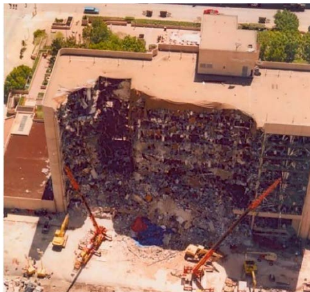
Figura 1. Edificio federal A.P. Murrah tras un ataque terrorista perpetrado con una furgoneta cargada de explosivos (Oklahoma, 1995) [2].
