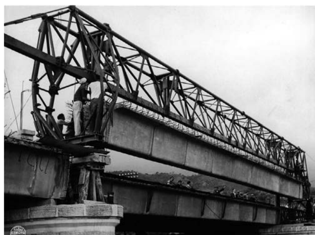
Figura 13 - Vigas cajón para los tableros de los viaductos Agrò y Fiumidinisi. (Reproducida de [31]).
