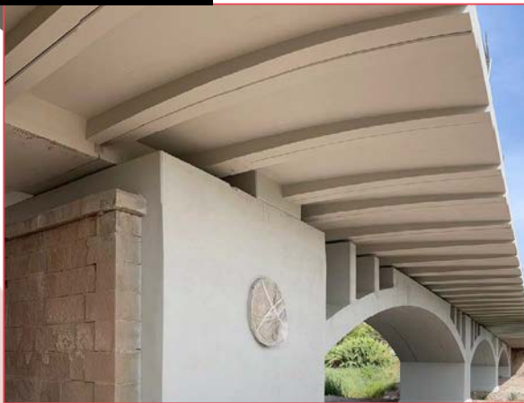
Prelosas de celosía para puentes monoviga y multiviga
