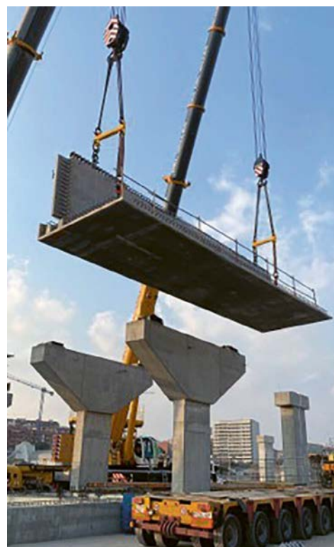
Figura 17. Imágenes de la colocación de semivigas para la construcción del entramado principal de cajones.
