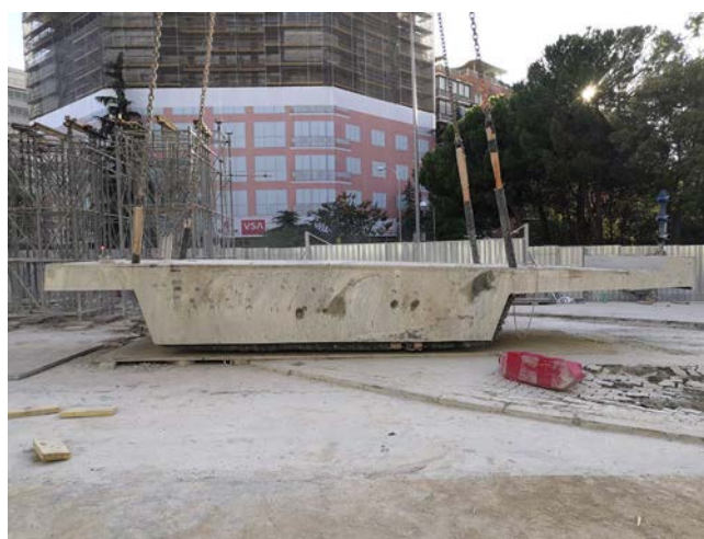
Figura 38. Sistemas de izado de piezas empleados: con balancines inferiores (izda.) y con eslinga de abrazo inferior (dcha.).
