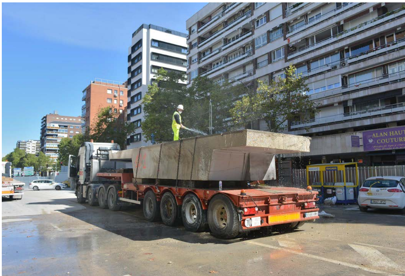
Figura 40. Transporte de pieza del tablero sobre plataforma.
