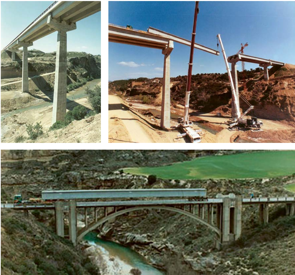
Figura 5. Imágenes del puente sobre el río Alcanadre (Huesca), 1989: vista inferior acabado, colocación de vigas del vano centra y paso del transporte de las vigas por el puente existente sobre el río Alcanadre.
