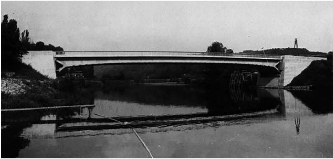
Figura 9. Puente de Luzancy sobre el Marne. Luz de 55 metros. 1945. (Reproducida de [7]).
