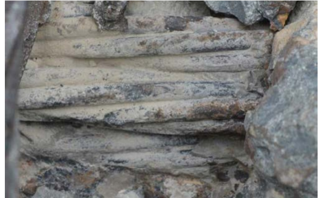
Figura 17. Calicata sobre pila 6. Foto de los autores, 12.02.2020.
