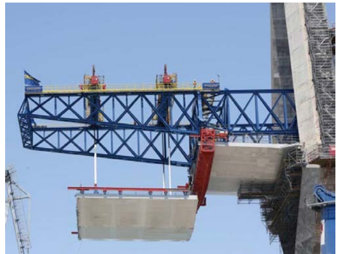
Figura 5. Izado de dovela tipo. Puente de la Constitución de 1812.
