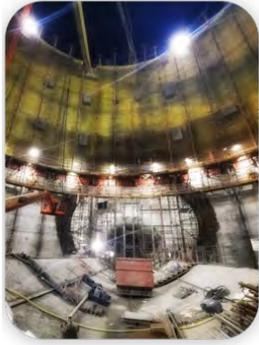
Figura 1. Fotografía del proceso de ejecución del deslizado.
