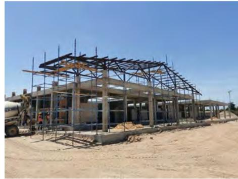
Figura 2. Montaje de la estructura metálica de cubierta.
