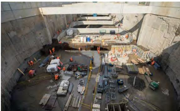
Figura 1. Foto de obra durante el ferrallado y encofrado del último de los puntales intermedios y a mitad del proceso de excavación. Foto cortesía de HS2.
