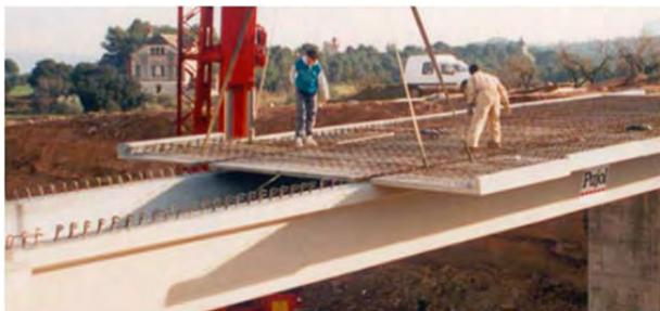
Figura 1. Puente de vigas pretensadas prefabricadas y losa superior de Hormigón armado (cortesía de ALVIPRE).
