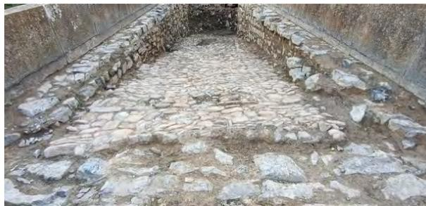
Figura 2. Vista del primitivo pavimento descubierto al realizar el vaciado previo al ensillado.
