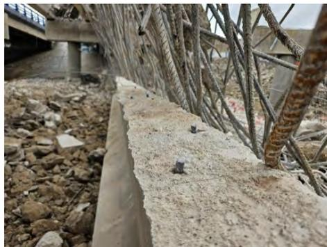
Figura 2. Detalle de la junta fría, durante los trabajos de demolición de uno de los tableros.
