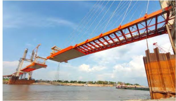
Figura 2. Vista inferior del tramo central atirantado durante el proceso de montaje.
