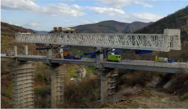
Figura 1. Lanzador de vigas empleado para el desmontaje y posterior reconstrucción del viaducto.
