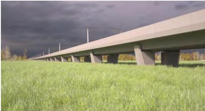
Figura 1. Alzado del viaducto como sucesión de vanos cortos.
