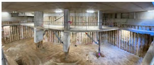
Figura 2. Vista de bajo rasante. Excavación hasta nivel 3 (sótano -2), arriostramientos provisionales de micropilotes de 35 cm y hormigonado del tramo superior de los pilares de H.A. 19.01.22.
