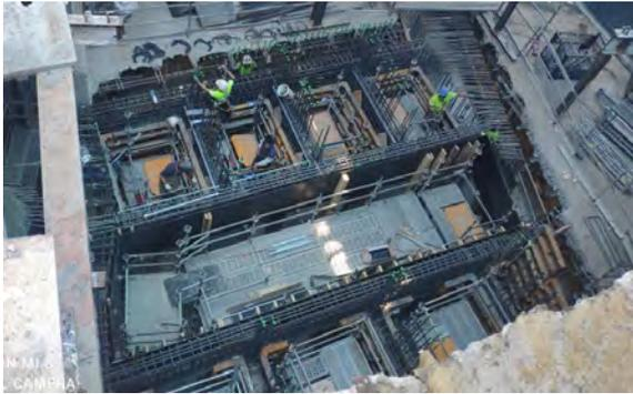
Figura 1. Cimentación flotante del núcleo de ascensores.
