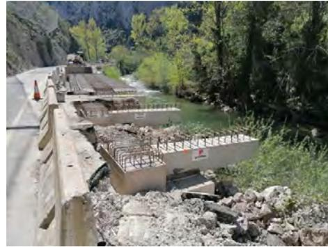
Figura 2. Costillas en estructura de voladizos sucesivos.
