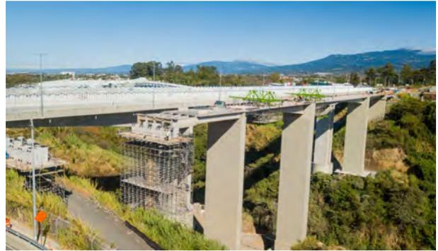
Figura 2. Vista aérea durante los trabajos de ensanche y refuerzo.
