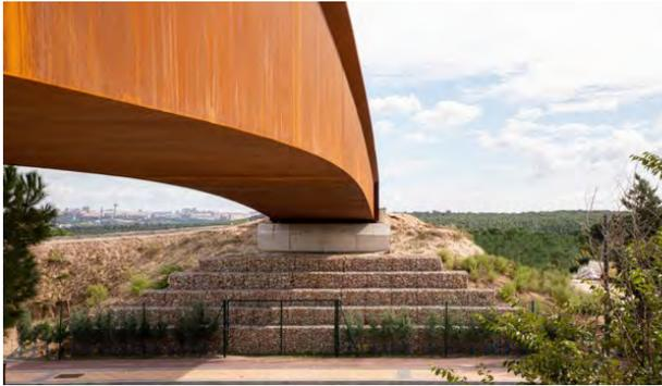
Figura 1. Estribo izquierdo sobre muros de gaviones.
