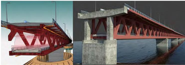
Figura 1. Puente sobre el río Daugava, Riga, Letonia. Celosía metálica, tablero doble de carretera y ferrocarril. Longitud 1150 m, 8 vanos de 125+6x150+125 m.
