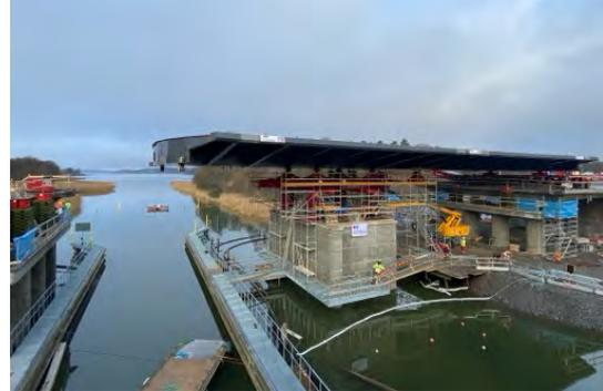
Figura 2. Lanzamiento del tablero metálico.
