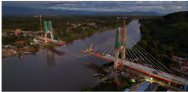
Figura 1. Construcción del Puente Huallaga por avance en voladizo simétrico del vano principal.
