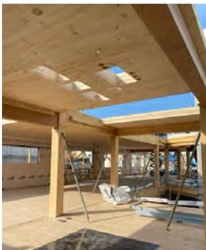
Figura 1. Estructura de madera laminada (pilares, vigas y forjado).
