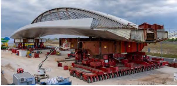
Figura 1. Situación previa al traslado del bowstring, con los SPMTS tomando la carga en campa.
