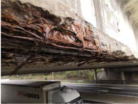
Figura 1. Vista inferior del vano principal con armadura activa con fuertes corrosiones.
