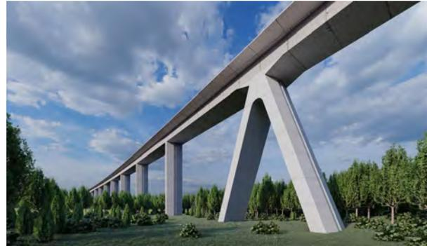
Figura 2. Pila en A sobre P-15 junto con secuencia de vanos de 45 en zona de llanura de inundación.
