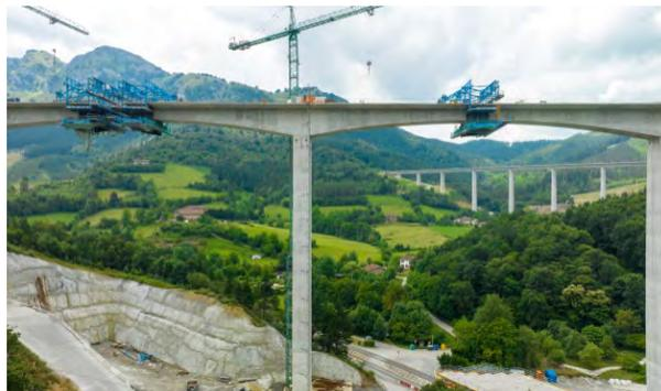
Figura 2. Viaducto de Zumelegui. Ejecución de dovelas de cierre.
