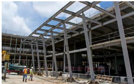
Figura 2. Vista de la estructura metálica. Uniones atornilladas en obra.
