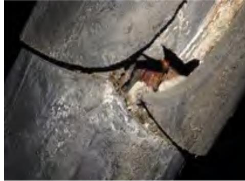
Figura 2. Detalle del tirante afectado.
