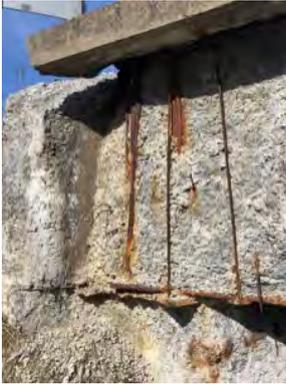
Figura 1. Degradación del hormigón en nervio de losa en zona de apoyo. Pérdida de importantes volúmenes de hormigón en estribo. Corrosión de armaduras. Estructura del PK 88+980.
