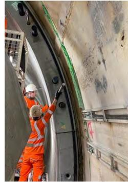
Figura 2. Inserción de los pasadores a cortante y las barras pretesas en los puntos de conexión de las dovelas especiales.
