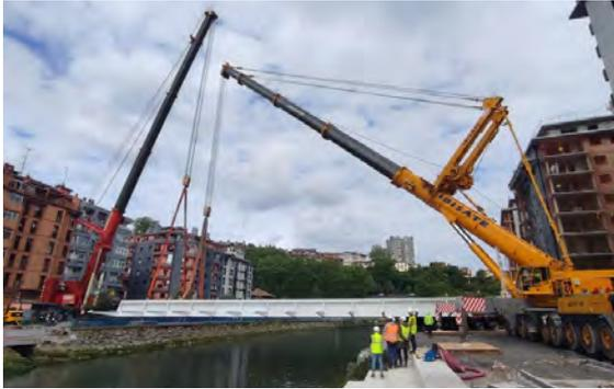
Figura 1. Foto del lanzamiento del tablero con la grúa de la margen derecha y fijación con la grúa de la margen izquierda.
