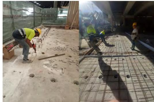
Figura 2. Vista del refuerzo desde arriba: instalación de conectores sobre los perfiles metálicos de refuerzo y colocación de armadura de la nueva capa de compresión.
