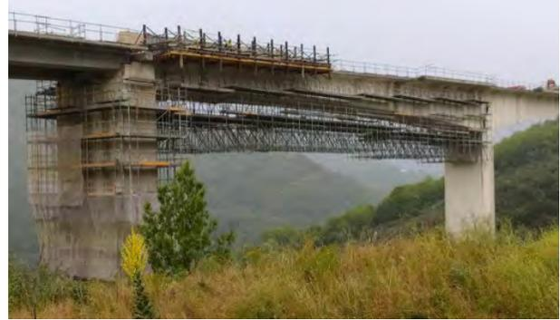
Figura 2. Corte del voladizo, carro de alas, andamio para recrecido de pilas y andamio colgado para reparaciones en tramo central del viaducto.
