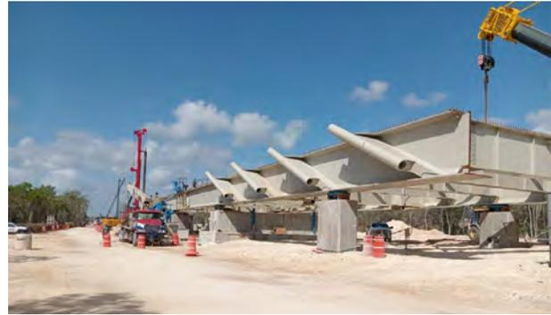
Figura 2. Preparación de la maniobra de empuje, montaje del tablero.
