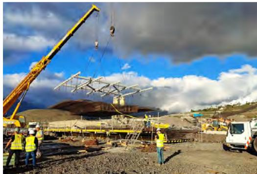
Figura 2. Módulo de ferralla prefabricada de tablero, 12 m longitud, ancho completo.
