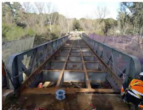
Figura 2. Aspecto del tablero tras la retirada de la plataforma original de perfiles omega.
