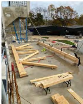
Figura 2. Montaje de la viga en celosía prefabricada.
