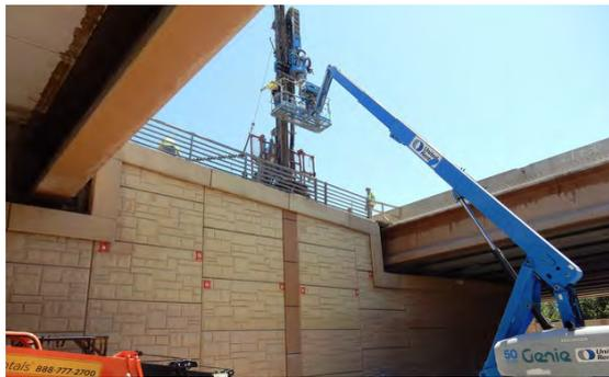
Figura 2. Ejecución de micropilotes tras muro de tierra armada existente en uno de los puentes a ampliar.
