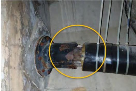
Figura 1. Falta de inyección de lechada en un tendón de pretensado no adherente.
