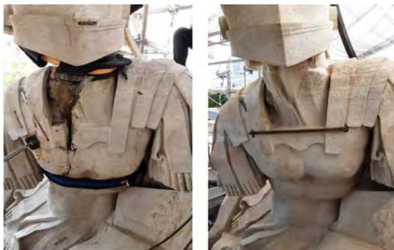
Figura 1. Reparación y cosido de fisuras en el grupo escultórico 2.
