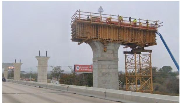
Figura 2. Construcción del cabezal de una de las pilas excéntricas con fuste postesado.
