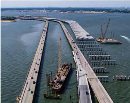
Figura 1. Colocación de vigas.
