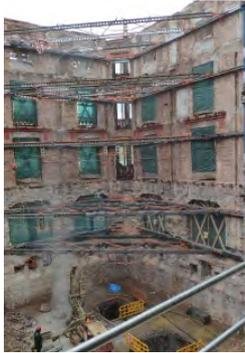
Figura 1. Estabilización interior.
