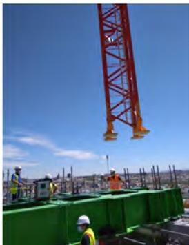
Figura 1. Vista del montaje del mástil de la grúa sobre la bancada en coronación del núcleo.
