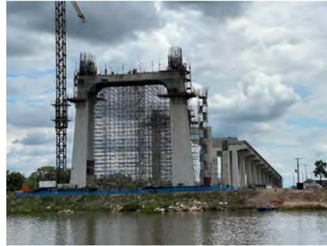
Figura 2. Viaducto de Zumelegui. Ejecución de dovelas de cierre.
