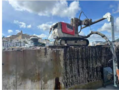
Figura 2. Vista de un robot de hidrodemolición sobre orugas de tipo autopropulsado.
