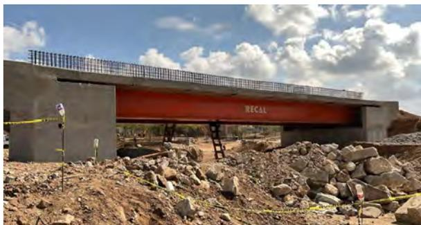
Figura 1. Alzado de puente de 21m en construcción.
