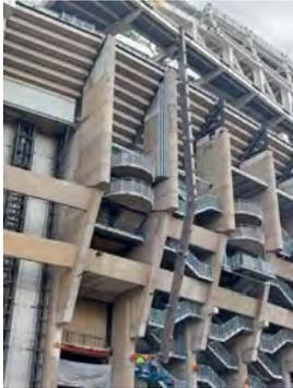
Figura 1. Detalle de apoyo de costillas de fondo en puntales provisionales.
