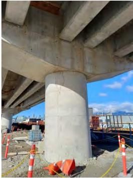
Figura 1. Detalles de pilas intermedias en continuidad con el tablero.
