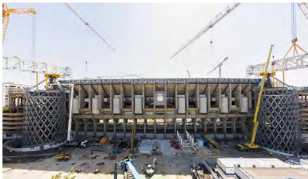
Figura 1. Estructura metálica de torres montada para dar apoyo a la cubierta.
