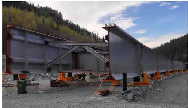
Figura 2. Tablero del K62 en el parque de prearmado.
