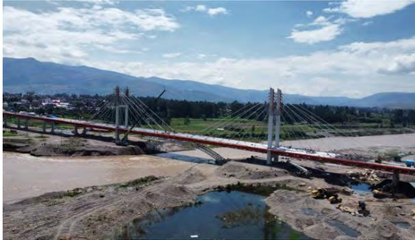
Figura 1. Vista general con todos los tirantes instalados.
