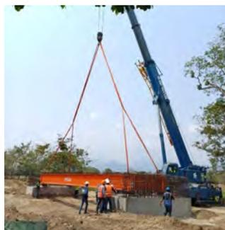
Figura 2. Izado y colocación de tablero metálico de puente isostático de 15m.
