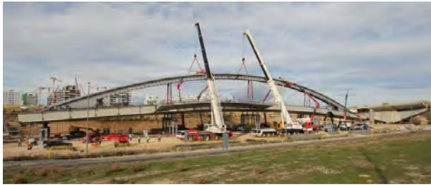
Figura 1. Instalación del diagrid en campa con tablero y arco ya ensamblados sobre bancadas de apeo.
