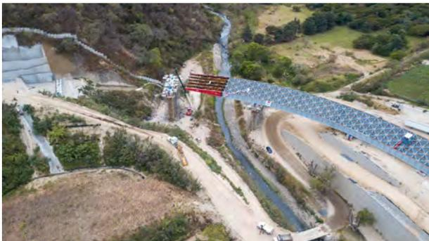
Figura 1. Vista de fase intermedia de lanzamiento.
