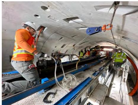
Figura 2. Enfilado de las dovelas con cabestrante.
