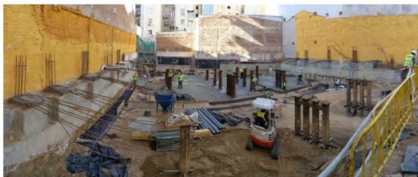
Figura 1. Vista de la pantalla de pilotes discontinua, de la viga de coronación, de las ménsulas de transferencia de cargas en la medianería del edificio.
