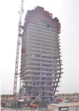
Figura 1. Desvíos de columnas en CFC.
