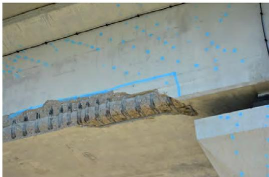
Figura 1. Vista inferior de una de las vigas afectada por la junta fría entre alma y losa inferior con distorsión de los cercos de cortante.
