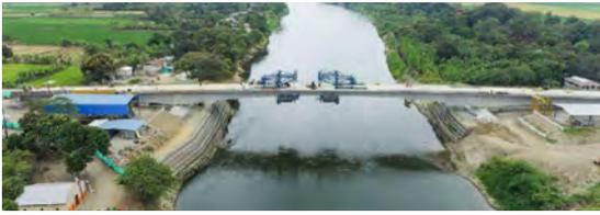
Figura 1. Finalización de la construcción del Puente Colimes con la ejecución del cierre del vano principal.
