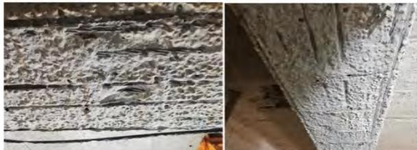
Figura 1. Cara inferior de viga V1-100 con afectación de armadura pasiva y activa.
