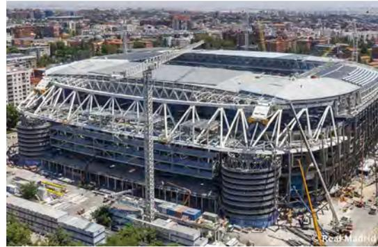
Figura 2. Construcción de forjados de la Corona.
