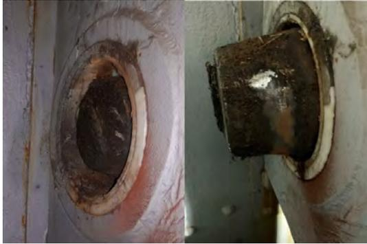
Figura 1. Posición del bulón de aguas abajo antes y después de la actuación.
