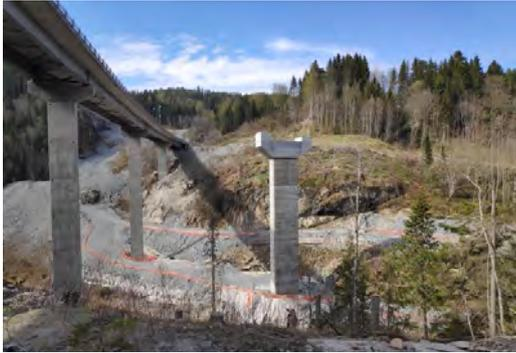
Figura 1. Imagen de la pila más alta del viaducto E62 y del viaducto existente adyacente.
