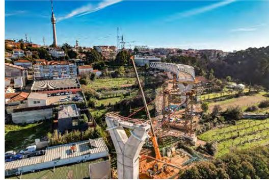
Figura 2. Vista general de la construcción del puente. Se aprecian las construcciones que impedían el montaje por tramos especificado en proyecto.
