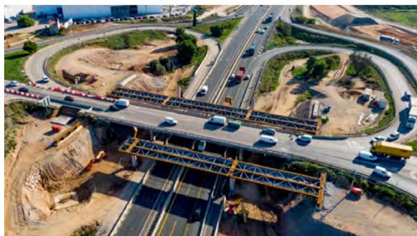
Figura 2. Vista aérea de la construcción de dos pasos superiores de tres vanos.
