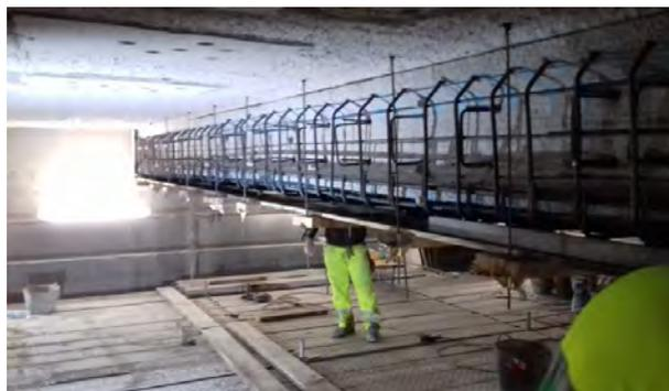
Figura 2. Adición de nueva armadura.
