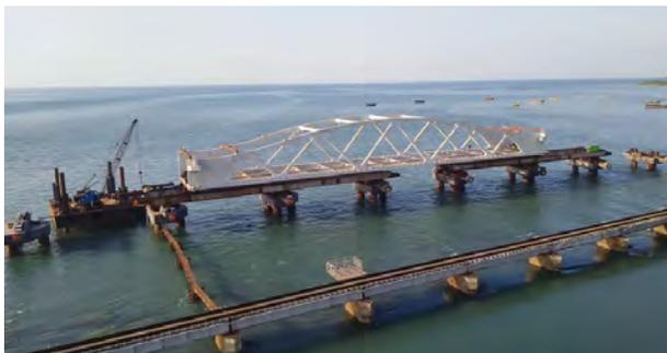
Figura 1. Lanzamiento acompasado del tablero móvil.
