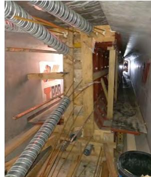
Figura 2. Vista inferior del encofrado con las vainas de pretensado y esperas de acero pasivo.
