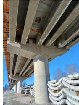
Figura 2. Pilas extremas bajo junta de expansión.
