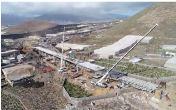
Figura 1. Ejecución tablero vanos 7 y 8.
