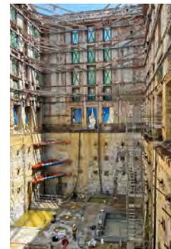
Figura 3. Vista exterior general con estabilización de fachadas.
