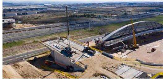
Figura 2. Vista general de la construcción del puente. Ambos arranques ejecutados y montaje de tramo central en campa.
