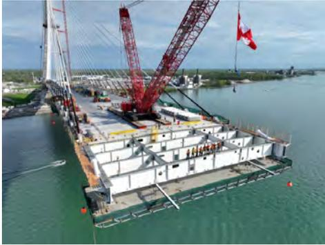
Figura 1. Vigas del tablero.
