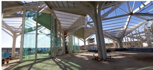
Figura 2. Interior del intercambiador. Árboles, cerchas, cubierta y cerramiento de vidrio.
