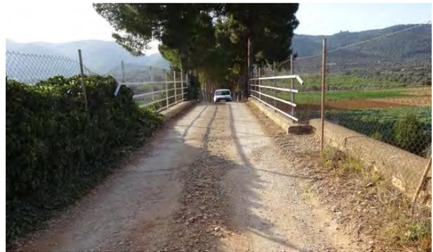
Figura 2. Casuística habitual de camino rural que salva una línea ferroviaria en el que es preciso la implantación de un sistema de contención y cerramiento de protección antivandálico.
