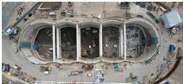
Figura 2. Vista aérea del Caterpillar completamente excavado y con la losa de la primera burbuja ya ejecutada. Foto cortesía de HS2.
