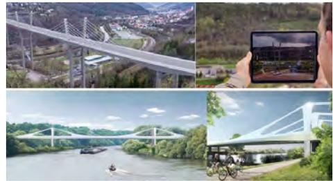
Figura 2. Superior Puente de Horb, inferior Mainflingen, Alemania. Puentes extradosdos de carretera. Longitud 667 m, 6 vanos de 61+115+2x157.5+115+61 m y Longitud 450 m, 7 vanos de 40+3x50+62.5+135+62.5 m respectivamente.
