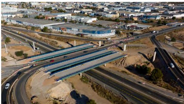
Figura 1. Vista aérea de tres pasos superiores de tres vanos construidos y pilas del ramal de conexión de 10 vanos.
