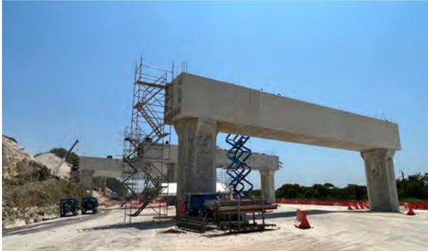
Figura 1. Pórticos del Viaducto VDT 4044.1 durante la ejecución del Viaducto.
