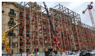
Figura 2. Vista exterior general con estabilización de fachadas.
