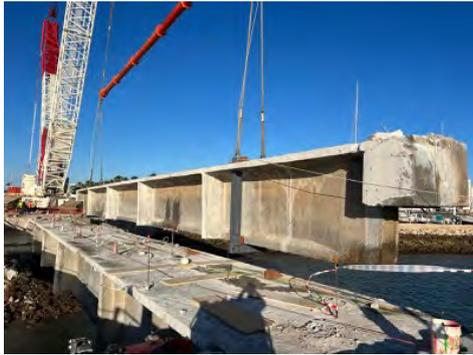
Figura 1. Izado de una de las vigas completas.
