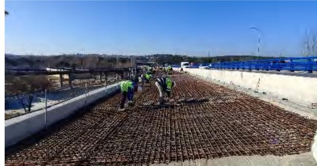
Figura 2. Reparación de la losa superior.
