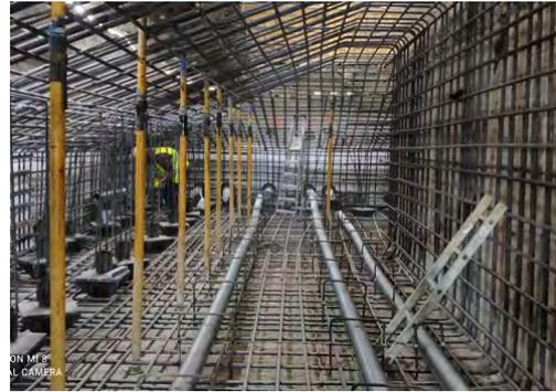
Figura 2. Refuerzo de la zapata.
