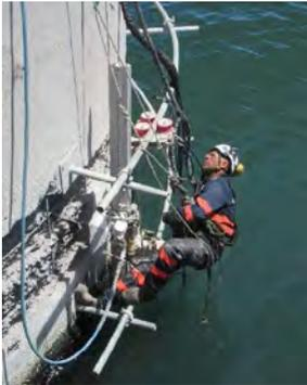
Figura 1. Acceso por cuerdas para fijación de equipos robotizados de hidrodemolición.
