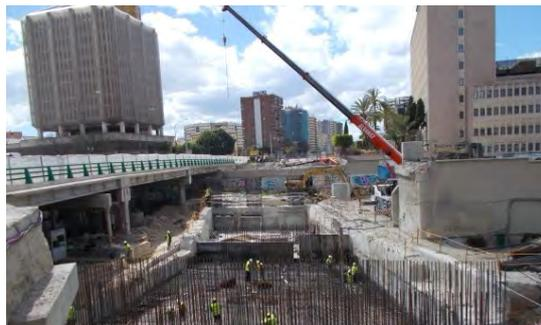
Figura 2. Construcción de estribos y pilas del puente sobre losa de cubierta y pantallas del Metro.
