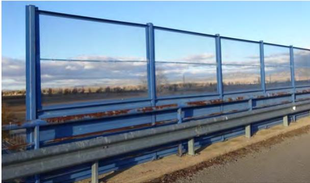
Figura 1. Casuística habitual de cerramiento de protección antivandálico colocado detrás de pretil existente sin espacio para la deformación en caso de impacto.
