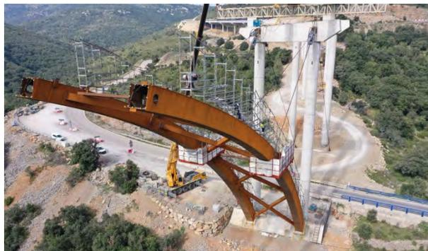
Figura 1. Montaje de los arcos sobre el Barranco de la Bota.
