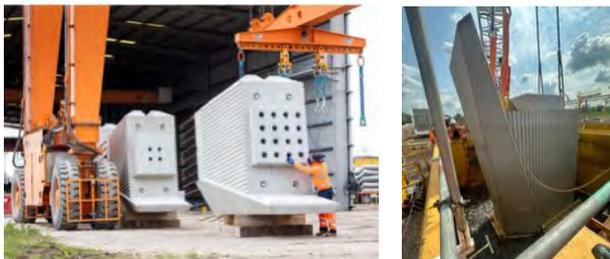
Figura 1. TVV. Salida de fustes prefabricados de fábrica (izquierda). Izado y conexión con encepado (derecha).
