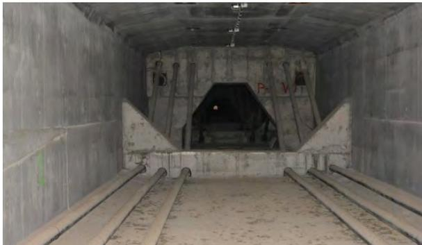
Figura 1. Interior del cajón, en el que se aprecian los tendones de pretensado exterior intradosado y los desviadores correspondientes.
