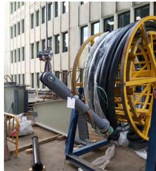
Figura 2. Detalle tirante prefabricado.
