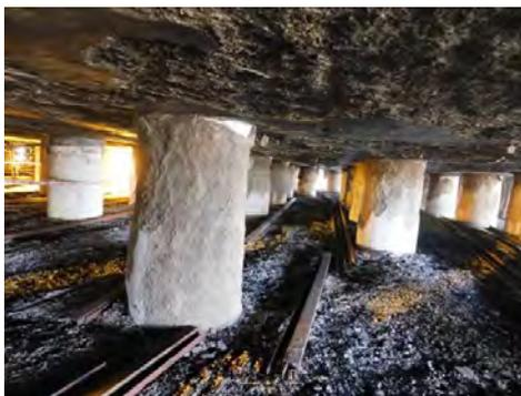
Figura 1. Ejemplo de los daños provocados por el fuego en la estructura.
