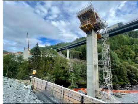
Figura 2. Fotografía de la construcción de las pilas con la distribución de trepas.
