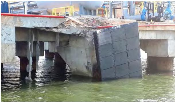
Figura 1. Estado de la plataforma tras el impacto del Sino Star.
