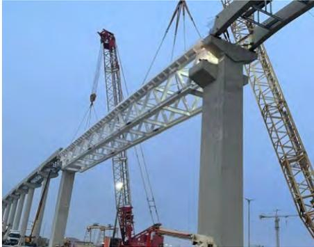
Figura 1. Montaje de la celosía de 70 m de luz.
