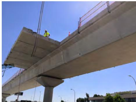
Figura 2. Demolición del tablero original con piezas cortadas con hilo de diamante.
