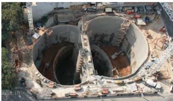
Figura 1. Vista aérea de la Estación de São Joaquim en fase de ejecución del pozo de alargamiento y demolición del pozo de ataque.
