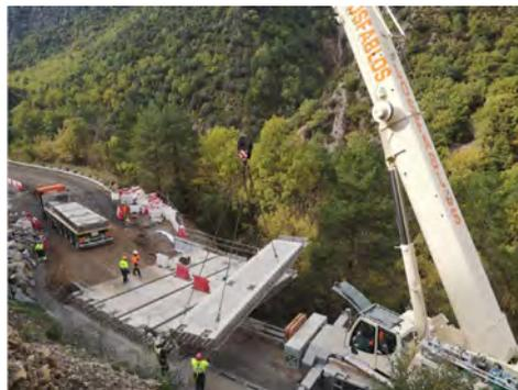
Figura 2. Instalación de placa prefabricada de voladizo.
