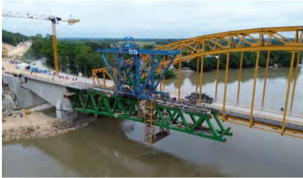
Figura 1. Transporte de dovelas con el carro de izado móvil por encima de la celosía.
