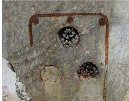
Figura 2. Ejemplo de tablero de puente seccionado en donde se ven diferentes defectos de inyección de los tendones del pretensado.
