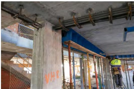
Figura 1. Vista general de refuerzo frente a esfuerzo cortante.
