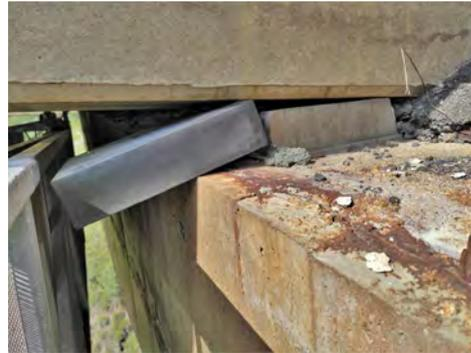
Figura 2. Aparato de apoyo escupido.
