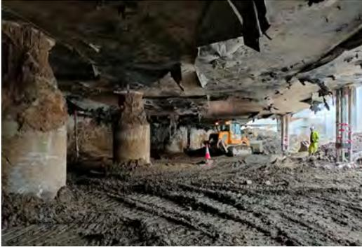
Figura 1. Vaciado de la estación durante la excavación en mina.
