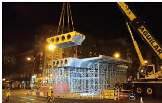
Figura 2. Detalle de la demolición. Retirada de una pieza de núcleo tablero.
