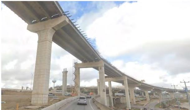
Figura 1. Diversas tipologías de pilas empleadas: "hammerheads" y "straddle bents".
