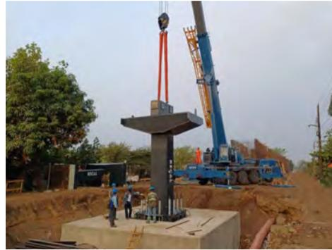
Figura 2. Izado y colocación de pila metálica del viaducto.
