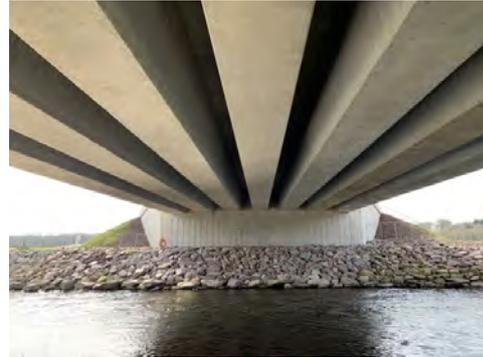
Figura 2. Vista inferior de un viaducto integral en Irlanda.
