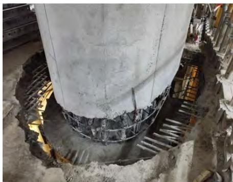
Figura 2. Vista fase provisional recrado pilar para arranque del nuevo núcleo.
