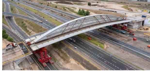
Figura 2. Situación final del traslado. Descarga de la estructura sobre apoyos de arranques.
