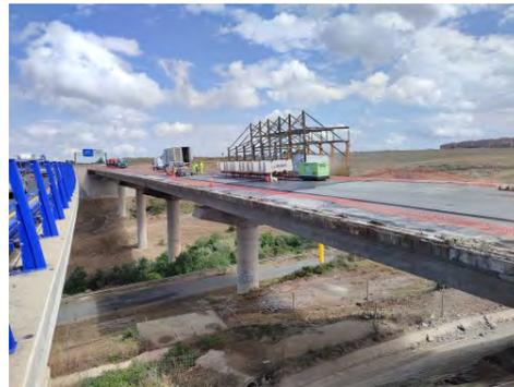
Figura 2. Hidrodemolición y carro de demolición en carro de tablero.
