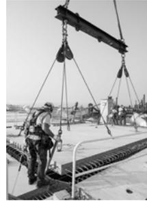
Figura 2. Instalación de panel en obra.
