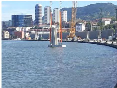
Figura 2. Montaje de los muros prefabricados de contrafuertes con cimentación integrada.
