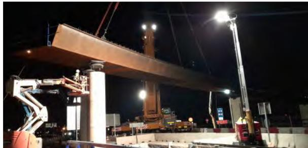
Figura 2. Izado de un tramo de cajón de la E13 durante un corte nocturno de tráfico.
