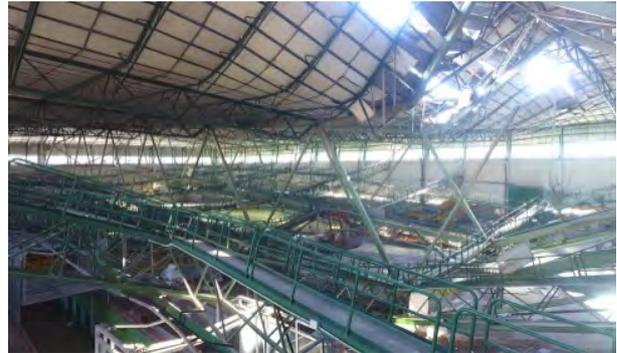
Figura 2. Vista interior del colapso.
