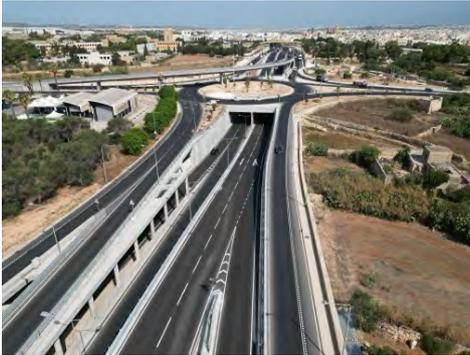
Figura 1. Intersección con paso inferior de cuatro carriles, paso superior y pérgola en la glorieta de acceso al aeropuerto de Malta.
