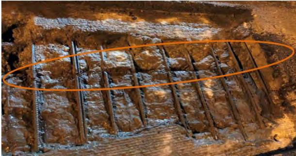
Figura 1. Armaduras rotas/seccionadas.
