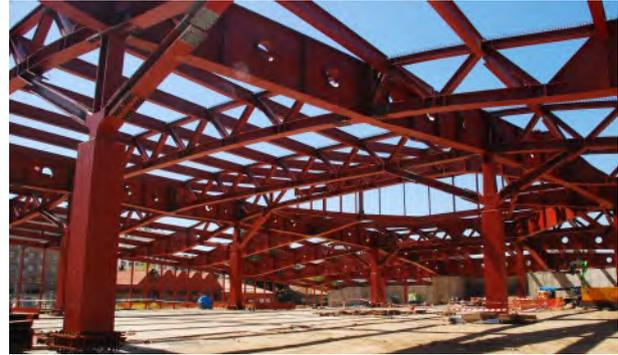
Figura 2. Detalle de la estructura (antes de instalar la chapa grecada).
