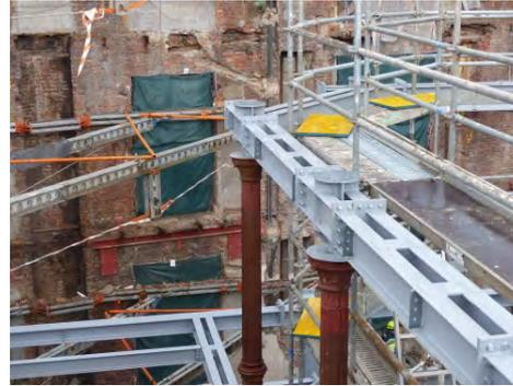
Figura 2. Ejecución de la estructura metálica.
