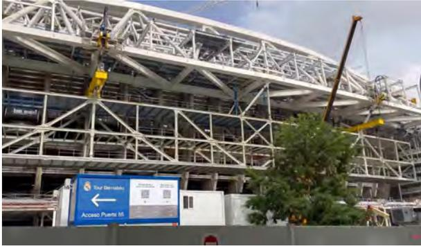
Figura 1. Izado de la Viga Museo con operación de Heavy lifting desde la Viga Corona.
