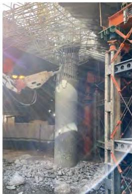
Figura 1. Pila a desplazar en paso elevado. Fuente FCCCO.
