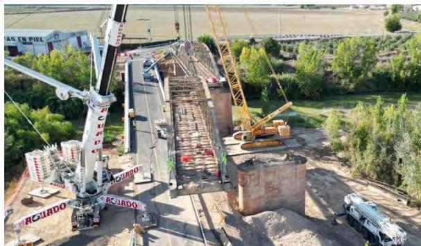
Figura 2. Transporte de tramo metálico a plataforma de trabajos.
