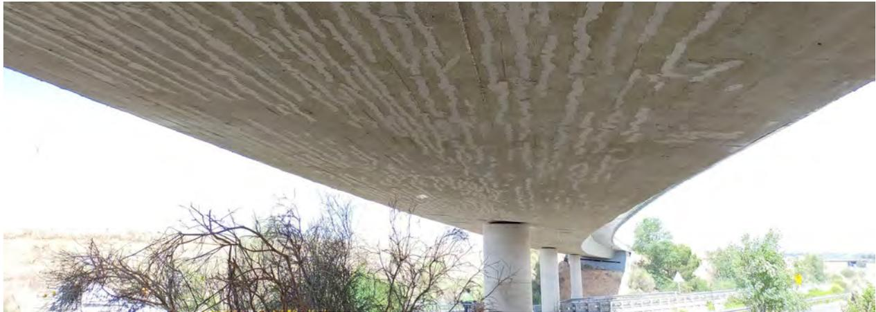
Figura 1. Fisuración longitudinal masiva de losa de hormigón postesado (fisuras inyectadas y selladas).
