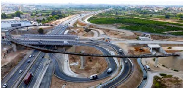
Figura 1. Vista aérea nudo V30: estructuras E10, E11 y E12, y estructura E13 en construcción.
