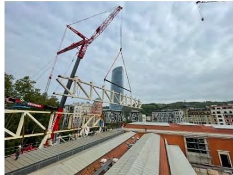
Figura 2. Montaje de la celosía transversal cargadero sobre una alineación de soportes en V.
