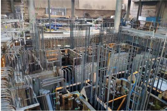
Figura 1. Arranque de núcleo de ascensores.
