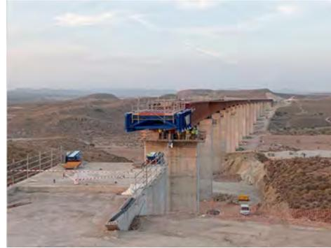
Figura 2. Vista general del Viaducto de Los Feos durante su lanzamiento.
