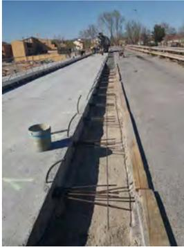
Figura 1. Vista superior de ampliación de acera en voladizo con prelosa provista de tendones de postesado.
