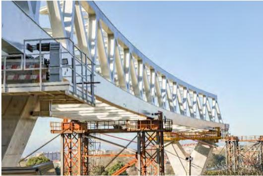
Figura 1. Detalle de empuje de la estructura sobre pilas definitivas y torres temporales.
