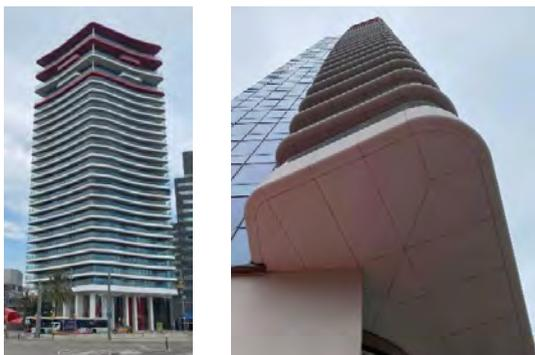
Figura 1. Paneles de antepecho y techo del caso de estudio; (a) vista general del edificio (b) vista detallada.
