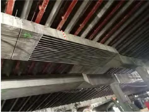
Figura 1. Vista del refuerzo desde abajo: refuerzo de fibras en viga y perfiles metálicos en placas pi.
