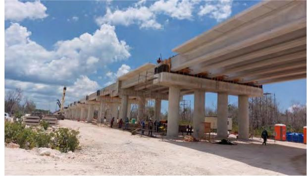
Figura 2. Sucesión de módulos tipo zona altura máxima, durante la ejecución del Viaducto.
