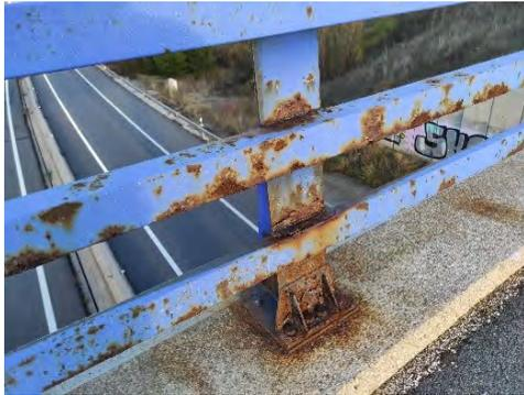
Figura 1. Oxidación de postes y elementos de fijación de pretil metálico.
