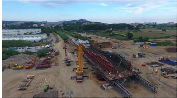
Figura 2. Montaje de ferralla durante la construcción del vano 2.
