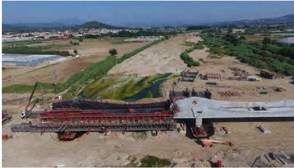
Figura 1. Construcción del vano 4 sobre cimbra autolanzable.
