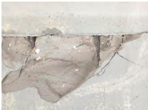
Figura 1. Detalle del deslizamiento ocurrido en una junta fría del alma de una de las vigas de uno de los tableros.
