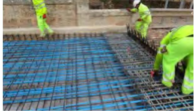
Figura 2. Ferrallado y disposición de postesado en la losa.
