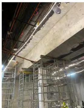
Figura 2. Imagen de las dos vigas pretensadas antes de la demolición del pilar.
