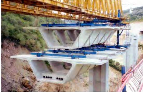
Figura 1. Proceso de montaje de dovelas.
