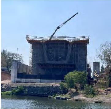
Figura 1. Ejecución de la dovela 0.
