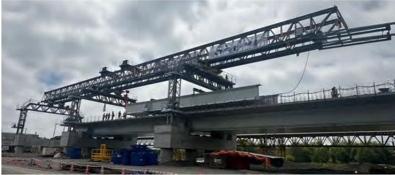
Figura 1. Montaje de tramo de cajón metálico con lanzavigas.
