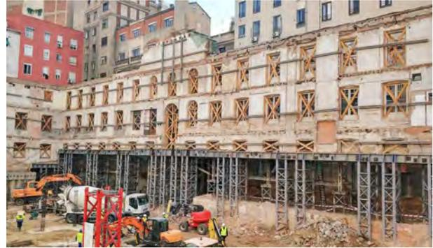
Figura 2. Imagen de las obras del interior del edificio Cuesta de San Vicente, 28 tras demoler su estructura interior y apeo la fachada.
