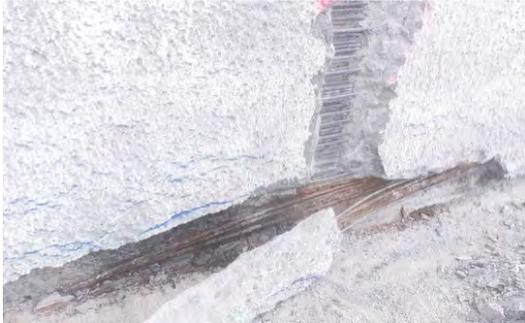
Figura 1. Daños en el pretensado existente Preload y cata para medición de alambres.
