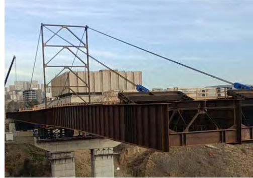
Figura 2. Torre de tirante provisional puente Bagebi.
