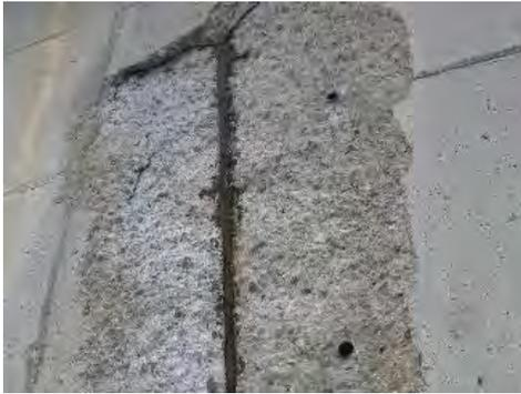
Figura 1. Falta de recubrimiento.
