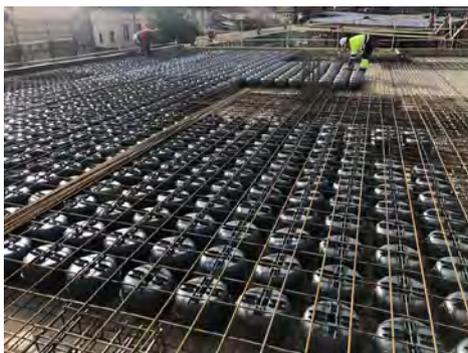
Figura 1. Losa aligerada biaxial "Unidome".
