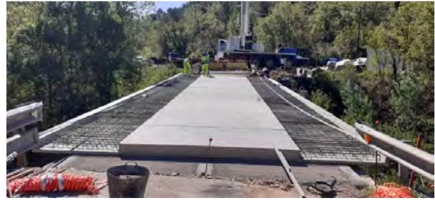
Figura 2. Prelosas con zona central prefabricada para agilizar la reapertura del tráfico.
