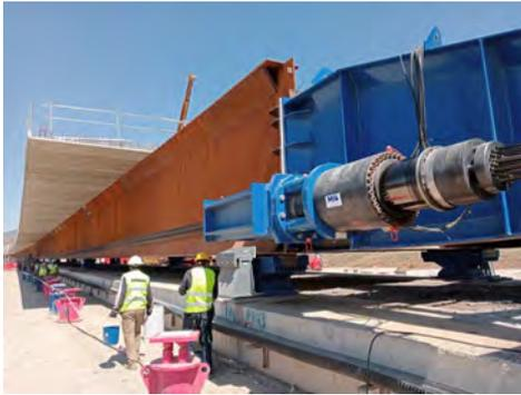
Figura 1. Equipos hidráulicos de empuje.
