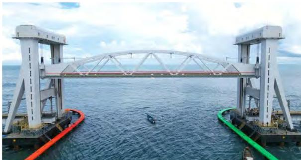
Figura 2. Maniobra de elevación durante la inspección principal para la recepción de la obra.
