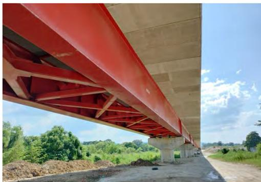
Figura 1. Viaducto constituido por la sucesión de vanos mixtos isostáticos.
