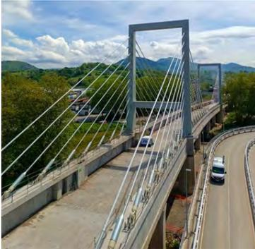
Figura 1. Vista aérea del viaducto atirantado.
