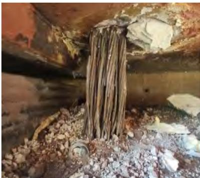
Figura 1. Pretensado vertical afectado.
