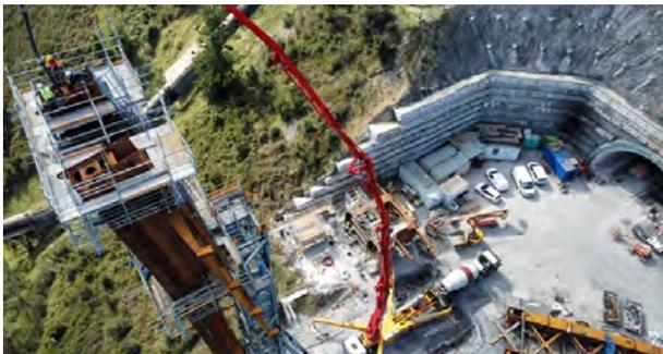
Figura 1. Bombeo de hormigón al interior del tramo.
