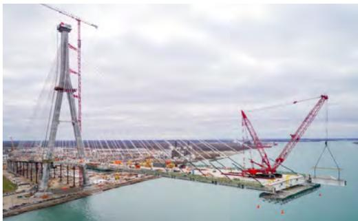
Figura 1. Disposición longitudinal de tirantes.
