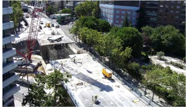
Figura 2. Vista general e izado de una dovela.
