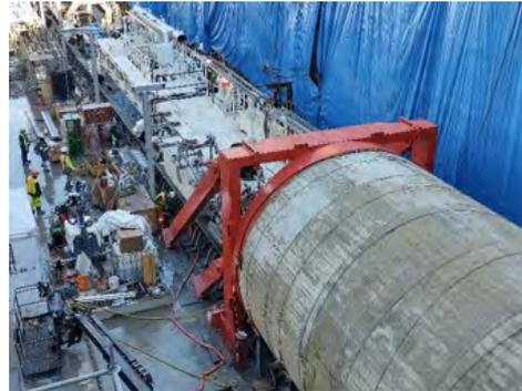
Figura 3: Vista frontal de la estructura de reacción en obra.
