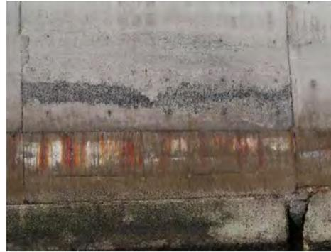
Figura 2. Tongada mal compactada.
