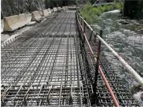
Figura 1. Armaduras de losa en estructura de voladizos sucesivos.
