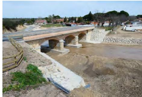
Figura 2. Vista aguas arriba del pontón después las obras de refuerzo y restauración.
