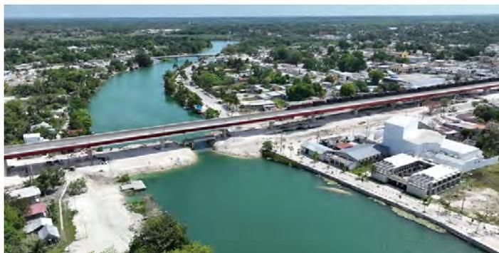
Figura 2. Viaducto de Candelaria a su paso sobre el río Candelaria, con pasarela adosada en construcción.
