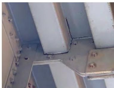
Figura 2. Detalle de uno de los daños por fatiga detectados / Detail of one of the fatigue damages detected.
