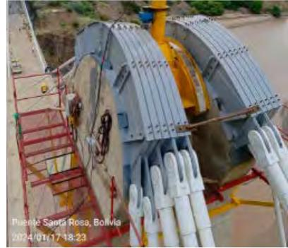
Figura 2. Conector de tirantes en cabeza de pila.
