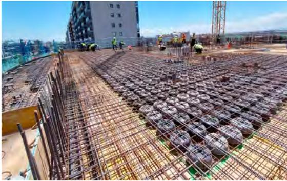
Figura 1. Forjado de cuerpos huecos en Torre A.
