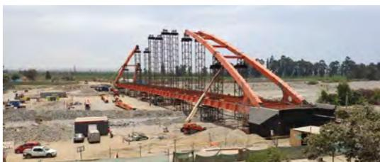
Figura 1. Construcción del Puente Chamorro mediante apoyos intermedios auxiliares.
