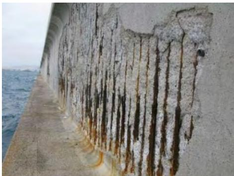
Figura 1. Pérdida de recubrimiento por intensa corrosión del armado, tras 13 años de servicio. Espaldón A.
