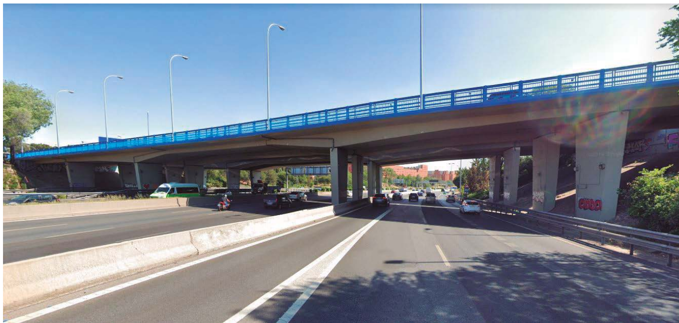
Figura 20. Vista lateral de la estructura ya rehabilitada.
