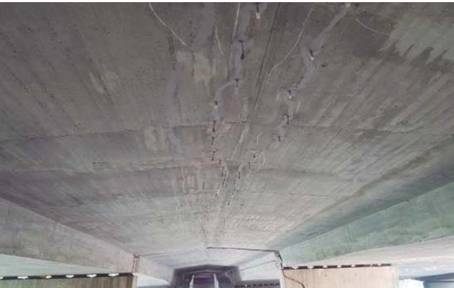
Figura 11. Vista inferior de tablero, con fisuras ya inyectadas.
