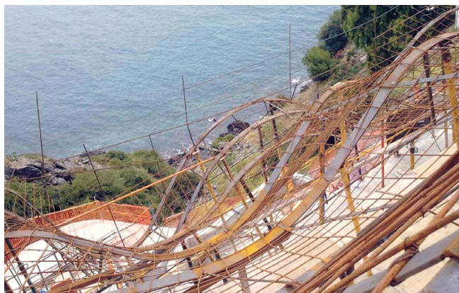
Figura 22. Pletinas de acero predeformadas que constituyen las líneas maestras de la geometría.
