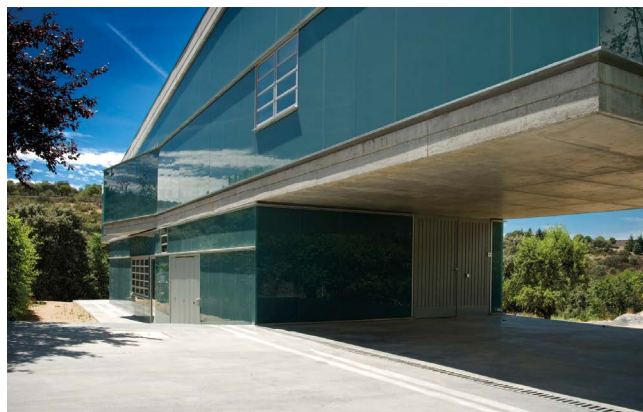
Figura 12. Casa de las hormigas en Collado Villalba.
