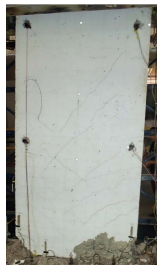
Figura 4. Estado final del muro M0R10.
