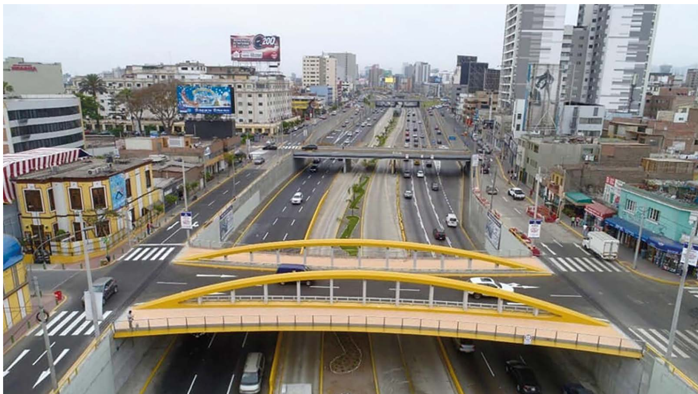
Figura 18. Puente Leoncio Prado en servicio.
