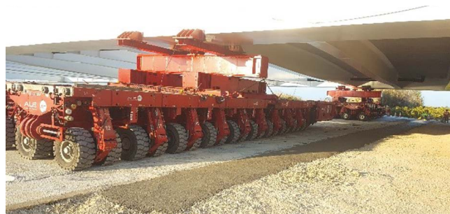
Figura 14. Vista del tablero apoyando sobre un conjunto SPMT, con topes transversales adicionales.
