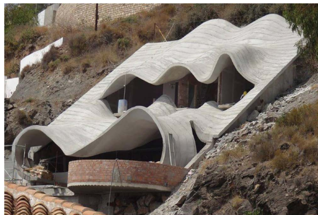
Figura 23. Estructura de hormigón de cubierta.
