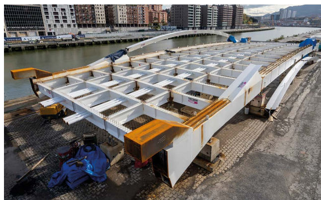
Figura 10. Ensamblaje de bow-string en campa
