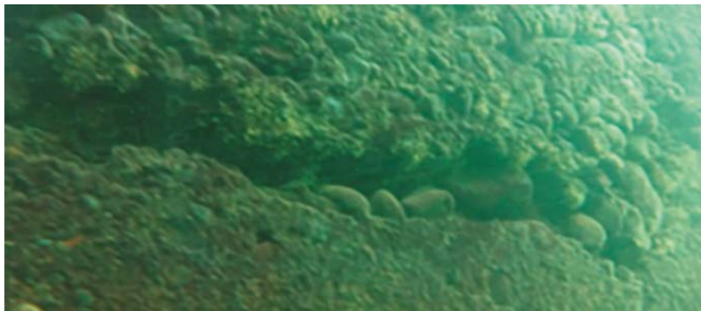
Figura 9. Ejemplo de junta en cajón.
