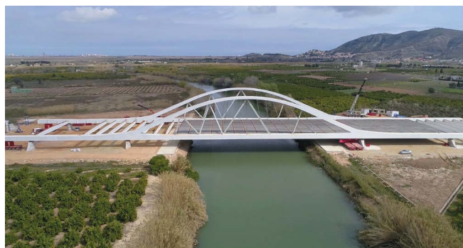
Figura 28. Apeo sobre apoyos definitivos mediante los conjuntos SPMT.
