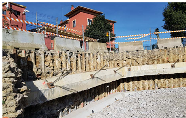
Figura 7. Pantalla de micropilotes en Estribo 2.
