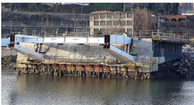
Figura 9. Ejecución de arranques.
