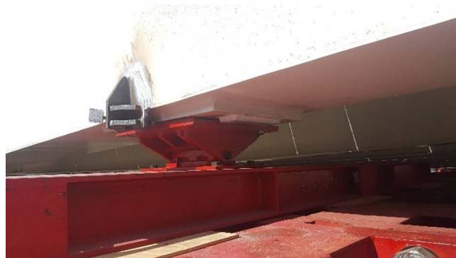
Figura 13. Detalle de apoyo de la viga metálica en la estructura auxiliar de un conjunto SPMT, apoyo rotulado, con topes soldados a la viga.
