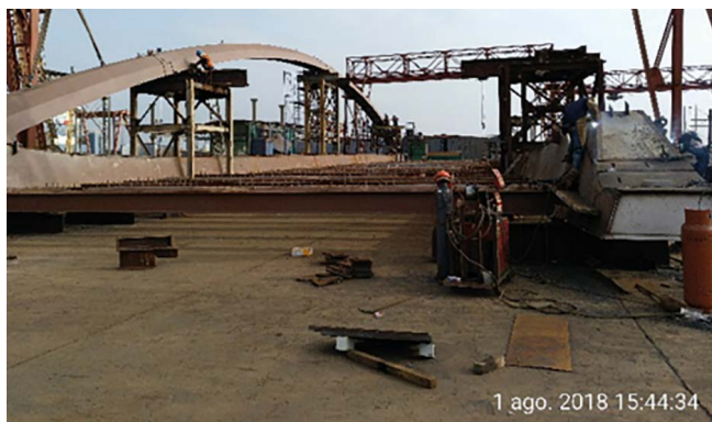
Figura 10. Montaje en taller metálico (Junín).
