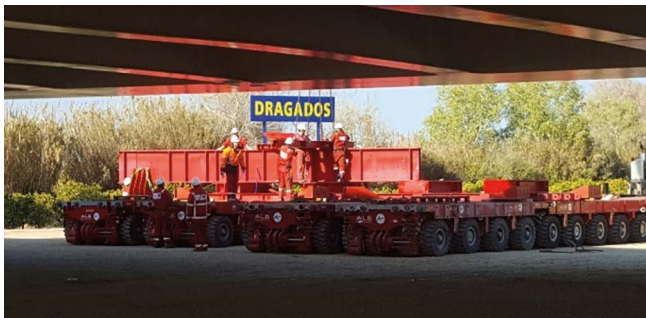
Figura 16. Vista dos conjuntos de ejes SPMT sobre los que se está colocando la estructura metálica auxiliar.
