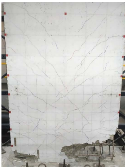
Figura 6. Estado final del muro M1R10.
