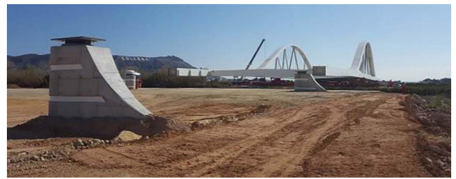
Figura 4. Vista de pilas P4 y P3 antes de recibir al tablero.
