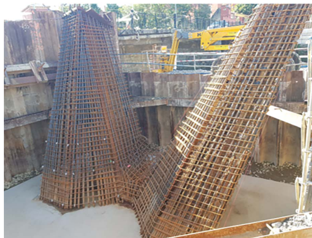
Figura 9. Ferralla alrededor del bastidor metálico de pila.
