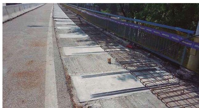
Figura 18. láminas de refuerzo de fibra de carbono ya instaladas.
