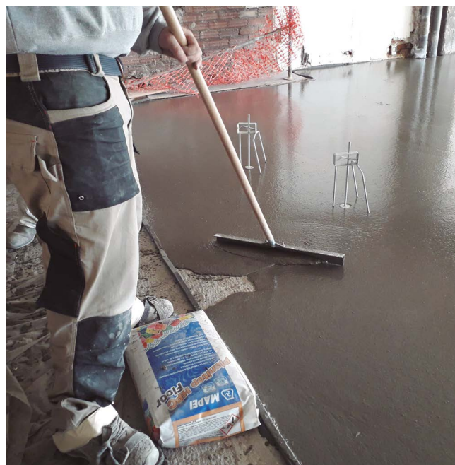
Figura 18. Extendido y control de espesores.
