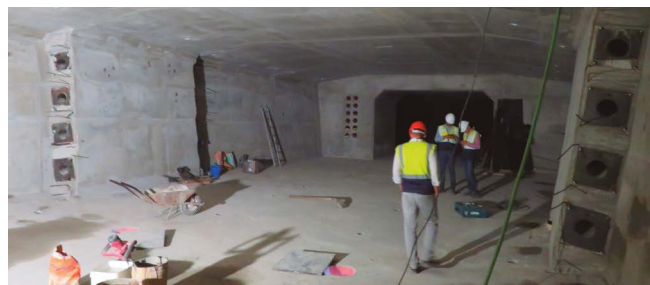
Figura 9. Detalle del regresamiento de las almas para el cruce y anclaje de los tendones de pretensado de alma.
