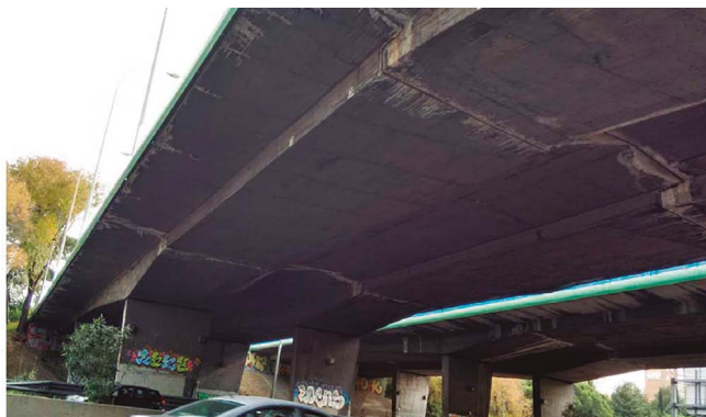
Figura 4. Vista inferior previa a la rehabilitación.
