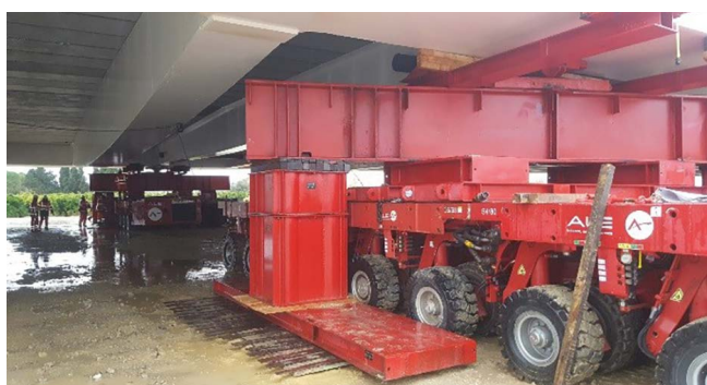
Figura 21. Vista del montaje en obra de la estructura metálica del tablero.
