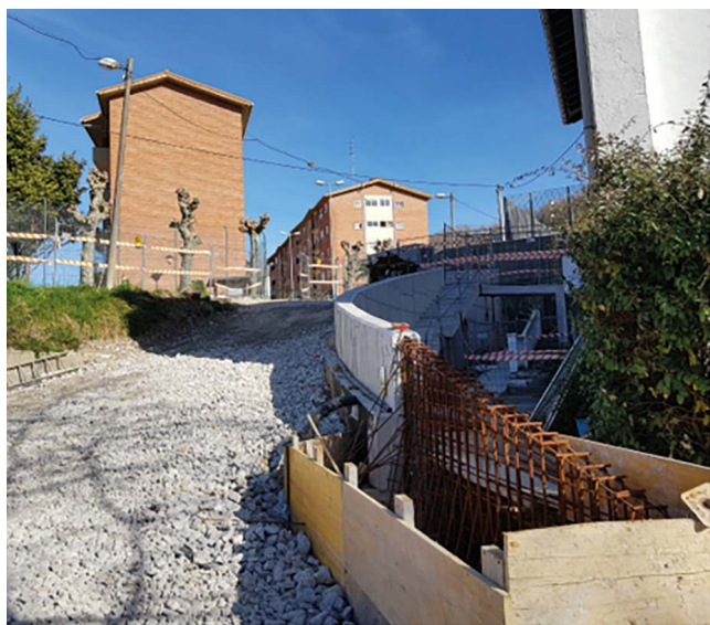
Figura 8. Muro en rampa del caserío.
