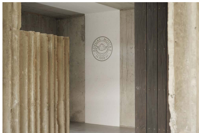
Figura 6. Tratamientos superficiales en hormigones vistos.
