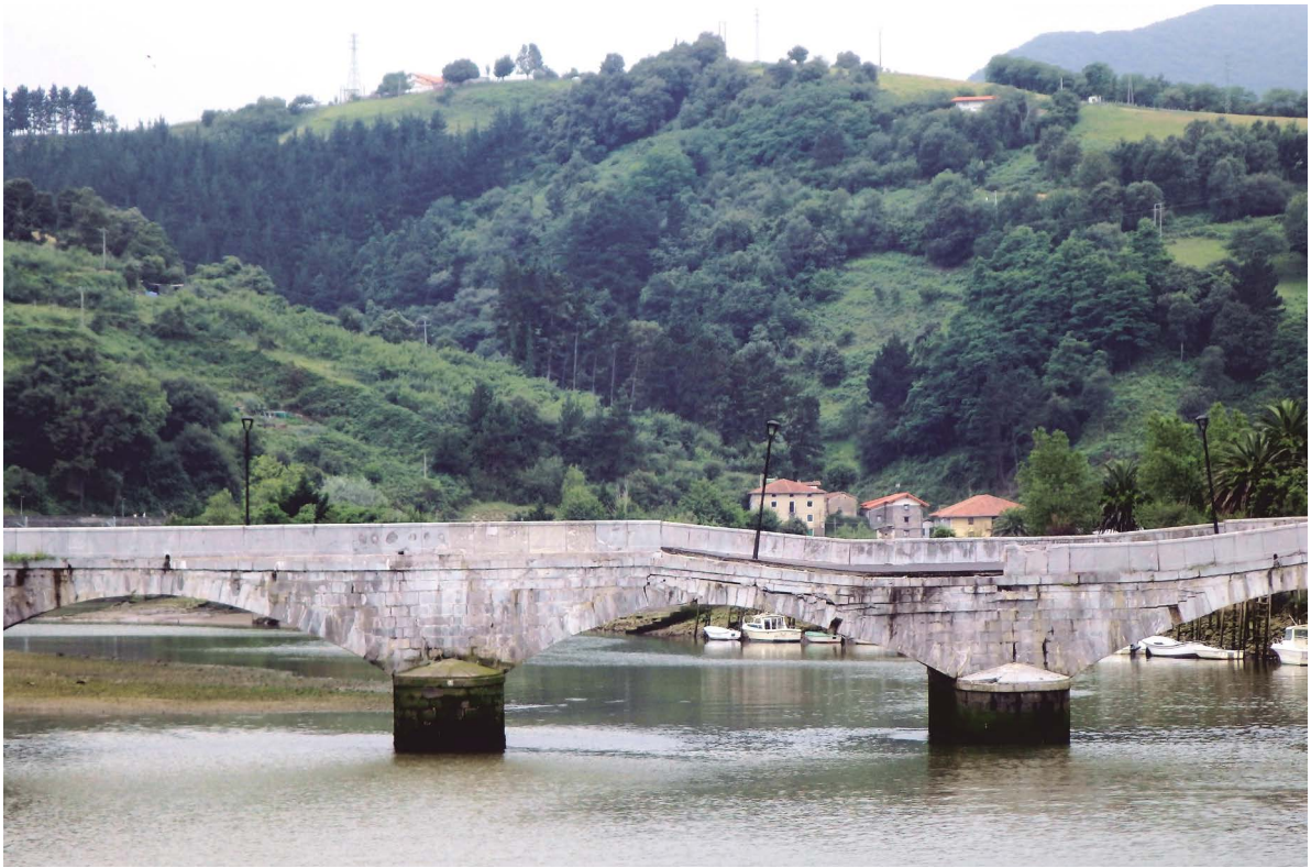
Figura 4. Estado del puente de Deba tras el asiento de la pila en julio de 2018.
