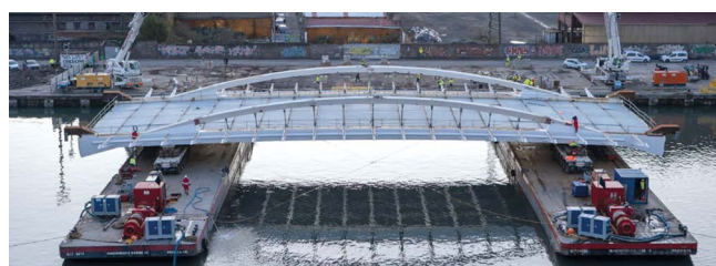
Figura 11. Recepción del bow-string y traslado a las pontonas.
