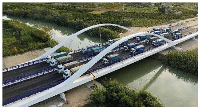
Figura 29. Vista aérea durante la prueba de carga.
