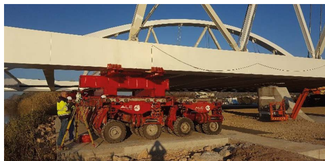
Figura 25. Vista de control topográfico midiendo a dianas dispuestas en las vigas.
