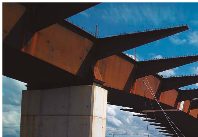
Figura 5. Vista exterior del mamparo de pila 1.
