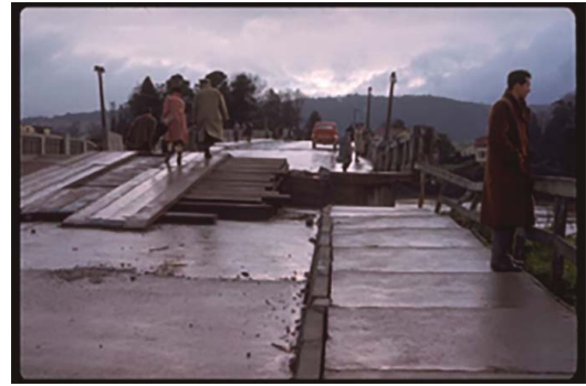
Figura 2. Puente tras el Sismo de 1960 Fuente: Bifurcaciones.
