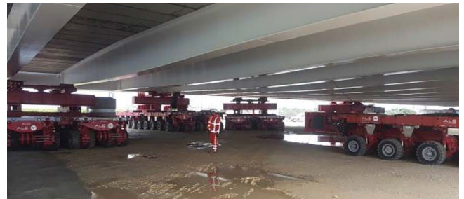
Figura 19. Vista de los carros SPMT bajo el tablero.
