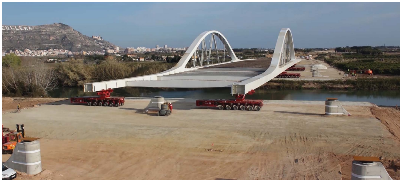
Figura 20. Vista de una fase de la maniobra con el puente girado y desplazado respecto del trazado.
