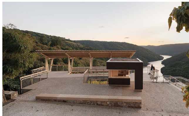
Figura 4. Vista general de la estructura del mirador.
