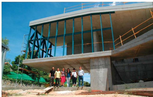
Figura 15. Vista general de la estructura del voladizo.
