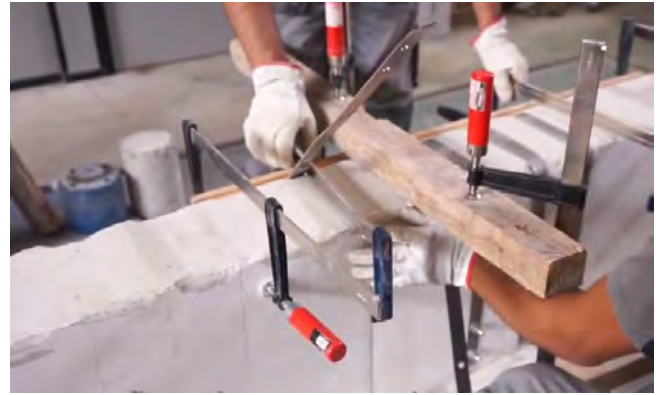
Figura 3. Colocación refuerzo externo. Sección en T.
