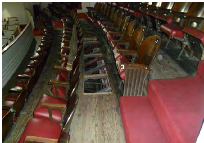
Figura 13. Vista de la viga transversal entre las butacas del teatro
