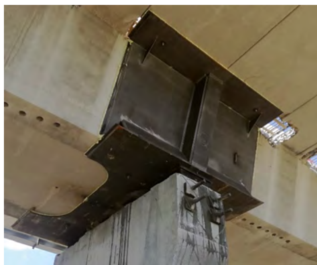
Figura 20. Montaje de dovelas de pila.
