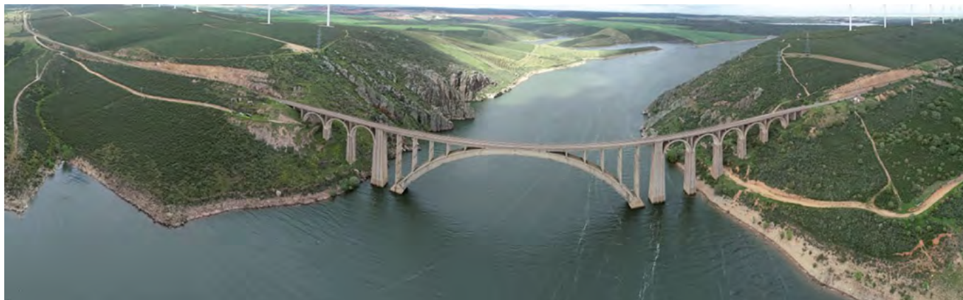
Figura 8. Vista general desde el dron del viaducto Martín Gil situado en el PK 23/043 de la Línea Zamora - A Coruña. (Fuente: Ineco).
