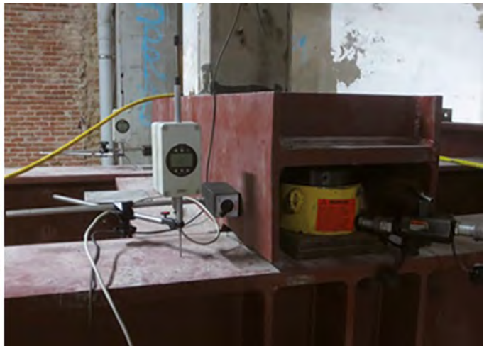
Figura 14. Entramado de apeo del soporte a realizar y auscultación de la estructura durante el proceso.
