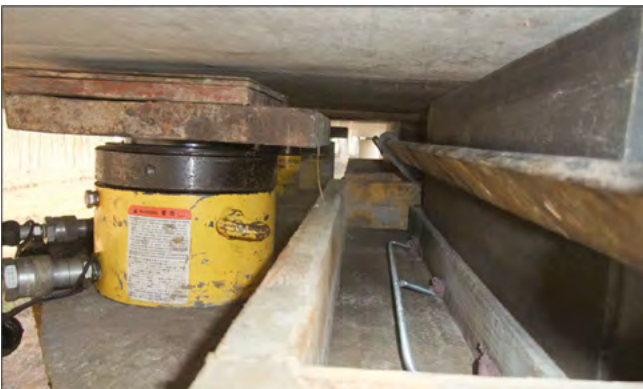
Figura 9. Recrecido de camas de asiento y recolocación de apoyos.
