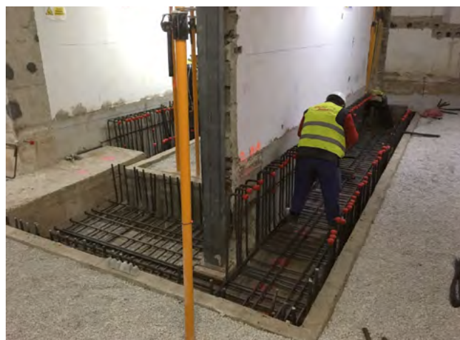
Figura 34. Armado de encepado (ejecución en 2 fases).
