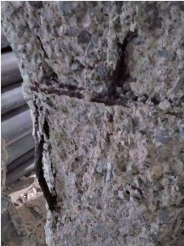
Figura 39. a) Pandeo de barras longitudinales tras retirar el cerramiento. b) Deslajamiento del recubrimiento en esquinas.
