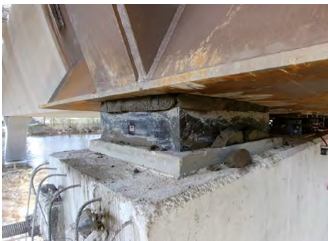
Figura 22. Descenso del tablero sobre los nuevos aparatos de apoyo.
