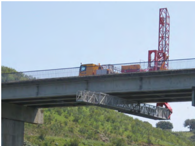
Figuras 5 y 6. A la izquierda, inspección detallada con camión pasarela. A la derecha, determinación in-situ de los parámetros de corrosión, en el marco de una inspección especial. Fuente: GEOCISA.
