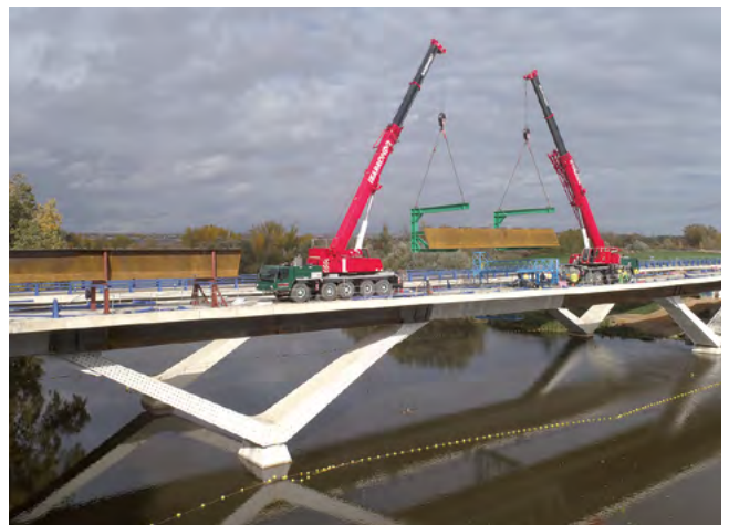
Figura 28. Montaje de dovelas.
