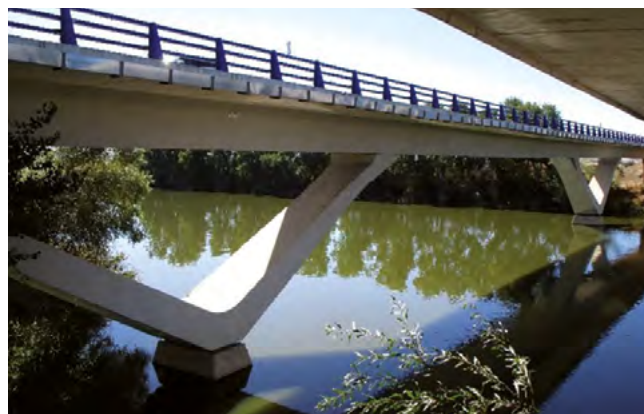
Figura 16. Vista general de la estructura en su estado original.
