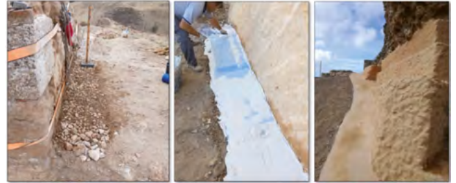
Figura 37. Ejecución de drenaje y acera perimetral en la torre.
