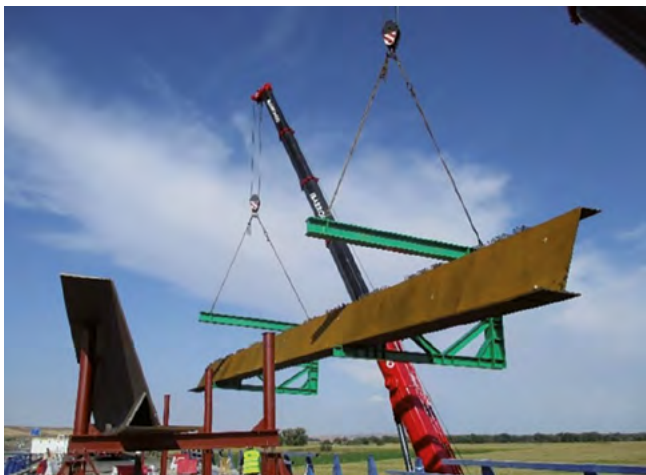
Figura 27. Dovela sobre los útiles de izado diseñados para el montaje.
