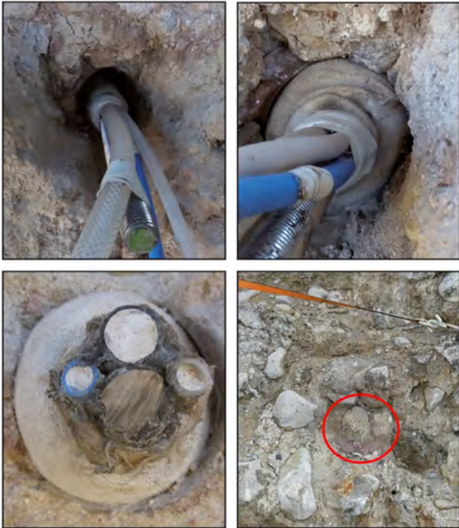
Figura 35. Proceso de inyección.
