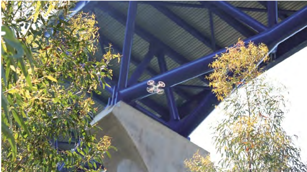
Figura 9. Inspección de puente mediante el uso de drones. Fuente: GEOCISA, 2016.
