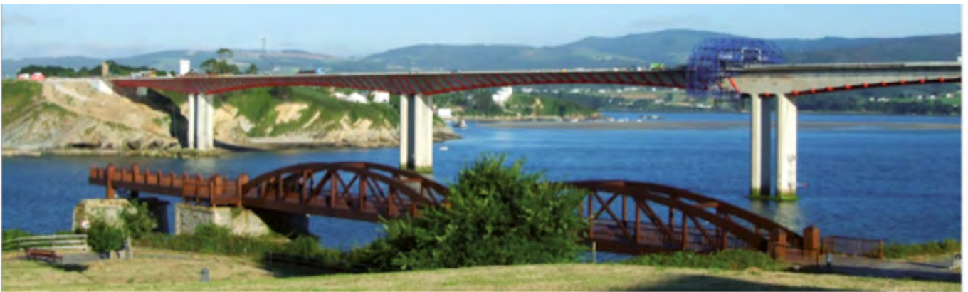
Figura 3. Puente de Los Santos. (FHECOR).
