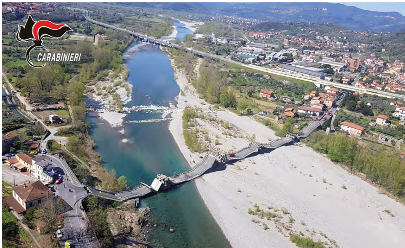
Figura 34. Colapso del puente de Albano Magra, 8 de abril de 2020. Foto difundida a los medios de comunicación.
