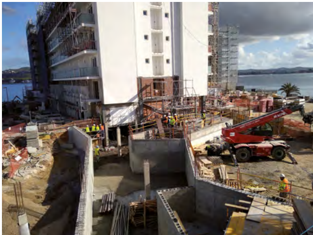
Figura 30. Aspecto general exterior del edificio durante las obras.
