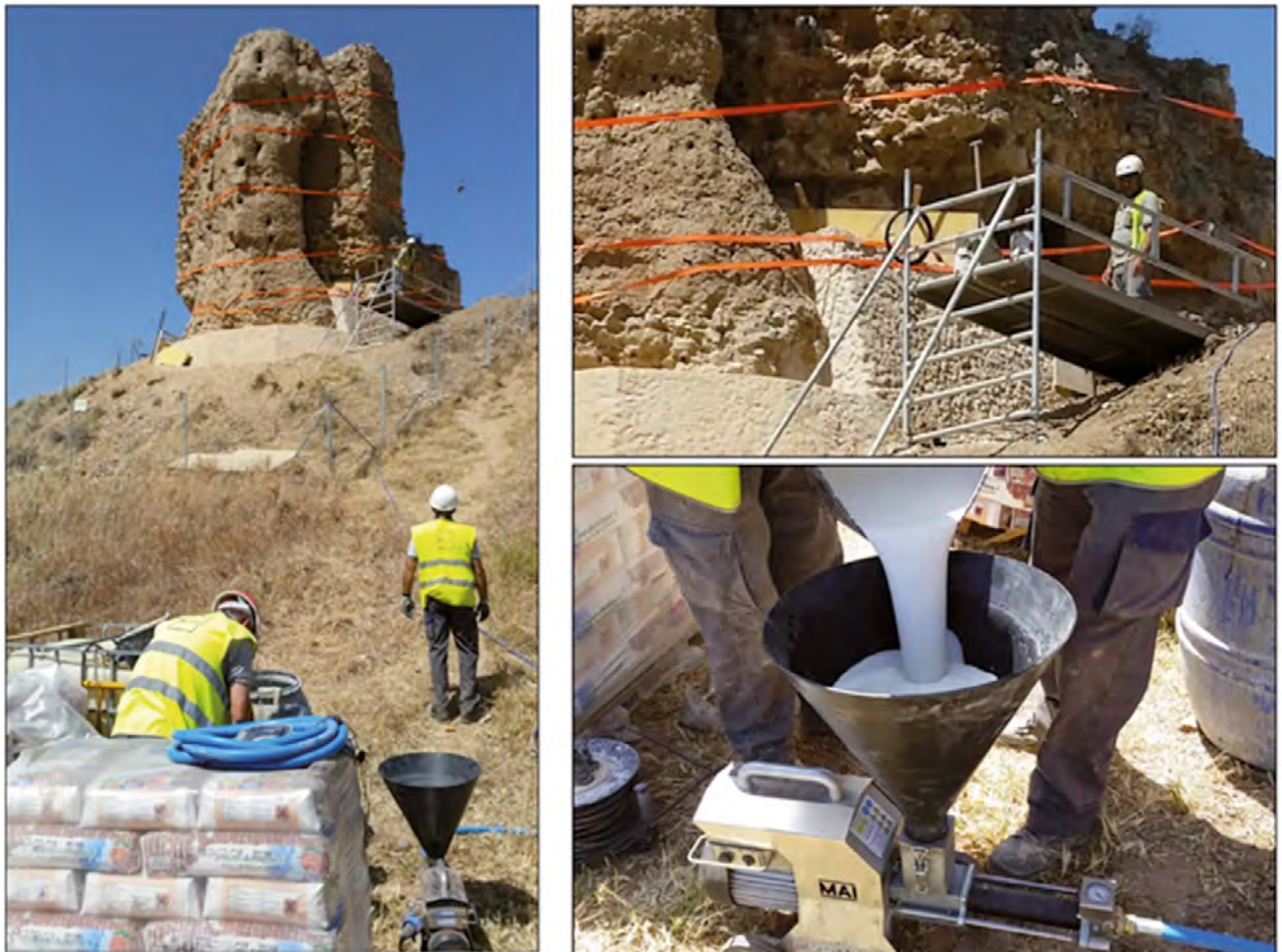
Figura 29. Ejecución recalce.
