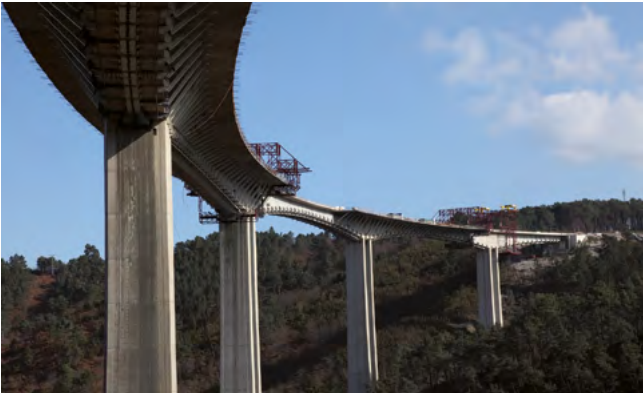
Figura 1. Viaducto de San Pedro de la Ribera.
