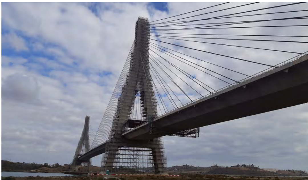
Figura 9. Vista general del puente atirantado sobre el Guadiana con la pasarela bajo tablero.
