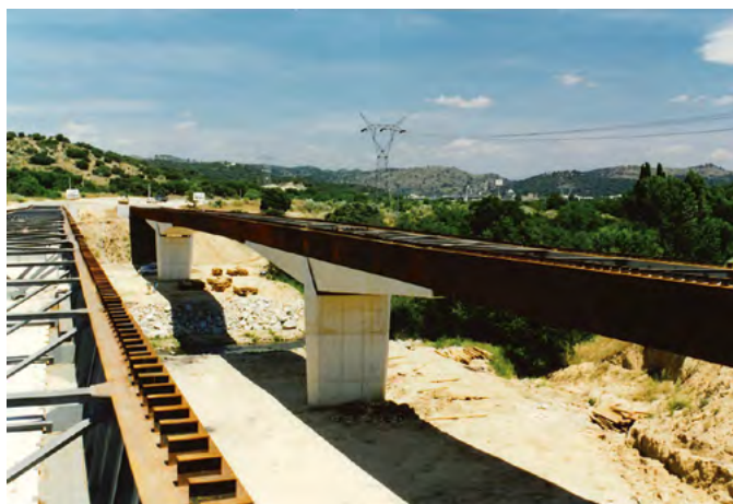
Figura 13. Topes metálicos de conexión del viaducto mixto de Retamar. 6
