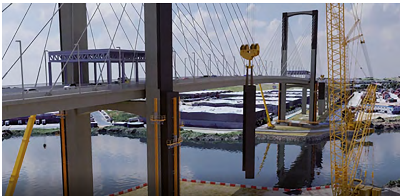
Figura 4. Recreación del montaje del recrecido de los pilonos.
