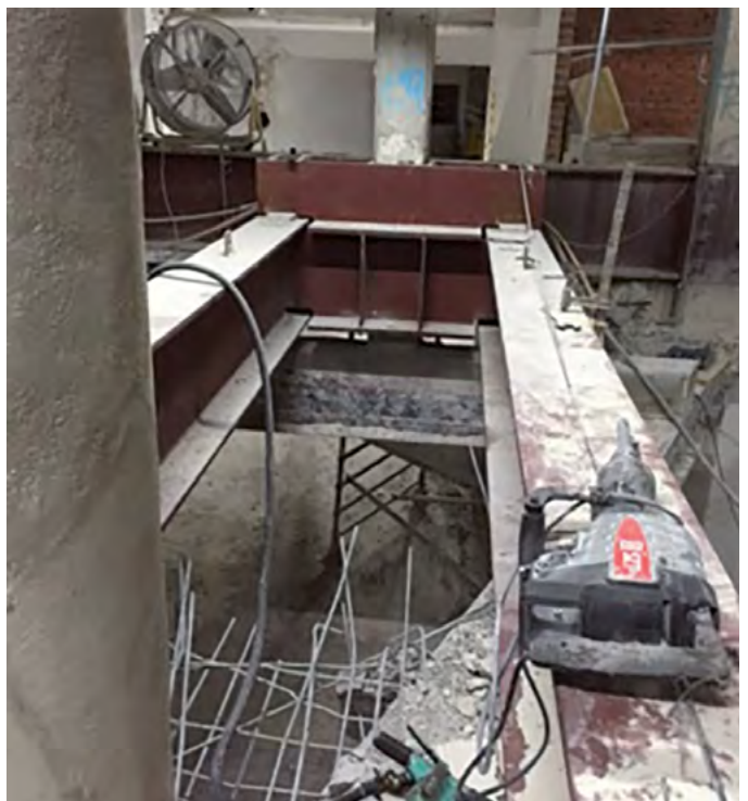
Figura 15. Auscultación de la estructura metálica durante el proceso de demolición.
