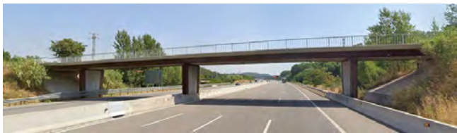
Figura 7. Ampliación de luces en pasos superiores.
