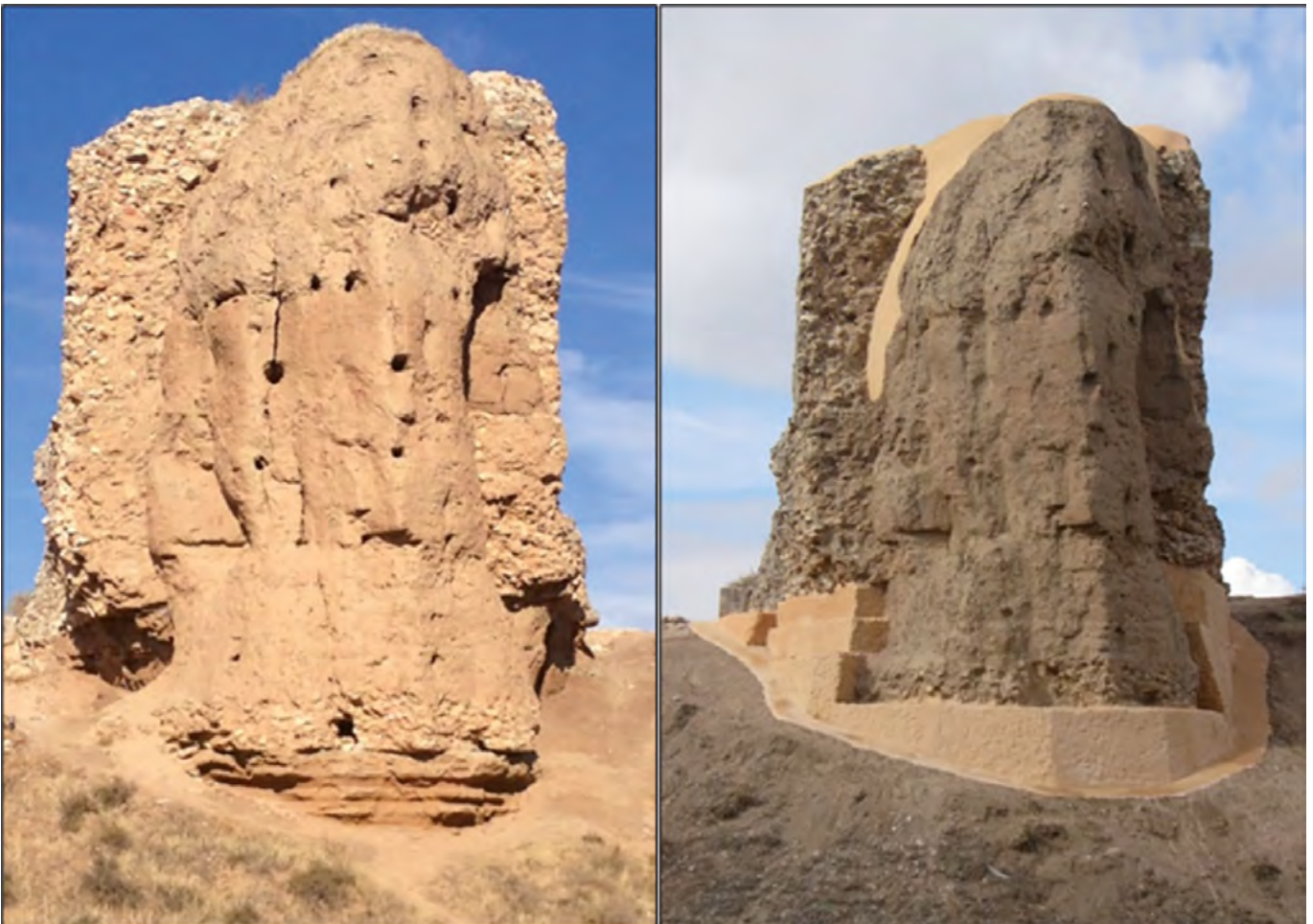
Figura 38. Estado inicial y final de la torre.
