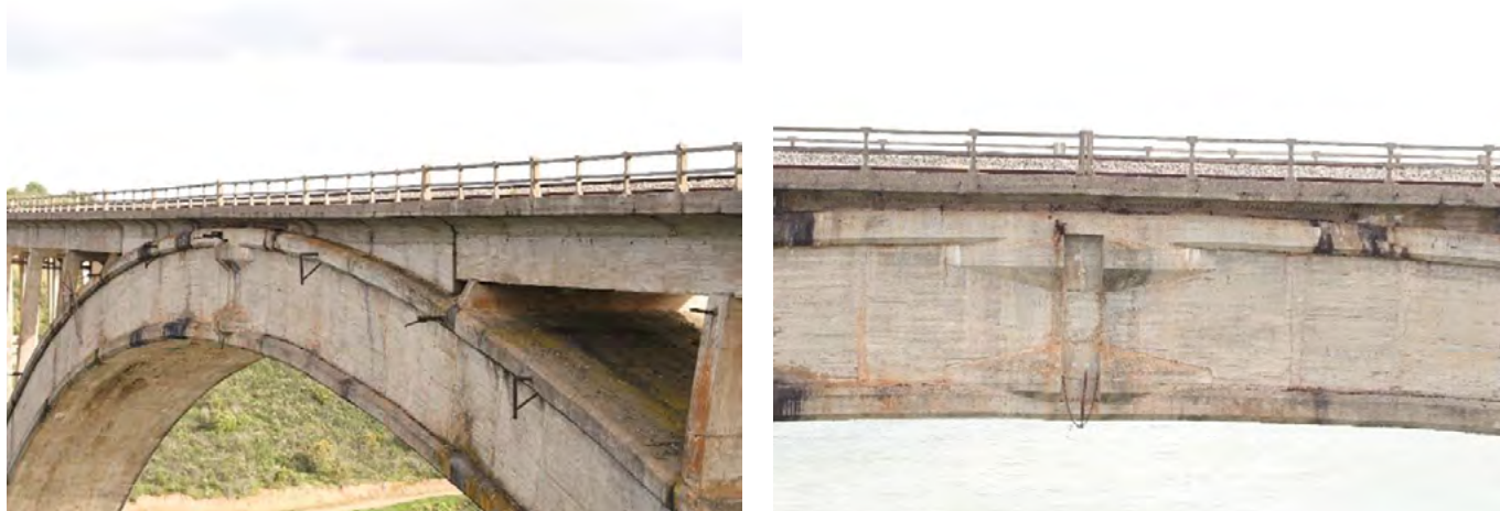
Figura 10. Vista general y de detalle de la zona de la clave del arco central del viaducto Martín Gil. (Fuente: Ineco).
