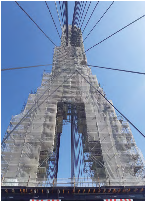
Figura 11. Andamiaje de pylon (izquierda). Sustitución de cables en tirantes y enfilado de cordones (derecha).
