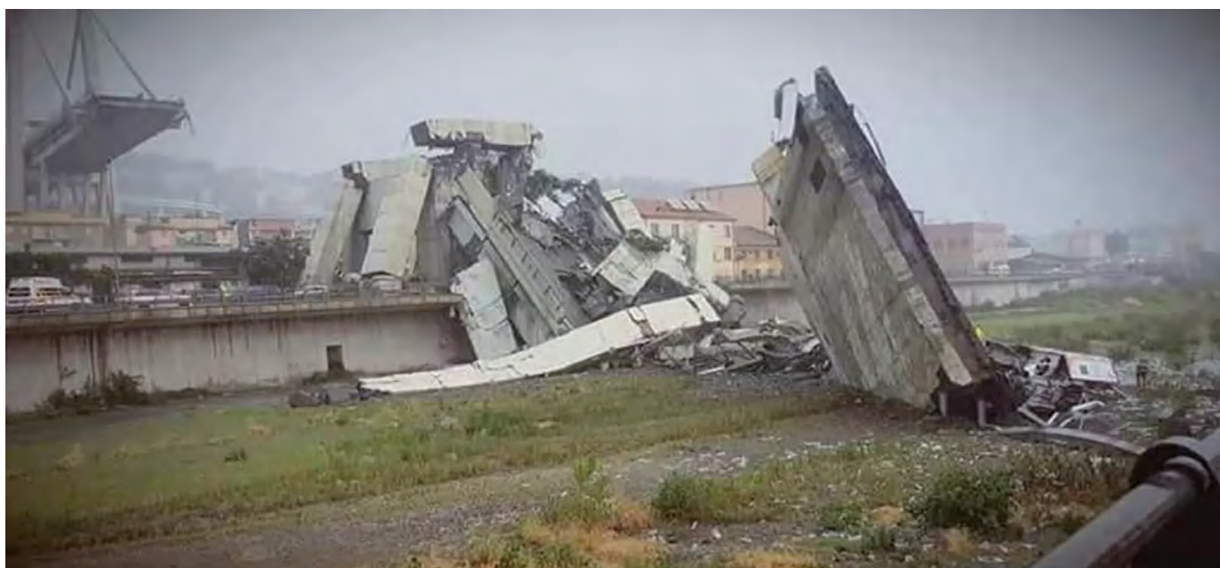
Figura 33. Colapso del puente Polcevera, Génova, Italia, 2018 [25].
