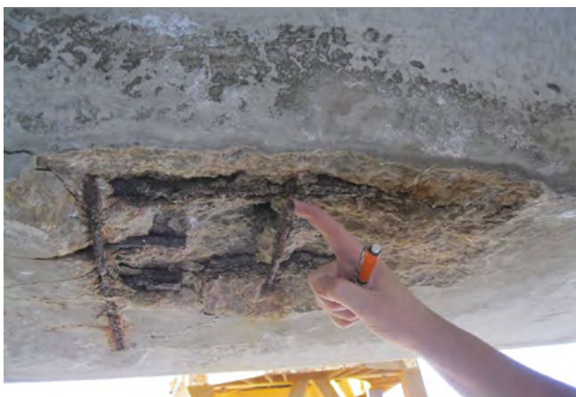
Figuras 7 y 8. En una inspección visual se pueden evaluar los deterioros de forma cualitativa, y a veces parcialmente cuantitativa (la pérdida de sección de una armadura o la longitud y anchura de las fisuras), pero difícilmente se puede conocer la influencia del daño en el desempeño del elemento. Fuente: GEOCISA.
