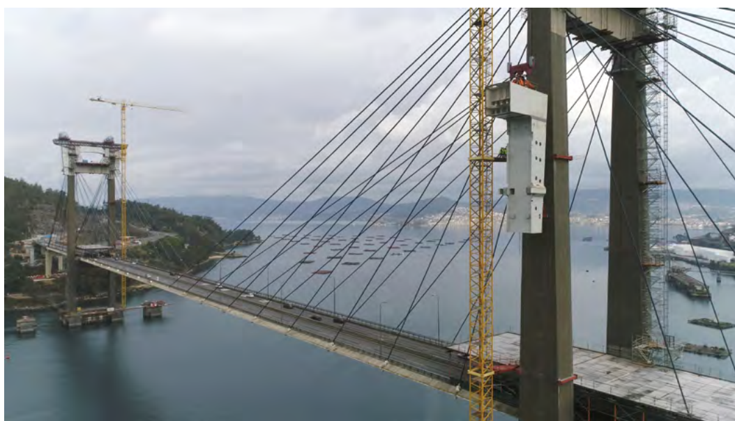
Figura 6. Montaje de la ampliación de la cabeza de los pilonos del puente de Rande (Fuente Ministerio de Transportes, Movilidad y Agenda Urbana).
