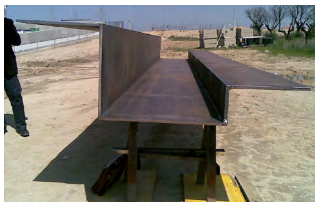
Figura 13a. Viga metálica de la ampliación.
