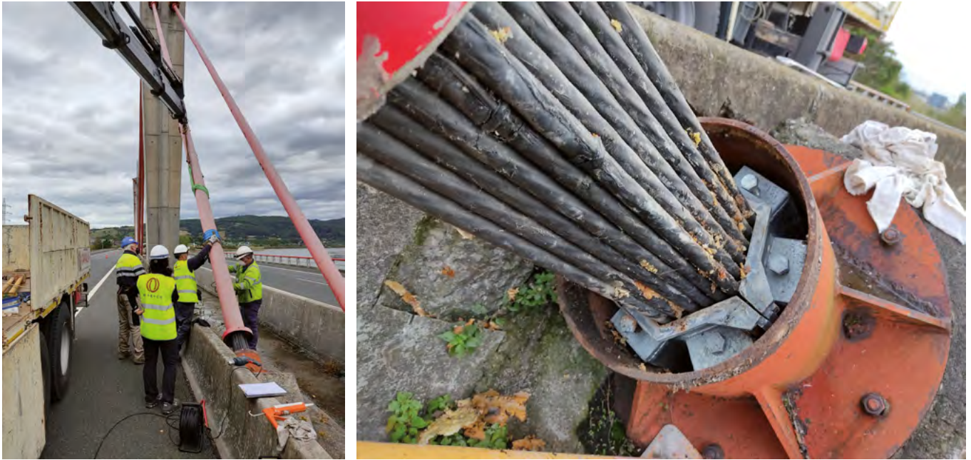
Figura 1. Inspección especial, octubre de 2020, del atirantamiento del puente de Colindres en la A-8.
