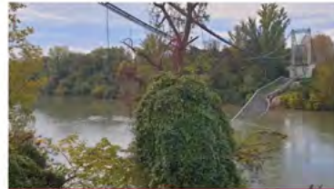
Figura 13. Viñeta tomada de [15] y noticia de un accidente frente al paso de un vehículo pesado cerca de Toulouse, Francia, sobre el río Tarn (1935) [16].
