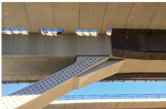
Figura 31. Taladros en la pila en "V" para alojar los pernos.
