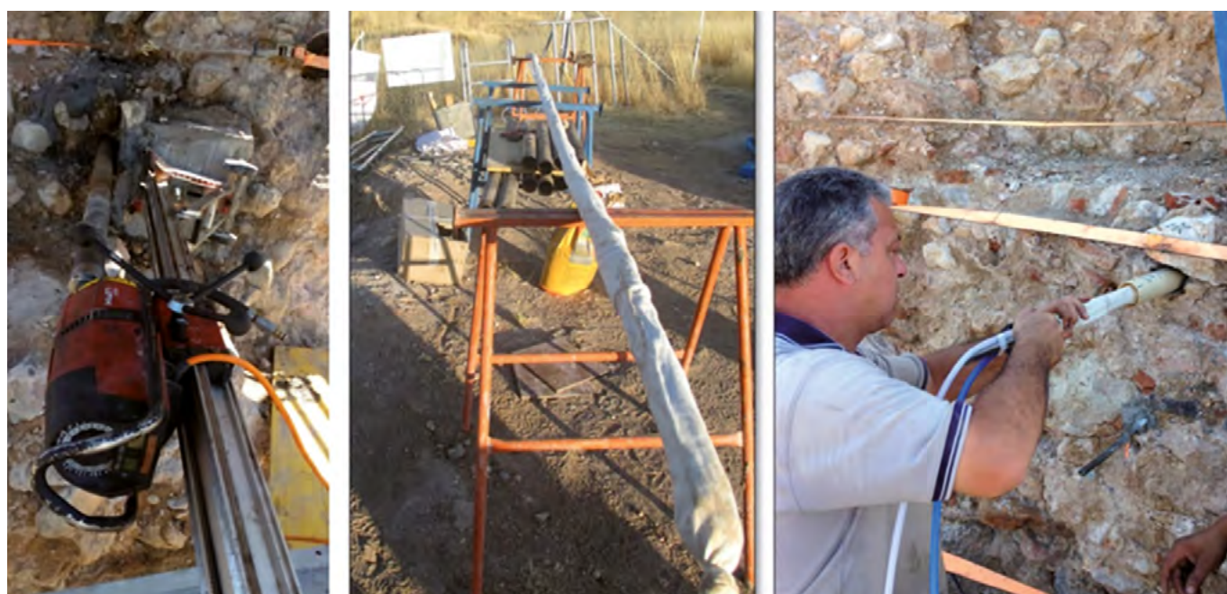
Figura 34. Perforación y montaje del anclaje.
