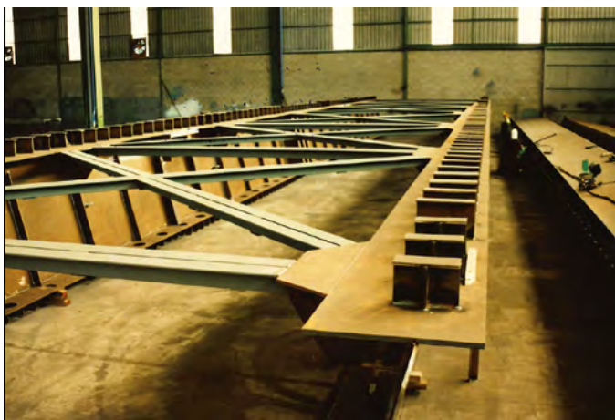
Figura 13. Topes metálicos de conexión del viaducto mixto de Retamar. 6
