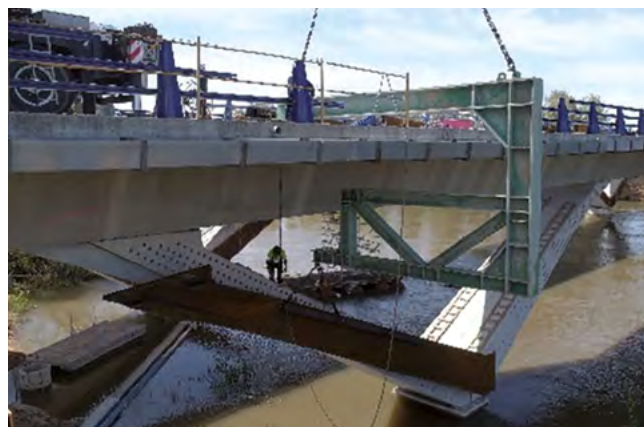
Figura 32. Montaje del forro metálico en pilas en V.
