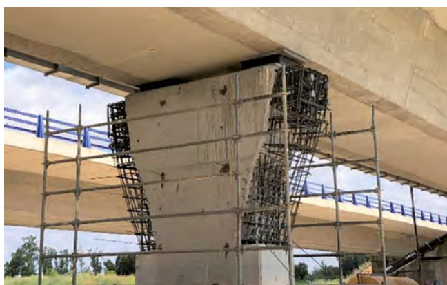
Figura 19. Vista de los recrecidos laterales en las pilas convencionales.
