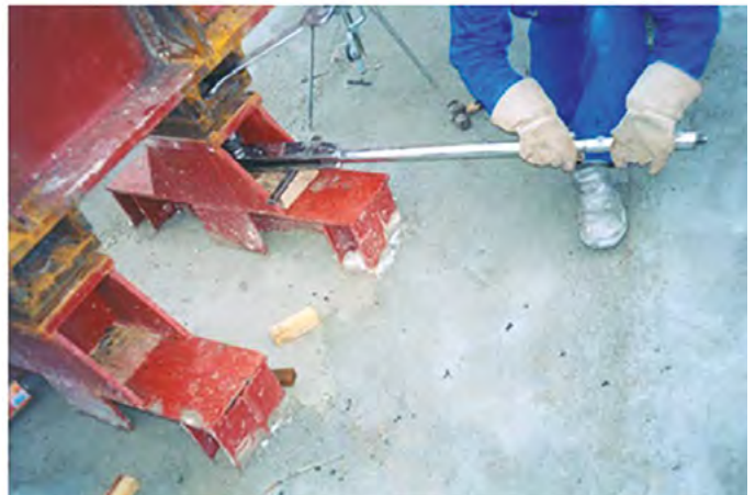
Figura 11. Sistema para acortamiento de la longitud del tirante (nota: no se representan las contratuerzas inferiores).
