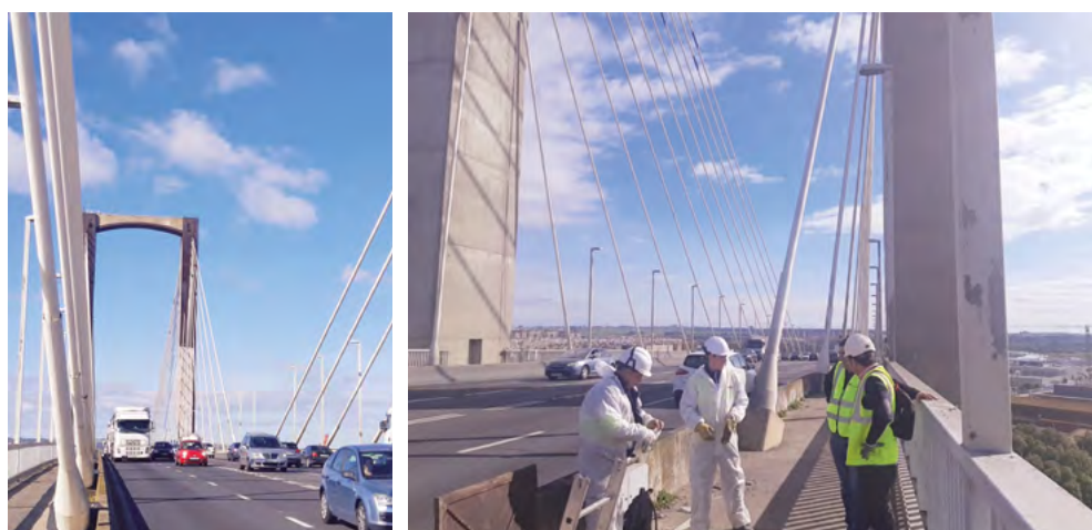
Figura 8. Detalle puente atirantado del Centenario (izquierda). Acceso para inspeccion del interior del tablero (derecha).
