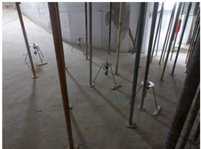
Figura 14. Entramado de apeo del soporte a realizar y auscultación de la estructura durante el proceso.
