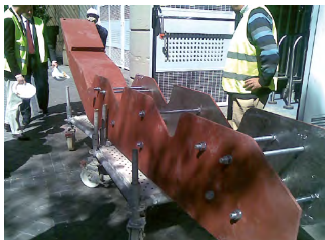
Figura 14b. Pieza metálica de apoyo de la grada en el pórtico.
