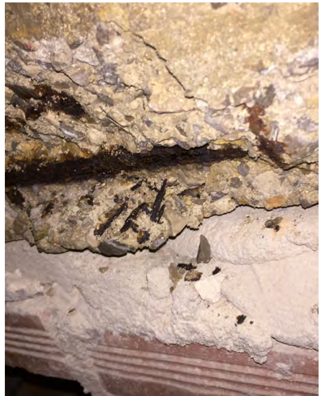
Figura 29. Corrosión.
