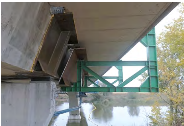
Figura 29. Montaje de dovelas.
