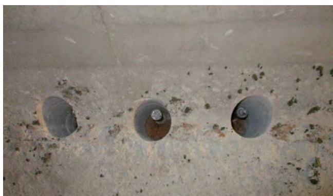
Figura 11. Soldeo de pernos en el interior de un cajón de hormigón.
