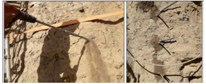
Figura 36. Tratamientos de grietas.
