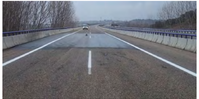
Figura 8. Reposición del aglomerado.
