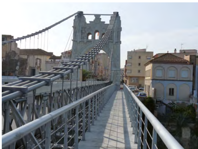
Figura 4. Detalle de cables principales, con elementos de union a las p ndolas en puente rehabilitado. Imagen del pilono de f brica (derecha) y de los tirantes en vanos extremos (izquierda).
