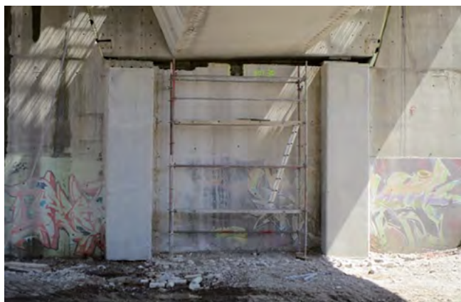
Figura 18. Vista de los recrecidos frontales en los estribos.
