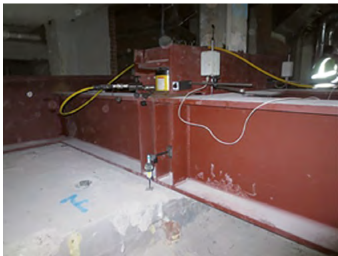
Figura 14. Entramado de apeo del soporte a realizar y auscultación de la estructura durante el proceso.
