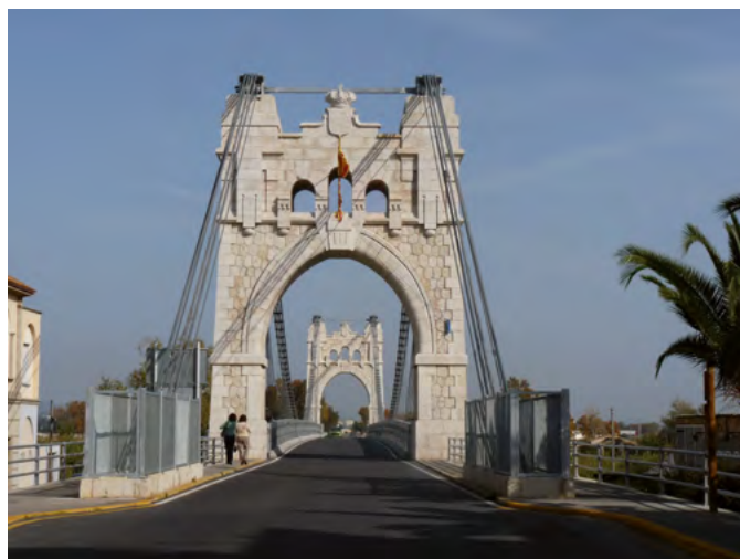
Figura 4. Detalle de cables principales, con elementos de union a las p ndolas en puente rehabilitado. Imagen del pilono de f brica (derecha) y de los tirantes en vanos extremos (izquierda).
