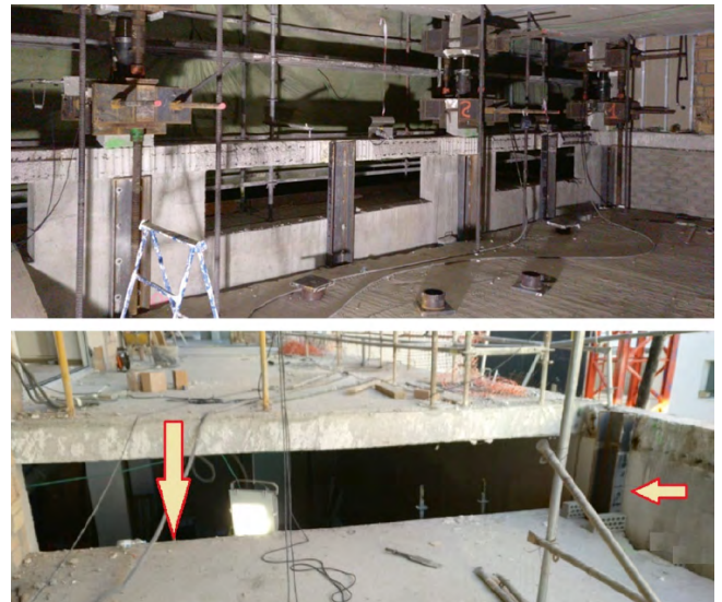
Figura 14. detalle de guía metálica ante esfuerzos horizontales.
