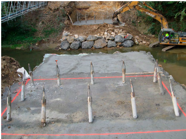
Figura 22. Micropilotes y plataformas de apoyo de cimbra.
