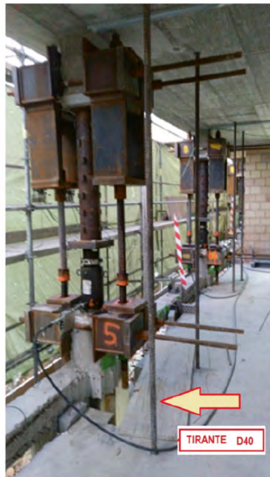
Figura 13. Esquema de tirantes de cuelgue en losa de baja cortada en muro. Apeo metálico en soporte sobre muro.
