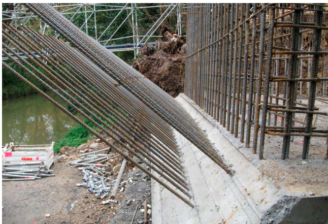
Figura 24. Detalle de arranque de arco.
