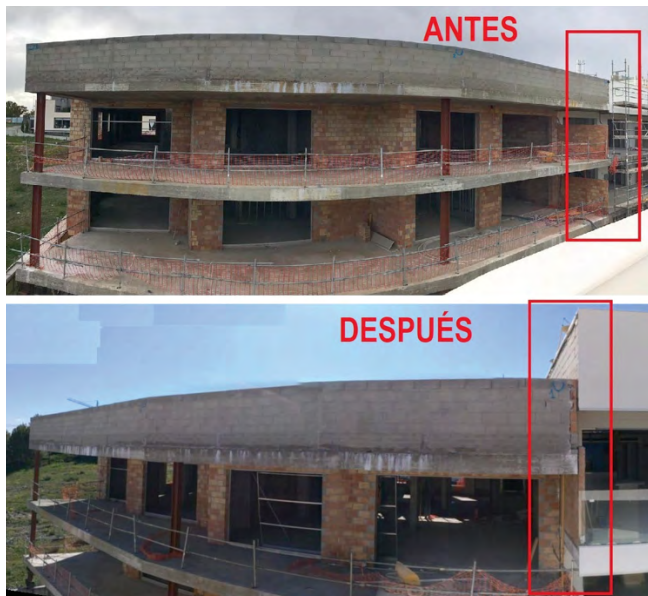
Figura 6. Descenso de edificio.
