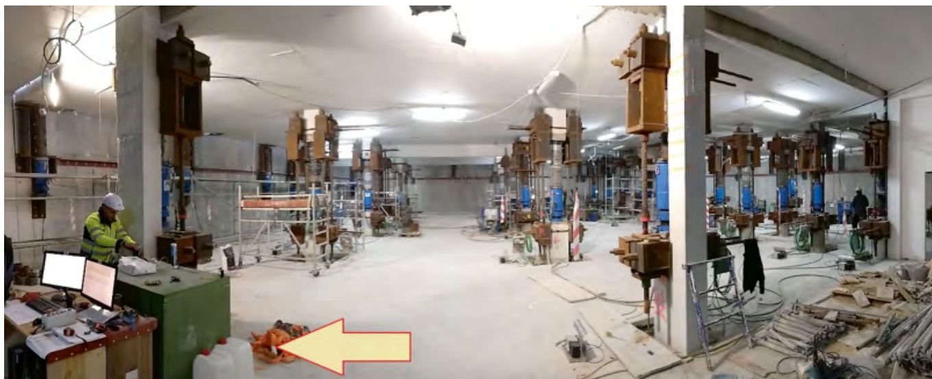
Figura 17. Maniobra. Central de sincronización de gatos.
