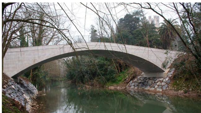
Figura 32. Puente sobre el río Butrón desde aguas abajo.
