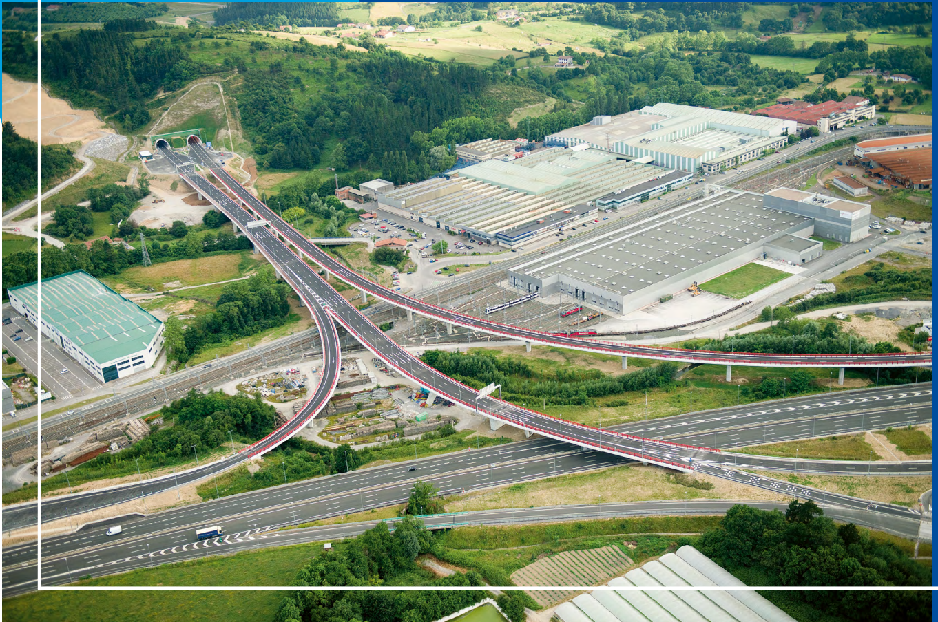
Autopista Gerediaga - Elorrio (Bizkaia)
