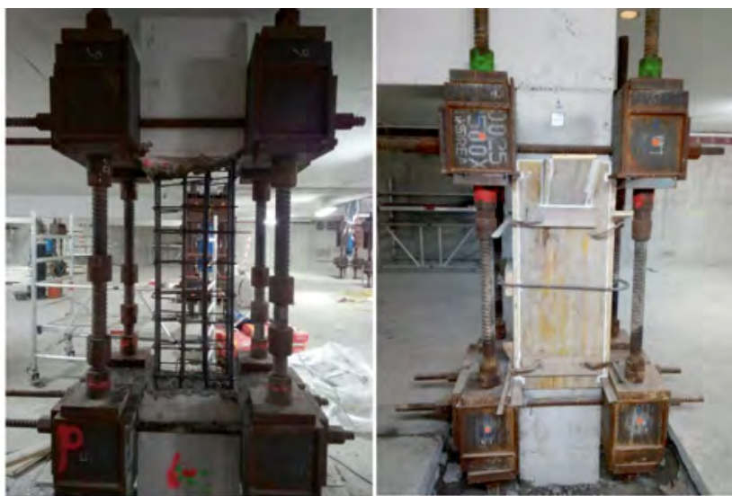
Figura 18. Restitución de soportes.
