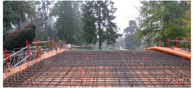
Figura 30. Armadura de tablero.
