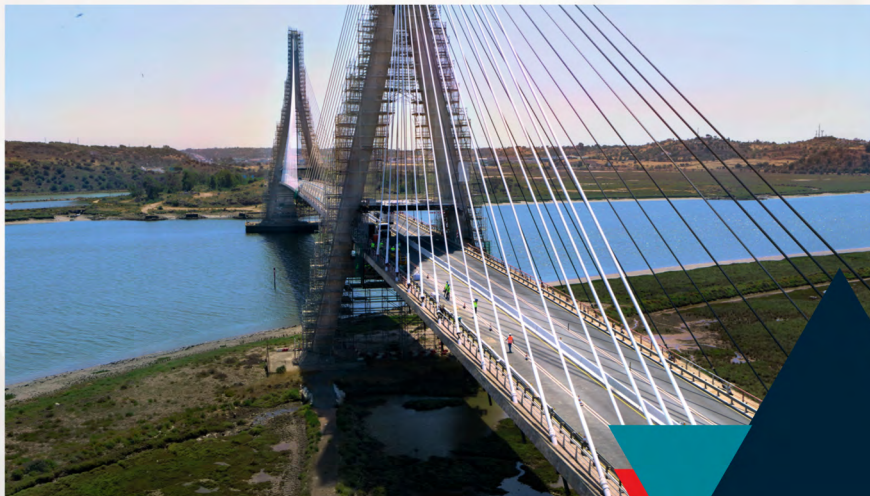
PUENTE INTERNACIONAL SOBRE EL RÍO GUADIANA
