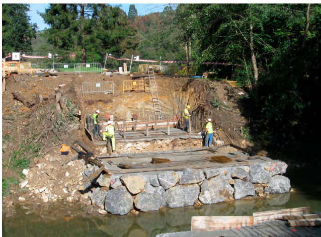
Figura 23. Vista de estribo 1.
