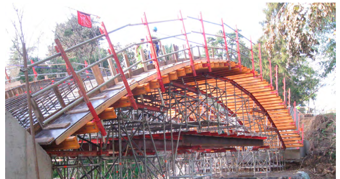
Figura 26. Detalle de cimbra terminada.
