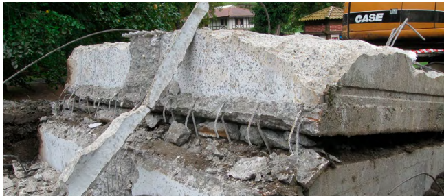
Figura 19. Demolición de refuerzos existentes sobre puente original.
