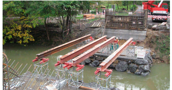
Figura 25. Instalación de vigas centrales de cimbra.
