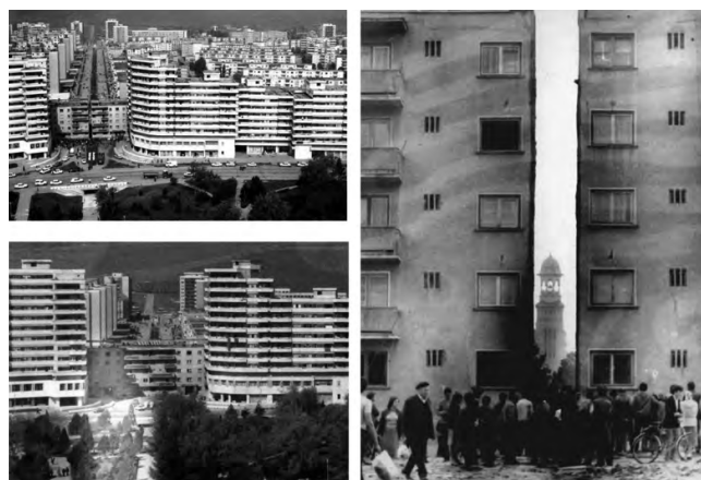
Figura 5. Edificio cortado, elevado y trasladado en Rumanía durante la sistematización urbanística de Ceaușescu.
