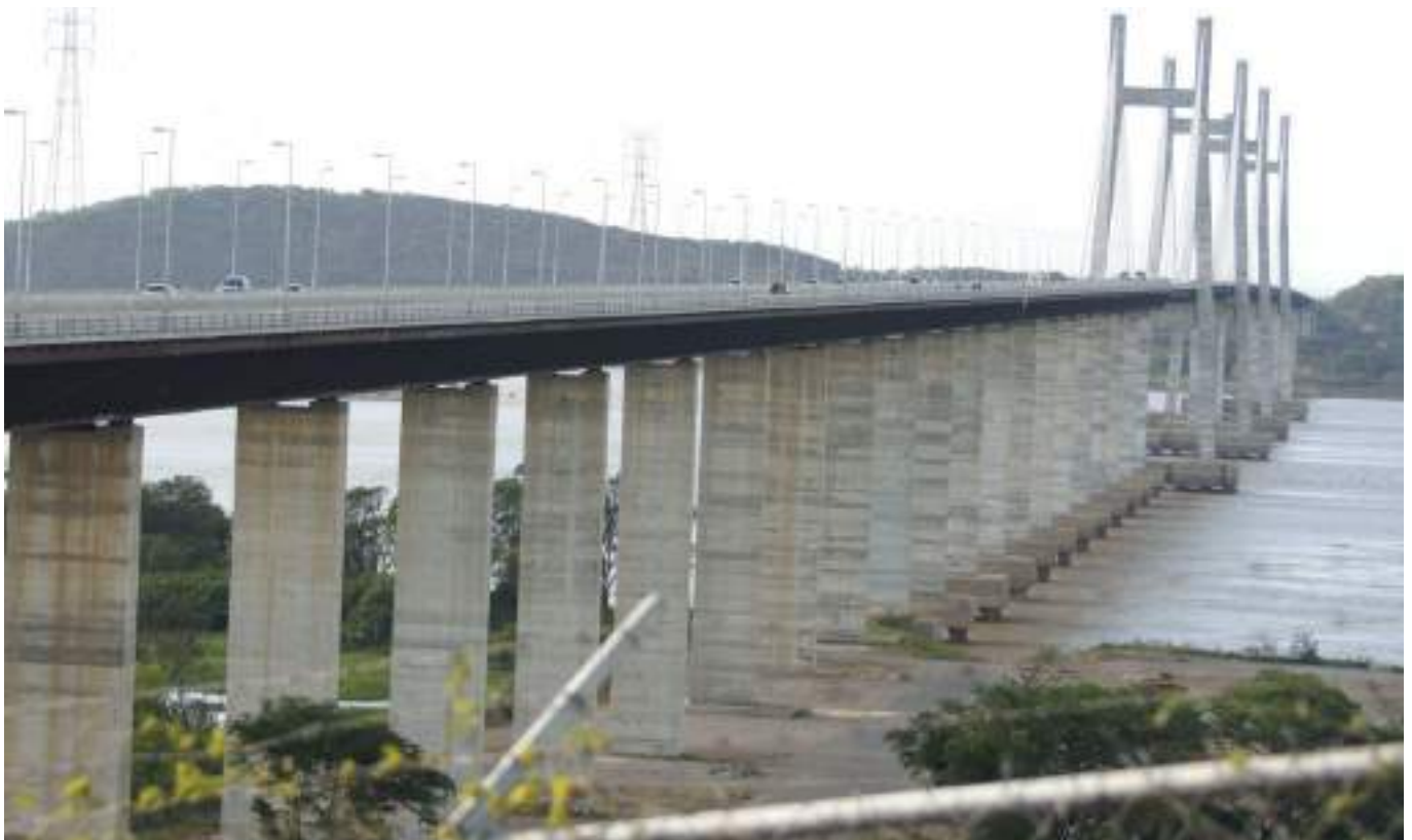
Figure 22. Orinico Bridge, Venezuela.
