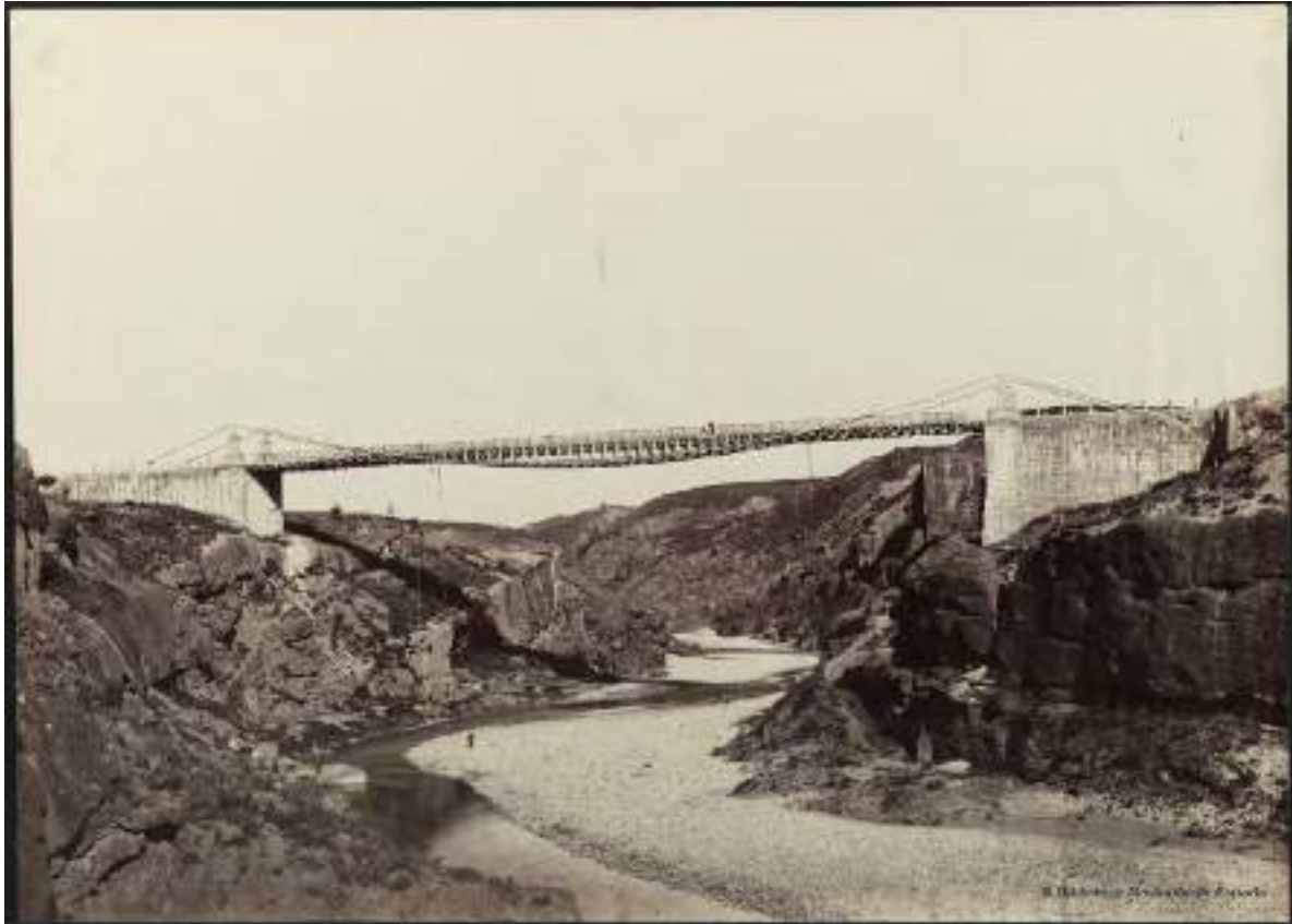
Figure 17. Lascellas Bridge Spain. Source.: Biblioteca Nacional de España.
