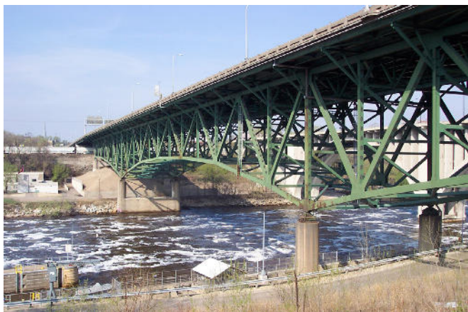
Figura 3. Vista del tramo principal del puente antes de su colapso.
