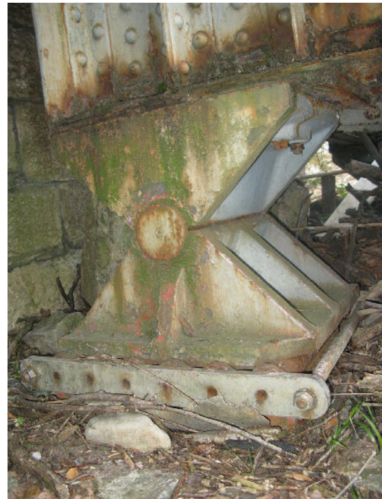
Figura 2. Apoyo deslizante del mismo puente.
