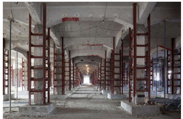
Figura 8. Nueva estructura metálica en nave 9.
