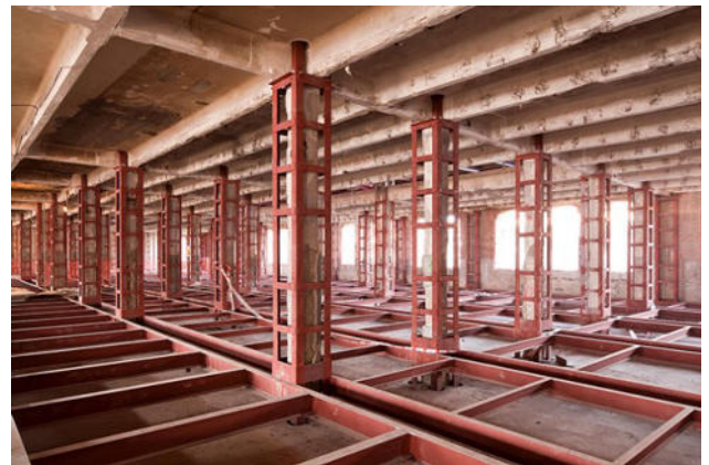
Figura 7. Nueva estructura metálica en nave 8.
