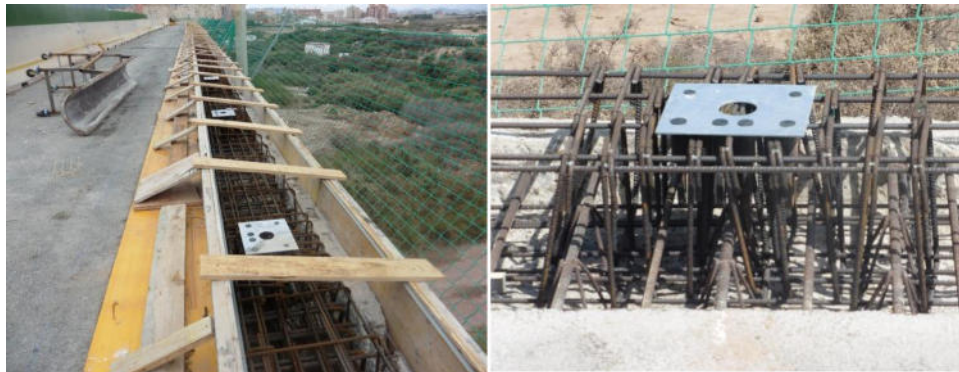
Figura 17. Ejecución de una solución concreta.
