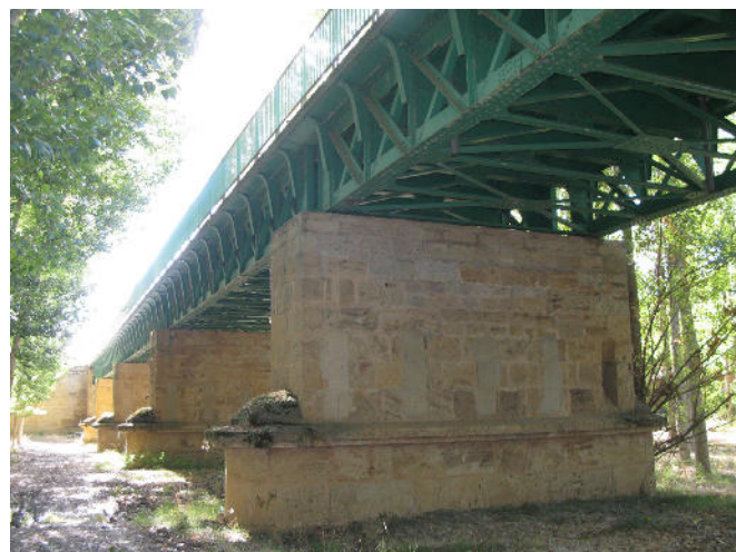
Figura 5. Vista del tablero metálico.
