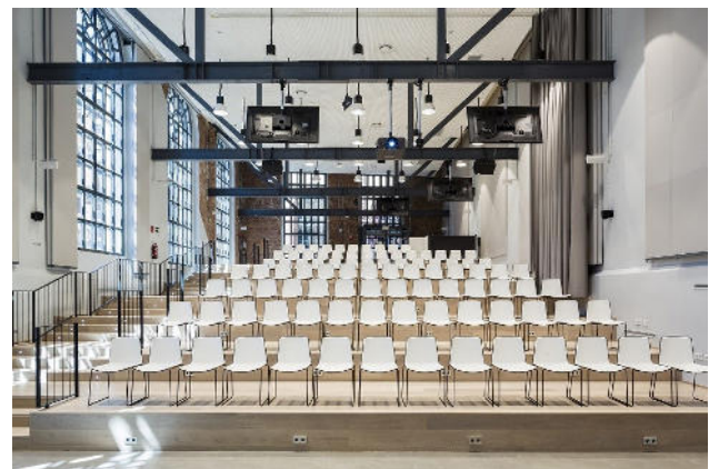
Figura 24. Auditorio del Google Campus Madrid, con las nuevas cerchas realizadas en base a las antiguas vigas de los forjados demolidos.
