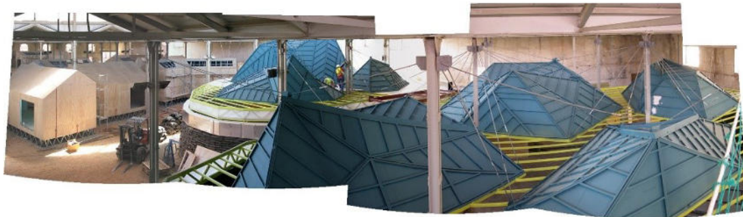
Figura 10. Nuevas estructuras de acero colgadas de la estructura principal de la nave.
