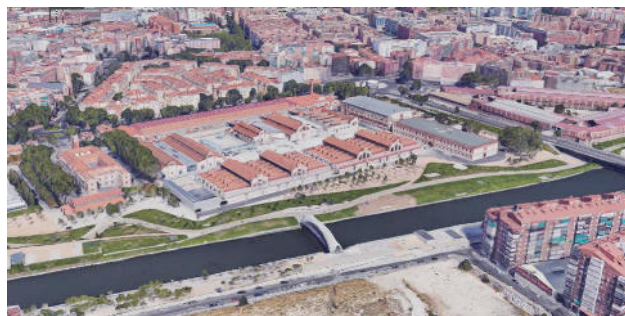
Figura 2. Vista aérea actual del conjunto del matadero de Madrid.
