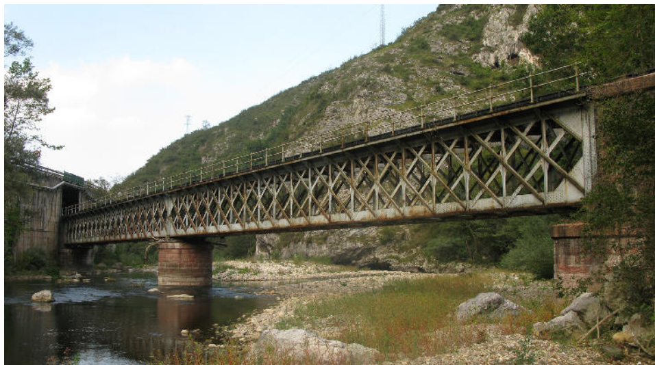
Figura 8. Vista general del puente desde aguas arriba.
