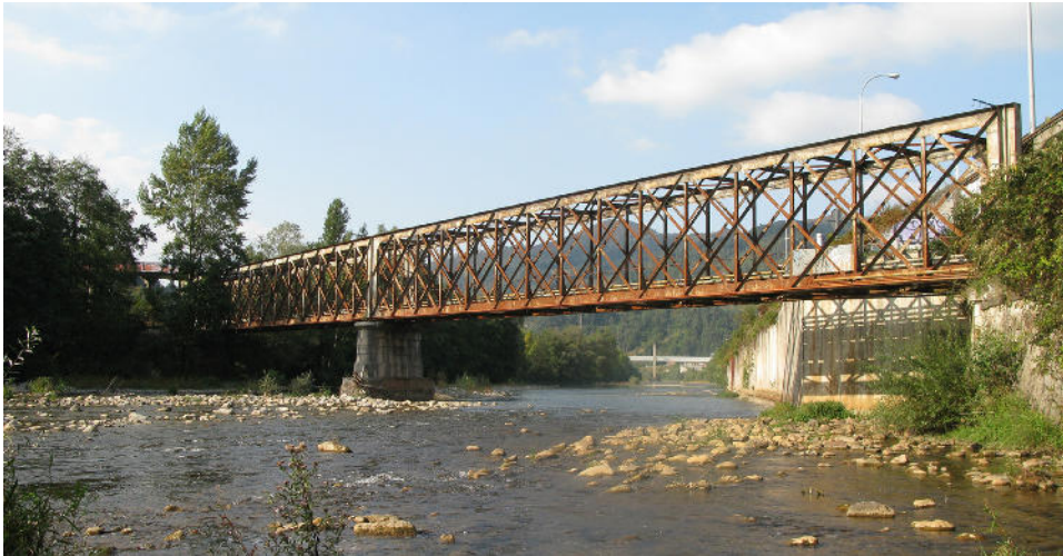
Figura 6. Vista general del puente.
