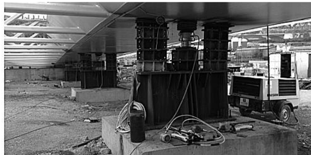
Figuras 29 y 30. Apoyo provisional, previamente a colocar la estructura y con el gato de apeo.
