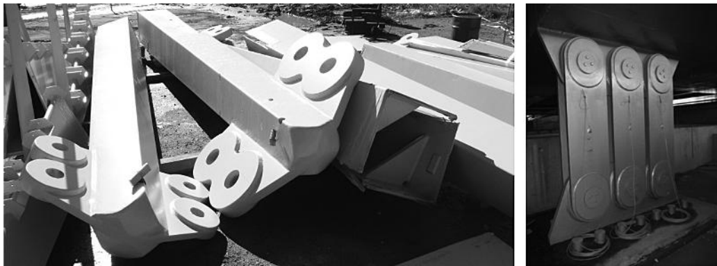
Figuras 35 y 36. Figura 35 (izquierda). Vista de mástiles acopiados en obra. Figura 36 (derecha). Bielas de retenida.
