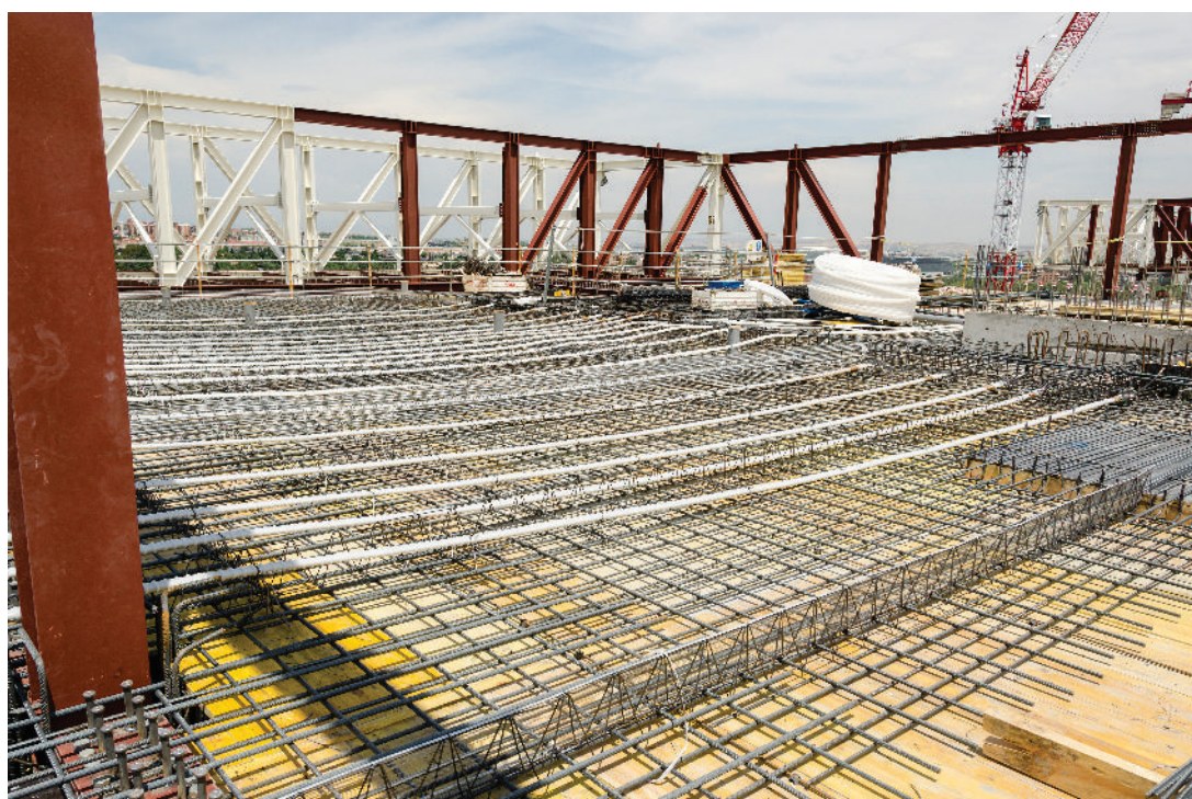
Figura 17. Colocación de armado y vainas planas de pretensado adherente (3 cordones/vaina). Plantas de bloque.
