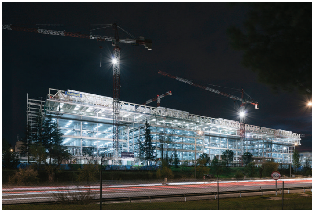
Figura 38. Imagen nocturna de las obras.
