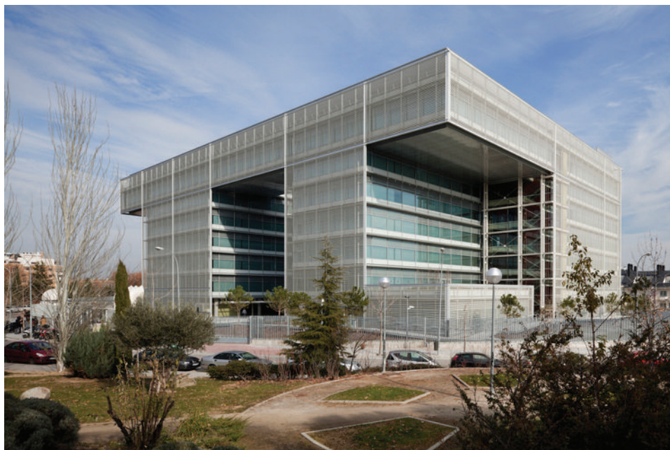
Figura 3. Edificio del nuevo Centro de Proceso de Datos en la calle Abelias (fase I) [1].
