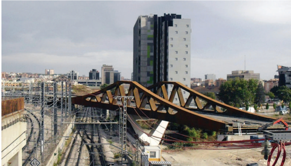
Figura 27. Viaducto de celosías peraltadas. Enlace ferroviario sobre la calle Comercio. MC2 Ingeniería (2010).
