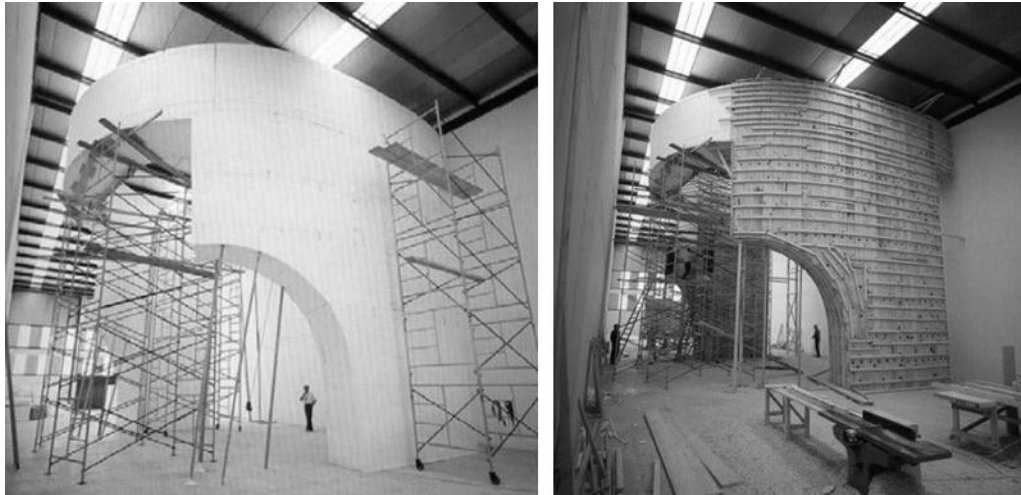
Figura 6. Maqueta de poliexpán realizada para la obra.
