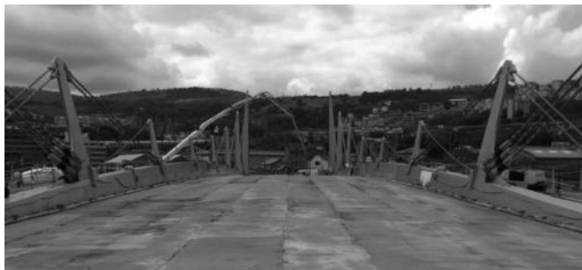
Figura 50. Hormigonado de la losa.
