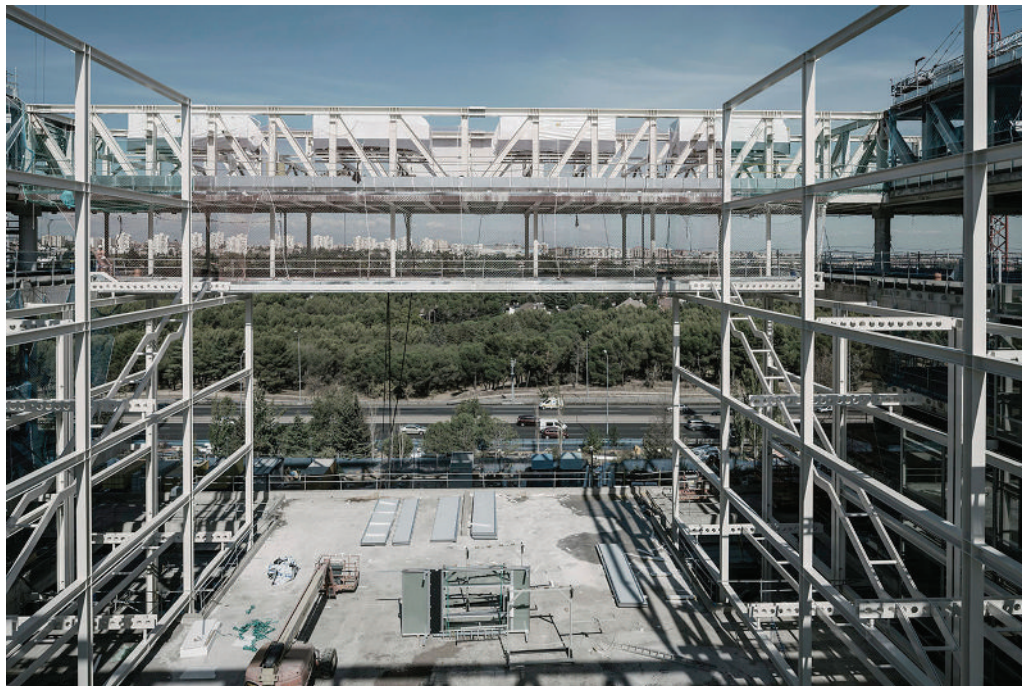
Figura 36. Imagen de la estructura del 'puente' norte' terminada.
