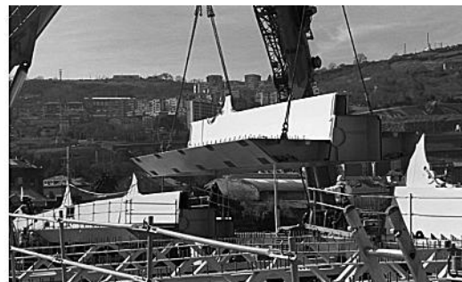
Figuras 31 y 32. Fabricación en taller e instalación de piezas metálicas en obra.
