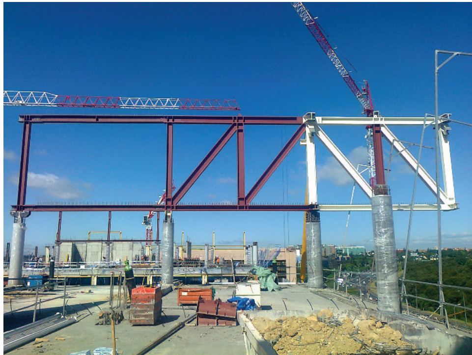
Figura 32. Montaje de celosías sobre soportes mixtos.
