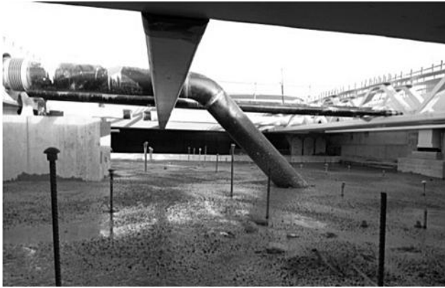
Figura 28. Hormigonado de contrapeso.
