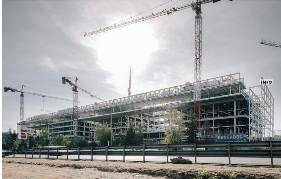
Figura 24. Vista de celosías en la fachada norte.
