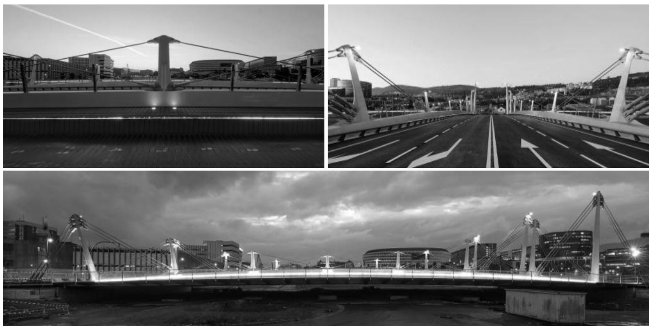
Figuras 51-53. Vistas del puente terminado (Fotos: Carlos Garmendia).
