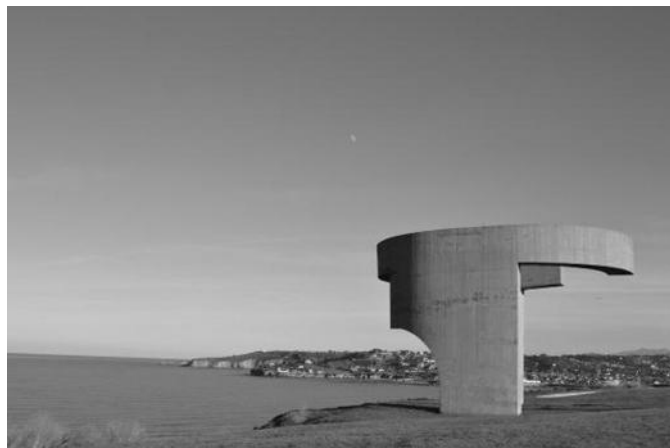
Figura 11. Estado final de la obra.
