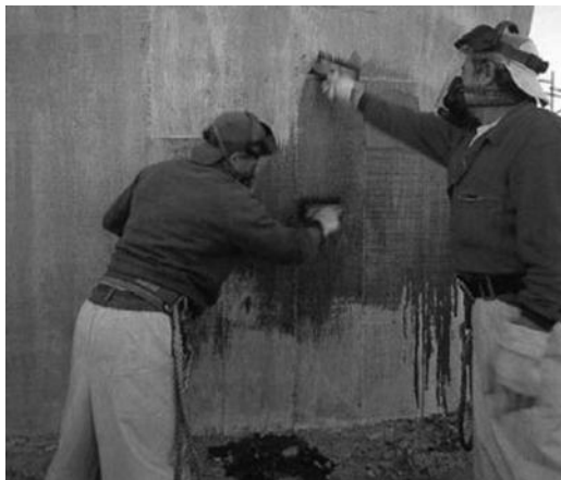
Figura 9. Limpieza final del hormigón.
