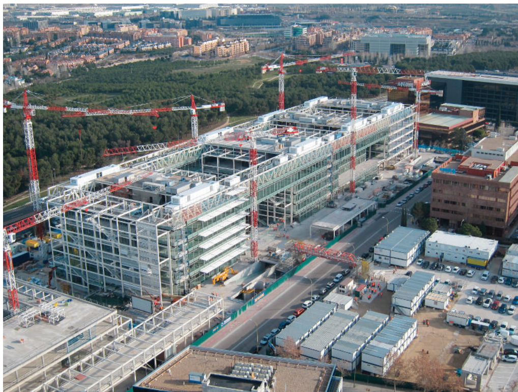
Figura 39. Estado de las obras con la estructura terminada.
