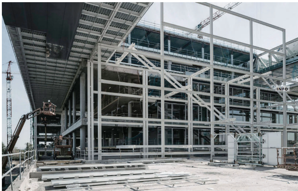
Figura 21. Estructura metálica exterior y escaleras de evacuación.
