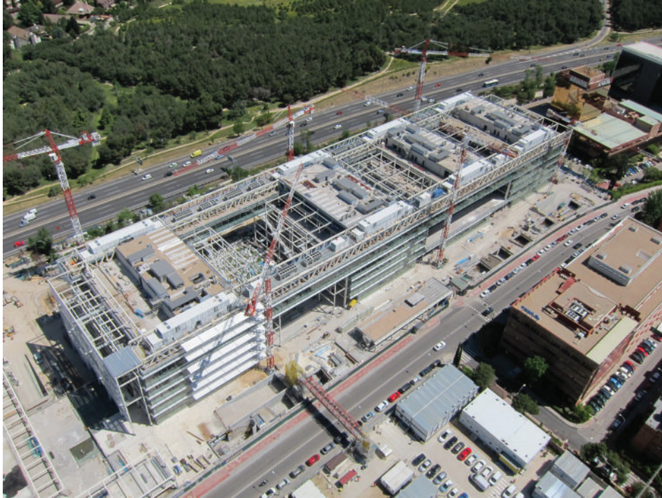
Figura 9. Vista general de la cubierta (mayo 2016).
