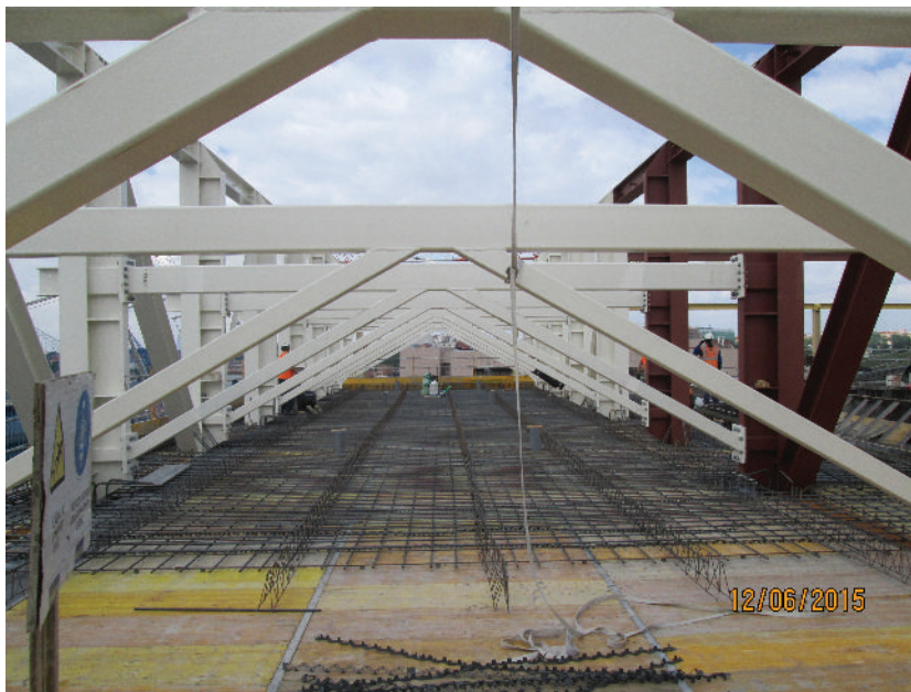
Figura 25. Bancadas integradas en la estructura de cubierta.
