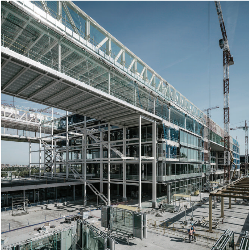
Figura 29. Imagen de la estructura de cubierta y zona entre bloques.
