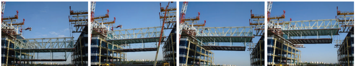
Figura 34. Izado de puente sur.
