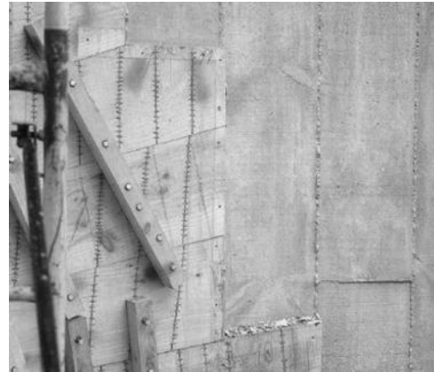
Figura 7. Marcado del encofrado.
