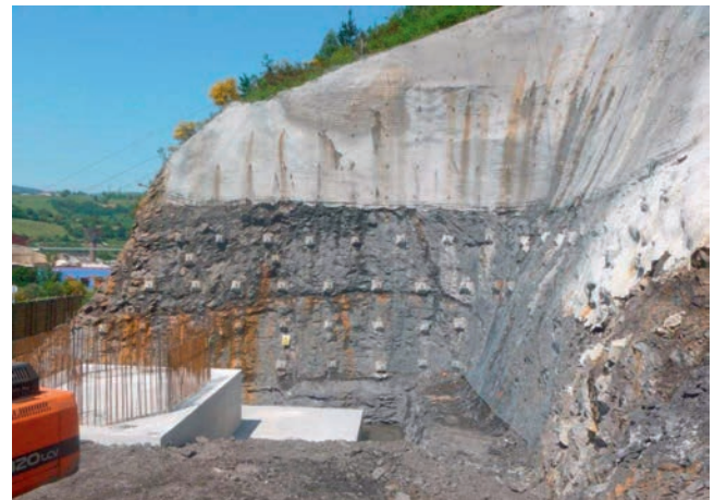
Figura 17. Excavación de la cimentación de P-10, con bulones y gunitado de las laderas.
