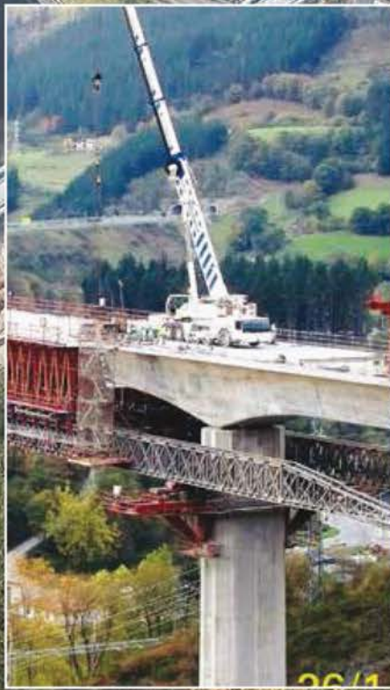
Ejecutado con autocimbra. Luz máxima de 80 m
