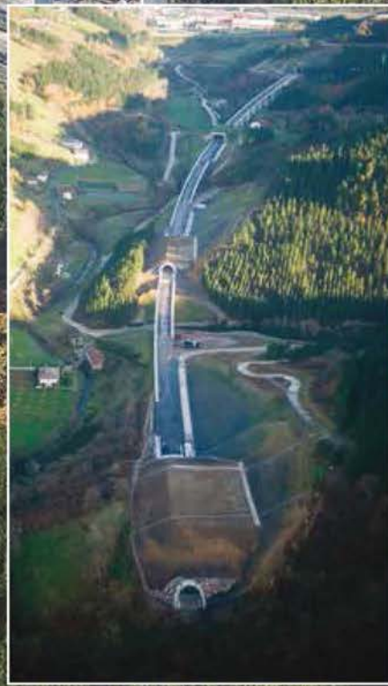
Tramo heterogéneo y complejo con túneles y múltiples estructuras
