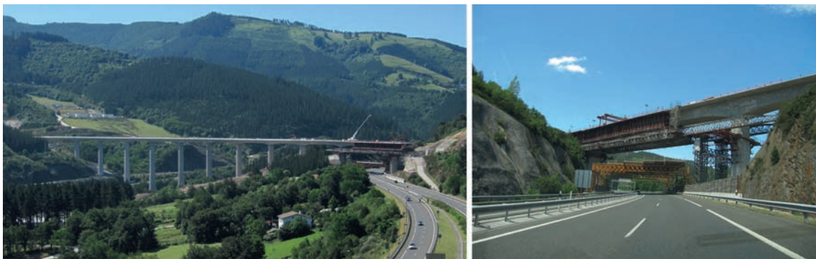
Figura 30. Imágenes de la autocimbra sobre la AP-1 con el vano de 80 m, actual récord de luz de España en alta velocidad ejecutado con autocimbra.
