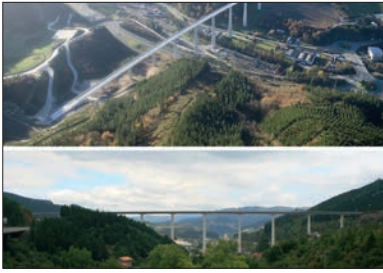
Foto de portada: Viaducto del río Deba en la "Y Vasca" de A.V. | Guipúzcoa
