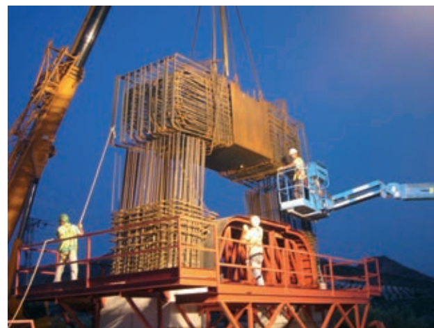
Figura 17. Ejecución de los alzados de las pilas mediante encofrado trepante y montaje de la ferralla prefabricada del dintel Figure 17. Execution of pier shafts with climbing scaffoldings and assembling of precast rebar modules of pierhead
