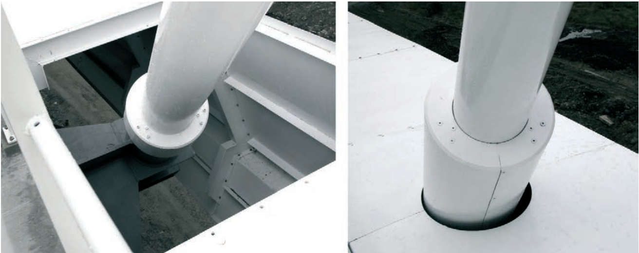
Figura 31. Imposta metálica. Figure 31. Steel fascia beam.
