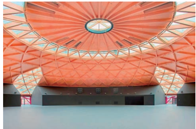
Bajo cubierta del Centro comercial y de ocio Las Arenas (Barcelona)
