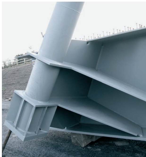
Figura 20. Anclaje de un tirante en el tablero Figure 20. Deck anchorage of a cable
