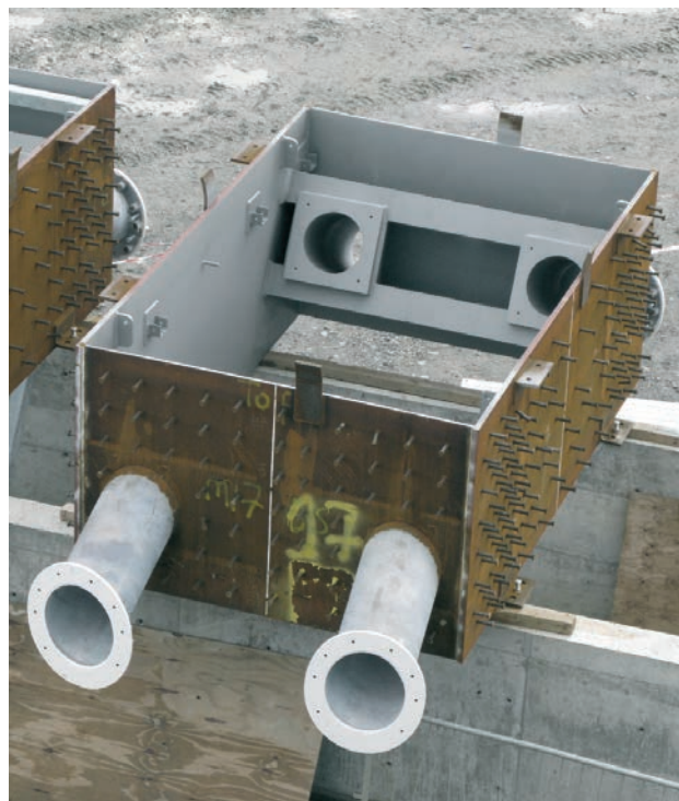
Figura 10. Cajón de anclaje de tirantes en torre Figure 10. Anchorage box for the pylon
