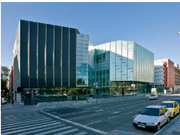
Vista general de los Teatros del Canal (Madrid)
