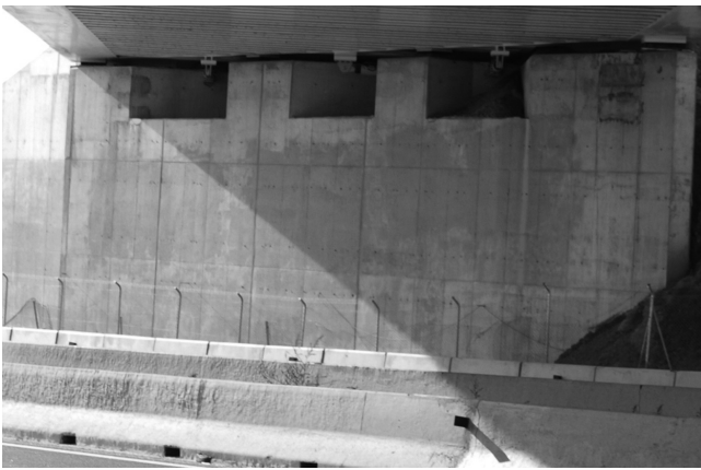
Figura 11. Vista del alzado de un estribo
