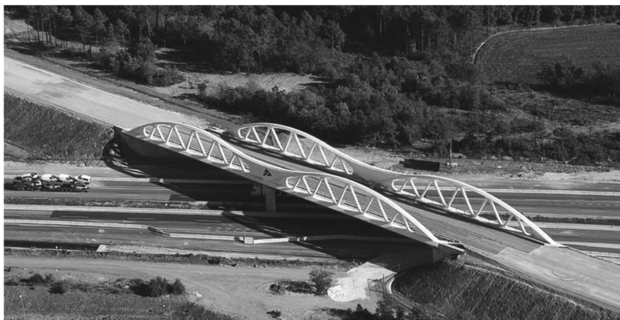
Figura 26. Vista del puente terminado
