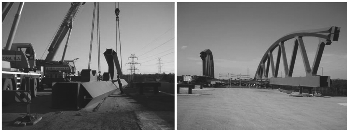
Figura 19. Ensamblaje de las celosías en obra
