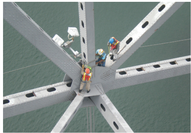
Figura 8. Ensayos de materiales en el reticulado Figure 8. Materials testing in trusses
