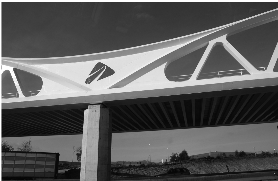
Figura 16. Zona de apoyo en pila
