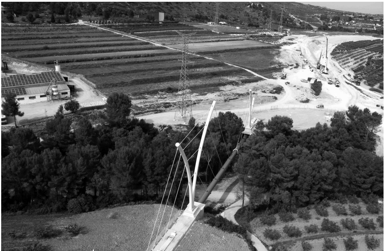
Figura 11. Vista aérea de la estructura terminada
