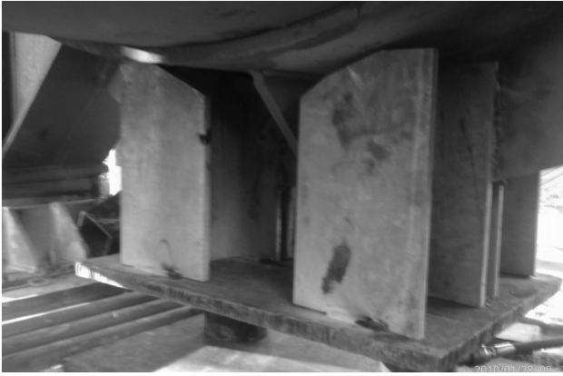
Figura 8. Gatos hidráulicos para izado de la estructura
