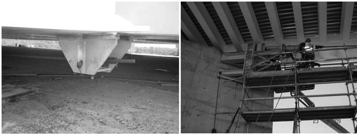
Figura 22. Disposición de las barras de tiro
