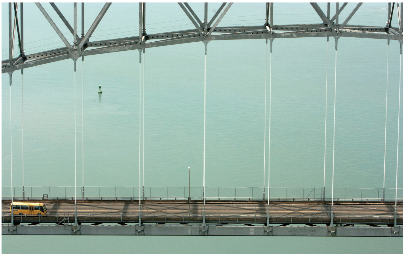
Figura 51. Vista del puente provisto con las nuevas péndolas Figure 51. View of the bridge equipped with new hangers
