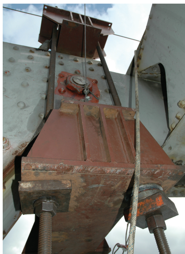
Figura 17. Balancín para la sustitución de bulones Figure 17. Rocker for the pins replacement
