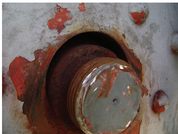
Figura 15. Estado original de los bulones de 5" Figure 15. 5" pins original condition
