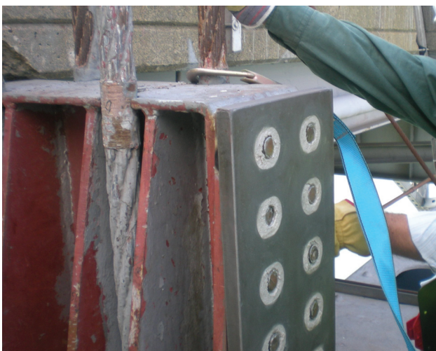
Figura 34. Unión calce y estructura preparada para la colocación de las nuevas horquillas Figure 34. Shim union and the prepared structure for the installation of the new lifting forks
