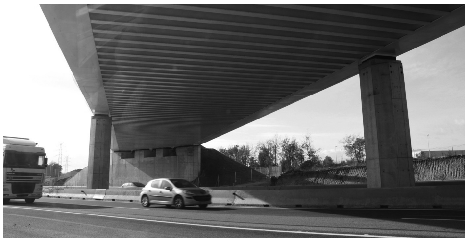
Figura 7. Vista inferior del paso
