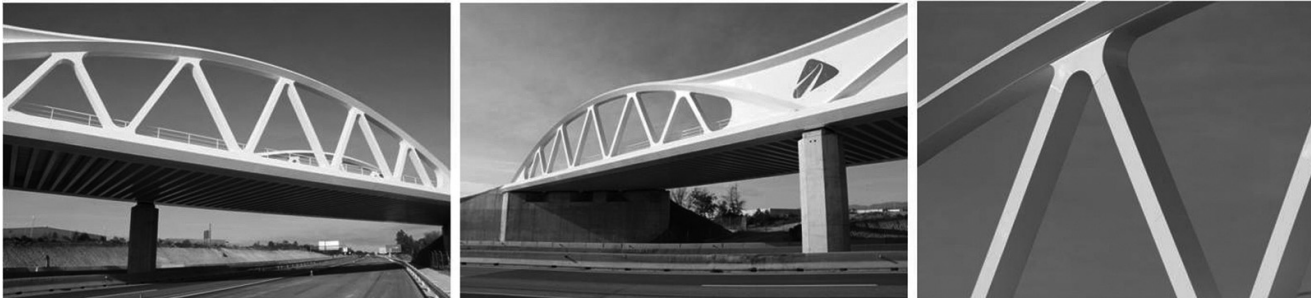
Figura 3. Vistas del puente
