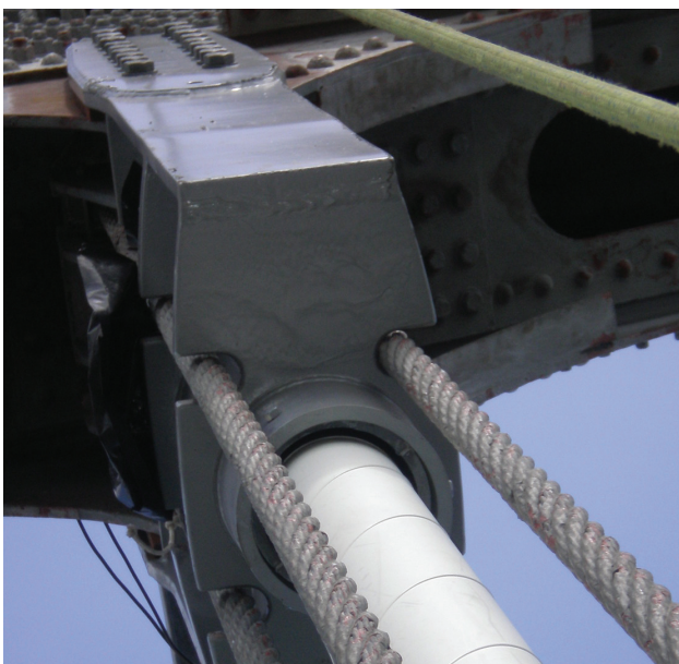
Figura 36. Nueva péndola colocada en la horquilla entre los cables originales Figure 36. New hanger installed in the lifting fork between the original cables
