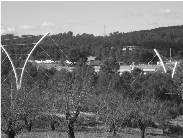
Figura 9. Perfil de la estructura terminada
