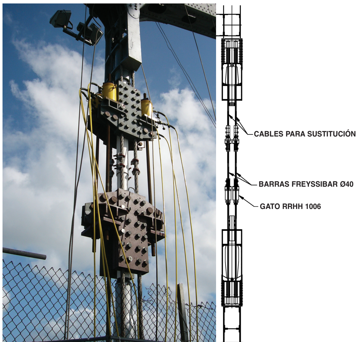
Figura 38. Mordaza durante el proceso de sustitución de péndolas Figure 38. Clamp during replacement of hangers
