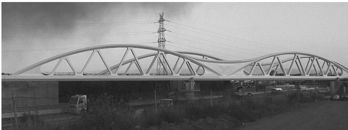
Figura 1. Vista del paso
