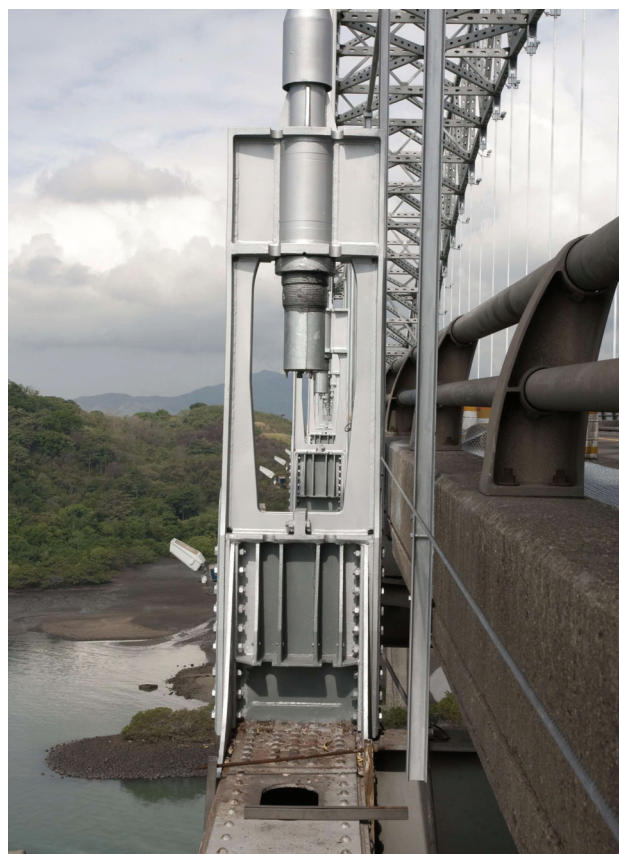
Figura 25. Detalle del anclaje inferior y la conexión con el tablero de la nueva péndola
