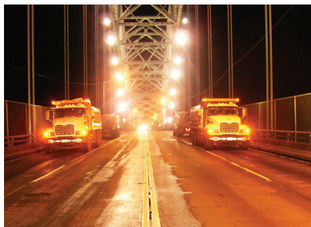
Figura 9. Prueba de carga con camiones Figure 9. Load test with trucks
