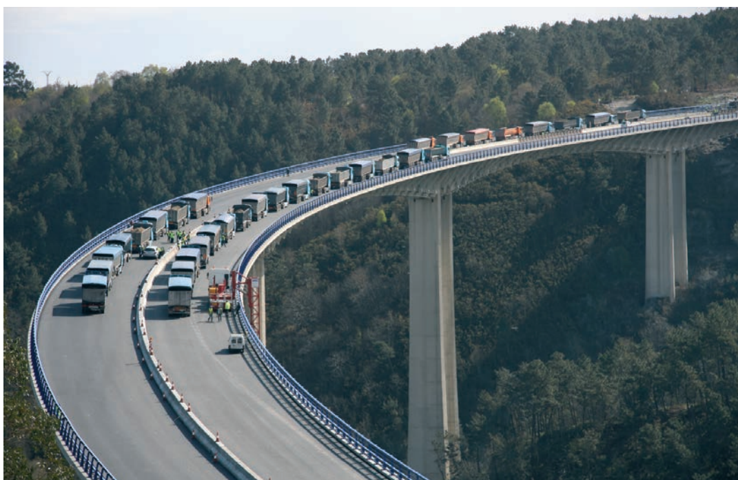
Figura 41. Realización de la prueba de carga Figure 41. Load test of the bridge
