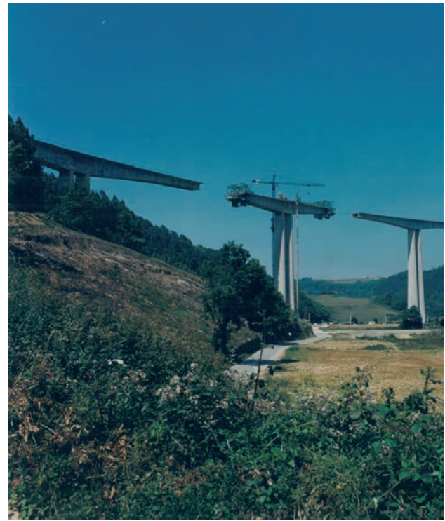
Figura 3. Construcción del viaducto original Figure 3. Construction of the existing bridge
