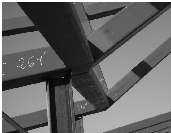
Figura 25. Dificultades para alinear las barras transversales sin dejar resquicios
