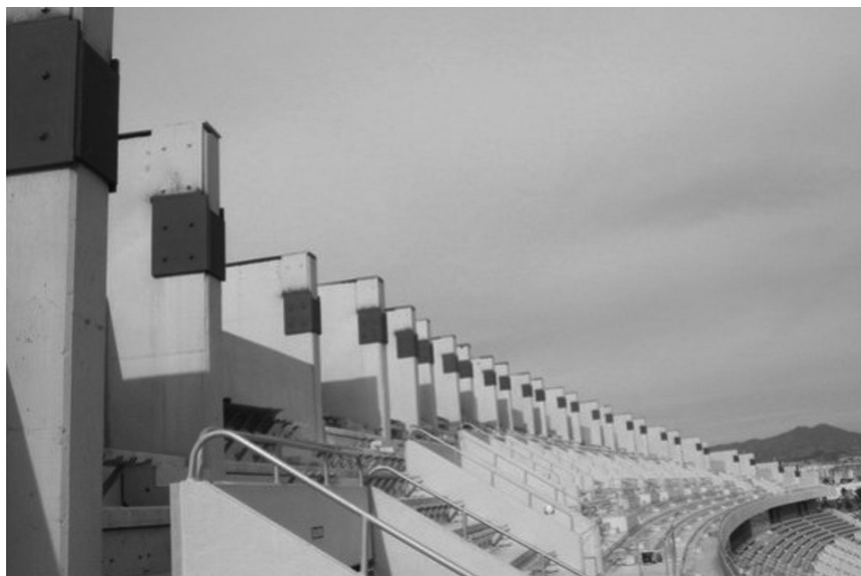
Figura 7. Anclajes preparados para el encuentro de la malla con los machones. La parte suplementada se muestra en tono oscuro hasta totalizar 1.50 m de canto
