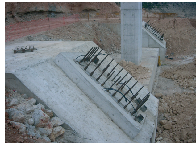
Figura 11. Cimentación de los arcos Figure 11. Arch foundations
