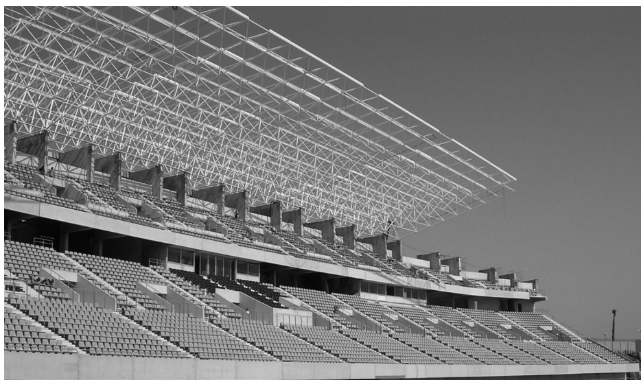
Figura 2. Estructura anterior apoyada sobre pantallas radiales
