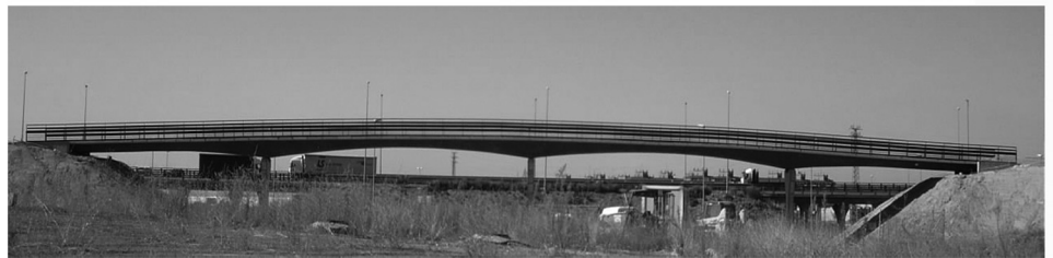
Pasarela peatonal en Alcorcón (Madrid)
