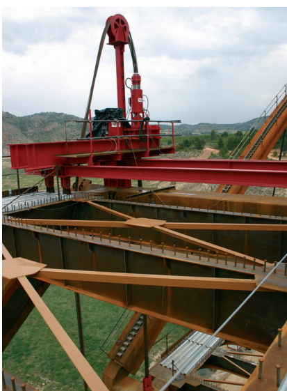
Figura 19. Gatos de izado Figure 19. Hoisting jacks
