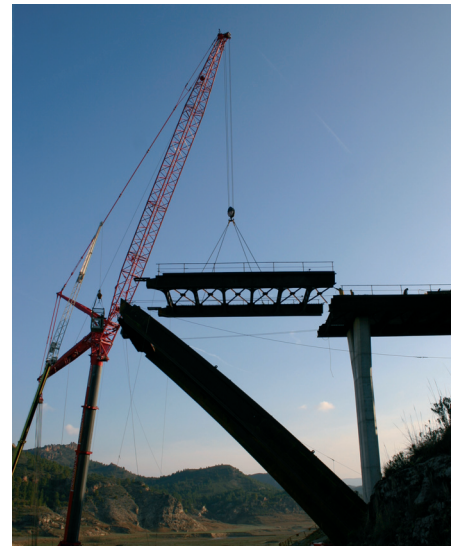
Figura 18. Voladizo (III). Tablero del voladizo Figure 18. Cantilever (III). Cantilevered deck
