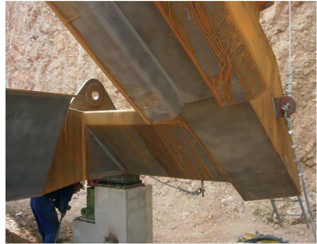
Figura 48. Bowstring: Muñón de riostra, gato de desapeo, orejeta de izado Figure 48. Bowstring: bracing stump, de-shoring jack, hoisting stud
