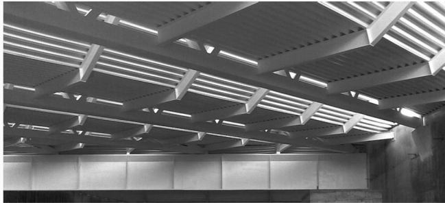
Cubierta de la Biblioteca Municipal de Carabanchel (Madrid)
