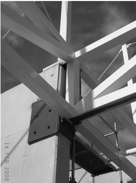
Figuras 19 y 20. Se aprecia la sencillez con que la nueva cubierta intesta en los machones de hormigón preexistentes
