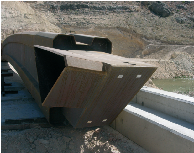
Figura 47. Muñón de voladizo con dianas de replanteo Figure 47. Cantilever stumps with stake-out targets
