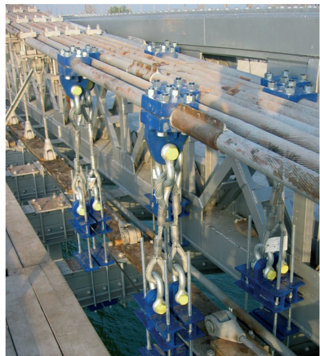
Figura 8. Péndolas provisionales cortas. Figure 8. Provisional short suspenders.
