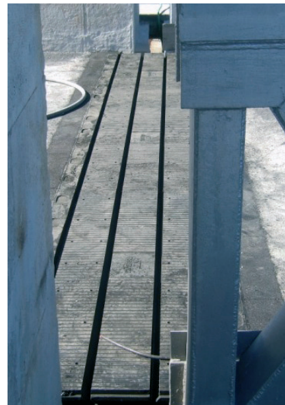
Figura 37. Junta de la calzada. Figure 37. Carriageway joint.
