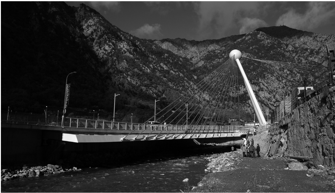
Figura 24. El puente de Madrid terminado.
