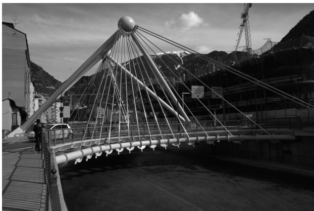
Figura 6. Vista del puente de París desde aguas abajo.
