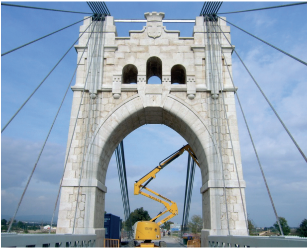
Figura 34. Pilono una vez rehabilitado. Figure 34. Rehabilitated pier.
