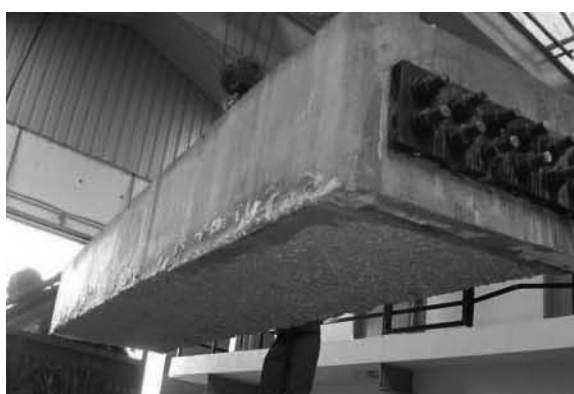
Figura 36. Estado de la cara inferior de la pieza tras el ensayo piloto. No se aprecian signos de spalling .
