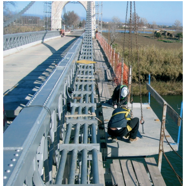
Figura 6. Trabajos de colocación de las aceras prefabricadas. Figure 6. Laying precast walkway slabs.
