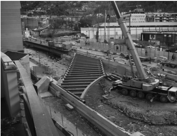
Figura 10. Montaje de la primera fase del tablero.
