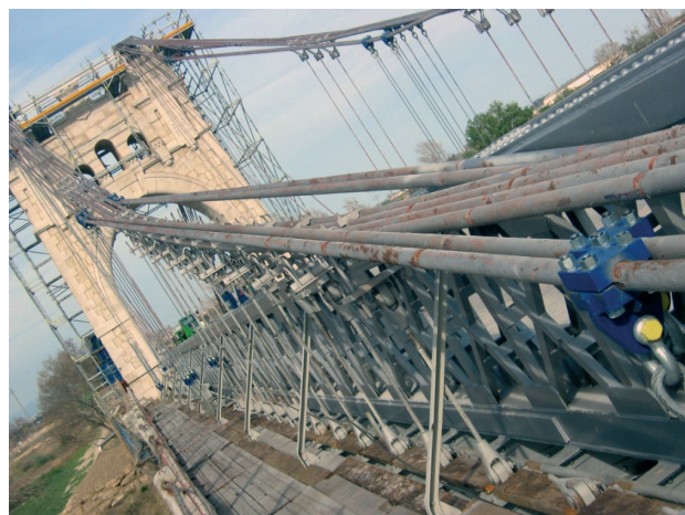
Figura 13. Sistema de cables durante la transferencia inicial de cargas.
