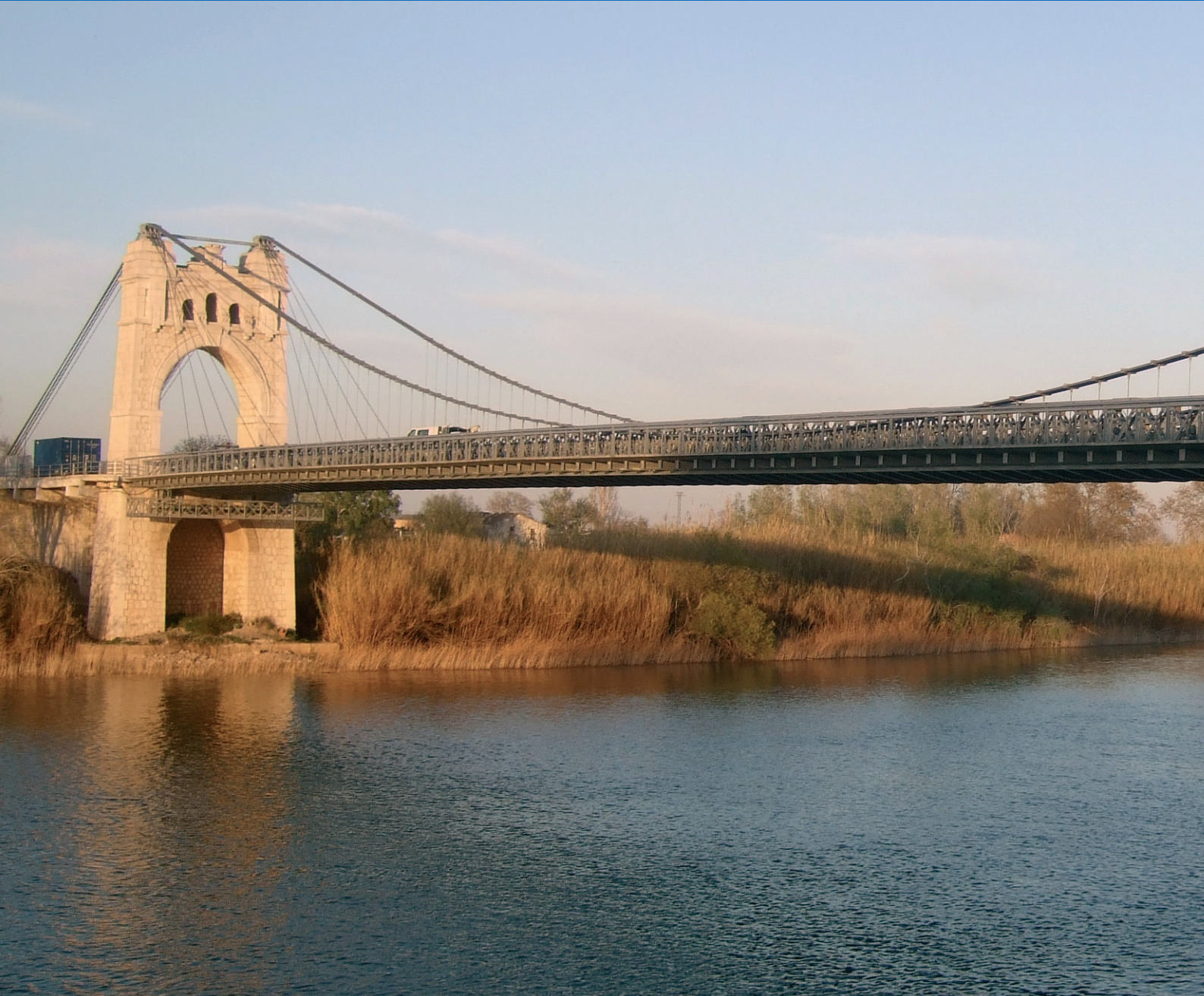
Puente de Amposta
