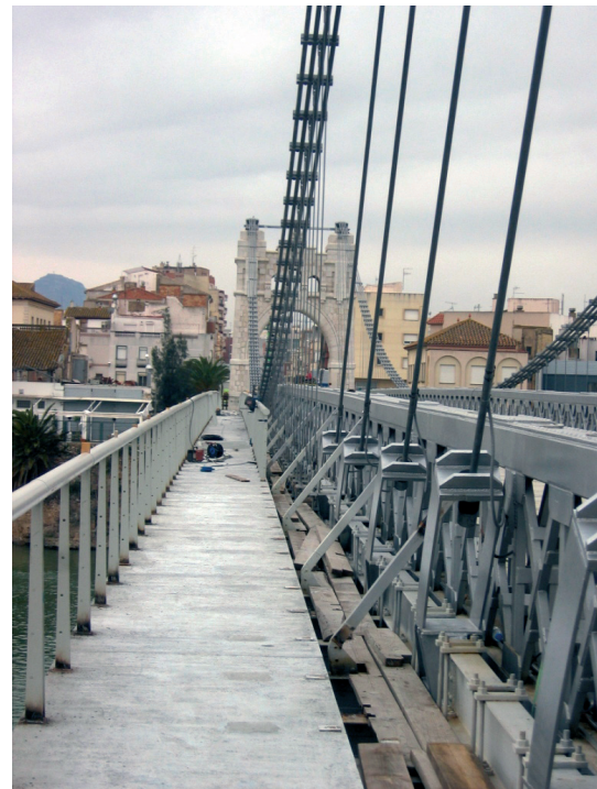
Figura 26. Nuevos tirantes y sus terminales. Figure 26. New stays and terminals.
