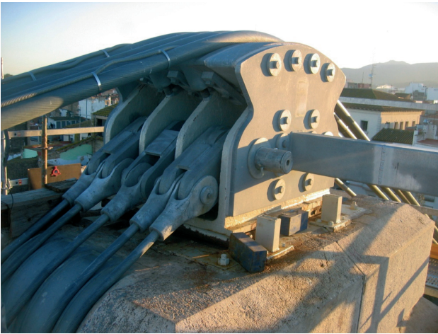
Figura 27. Una de las sillas rehabilitada, mostrando la cara de los terminales de tirantes.
