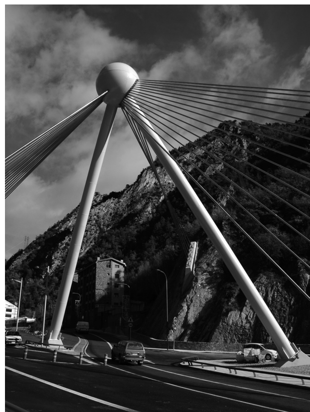
Figura 14. Bípode de apoyo de la esfera.
