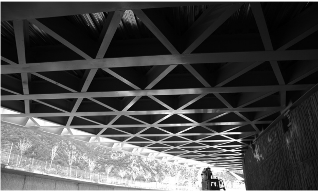
Figura 16. Vista inferior del tablero.
