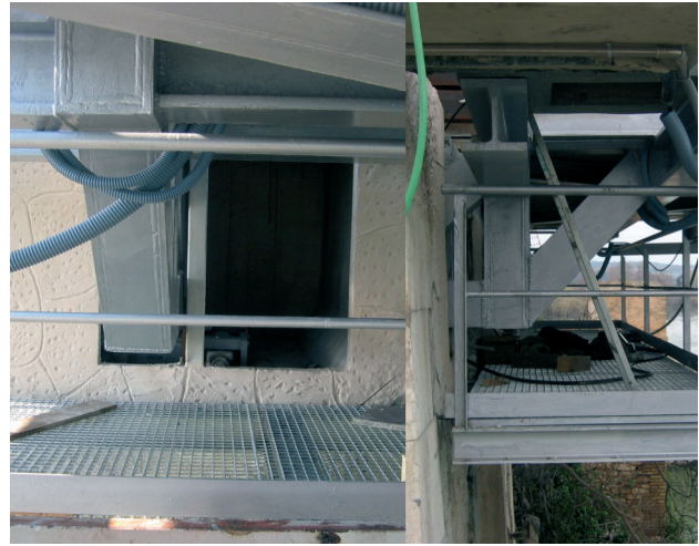
Figura 32. Exterior de las cámaras de apoyos y sus accesos. Figure 32. Support chamber exteriors and accesses.
