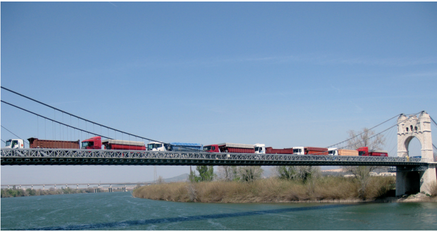
Figura 38. Prueba de carga. Figure 38. Load test.
