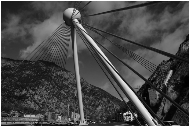
Figura 20. Tirantes soporte del tablero y tirantes de fijación de la esfera.
