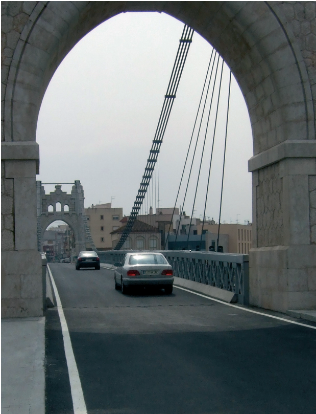
Figura 39. Tablero terminado. Figure 39. Finished deck.
