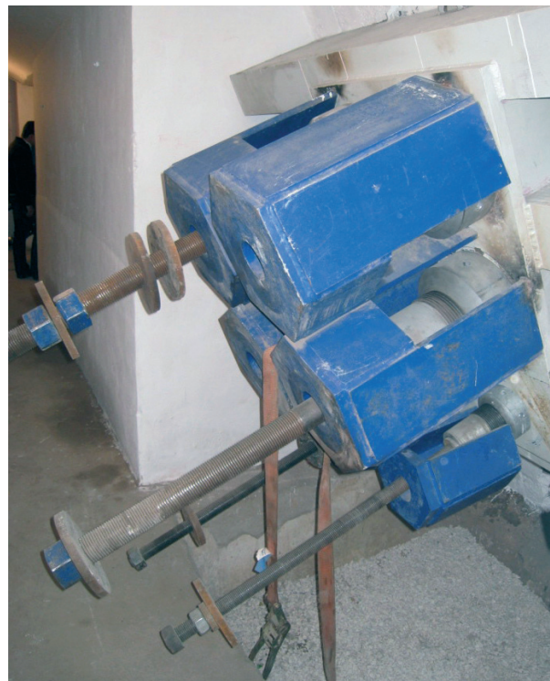
Figura 33. Interior de las cámaras de anclaje rehabilitadas. Figure 33. Rehabilitated anchorage chamber interiors.
