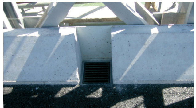
Figura 36. Detalle de sumideros y bordillo. Figure 36. Detail of sump and kerb.
