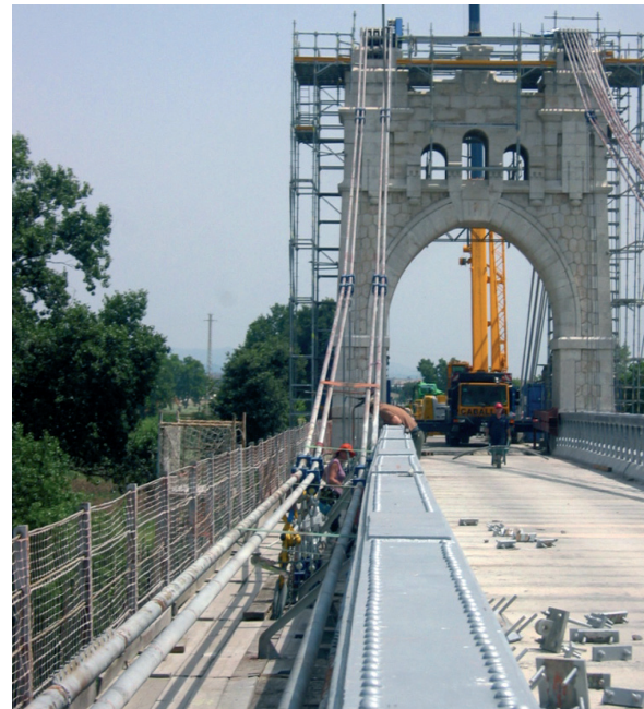
Figura 15. Sistema de cables finalizada la transferencia de cargas a las péndolas provisionales.
