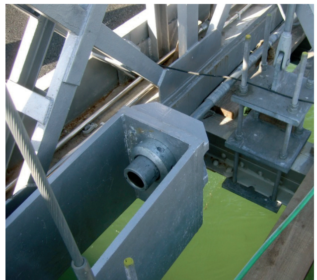
Figura 29. Nuevo cable horizontal y su terminal activo.
