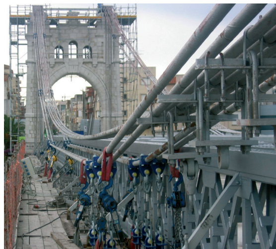
Figura 14. Retirada de péndolas con eslingas y polipastos.
