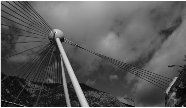
Figura 15. Tirantes anclados en la roca.
