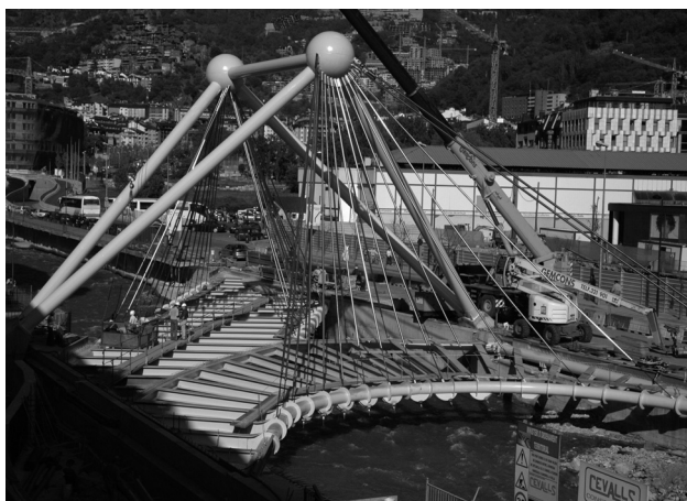
Figura 9. Estructura del tablero del puente de París.
