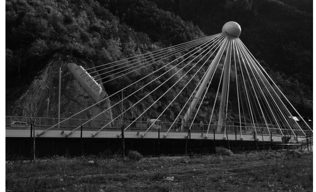
Figura 2. Puente de Madrid.
