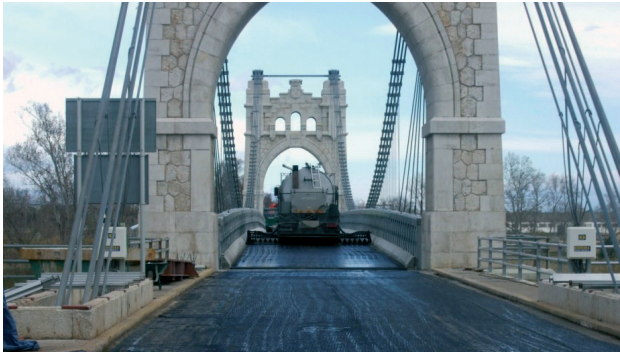
Figura 35. Trabajos de pavimentación. Figure 35. Paving operations.
