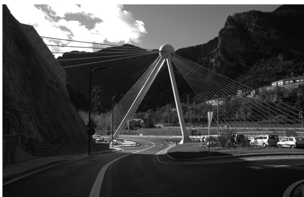
Figura 13. Puente de Madrid.
