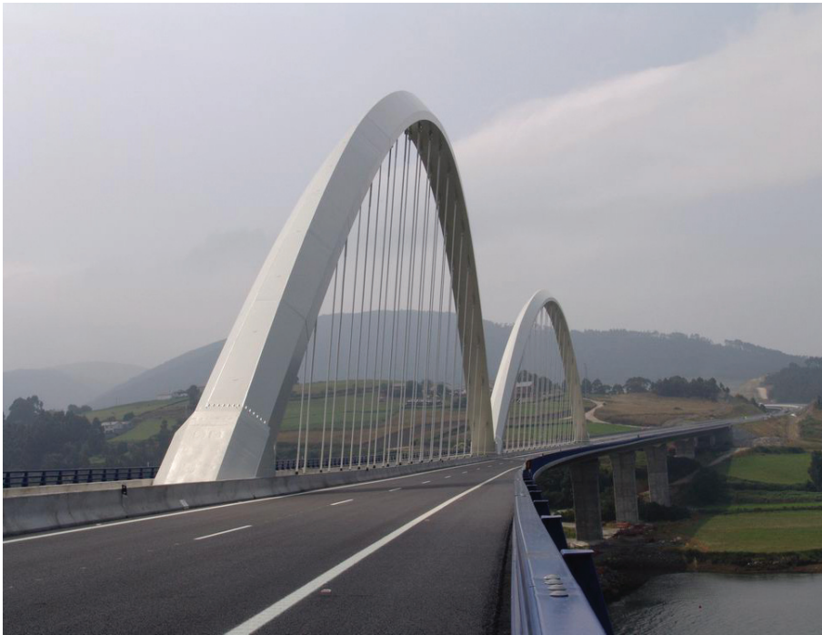
Figura 24. Viaducto terminado. Figure 24. Finished viaduct.
