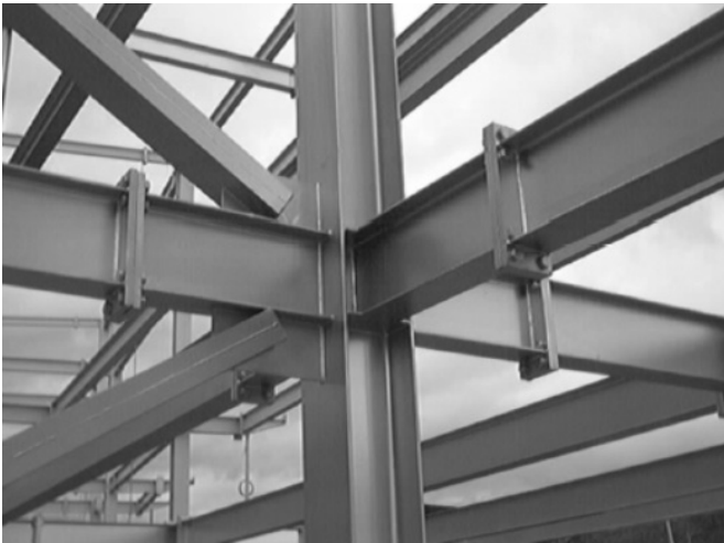
Figura 6. Detalles de las conexiones.
