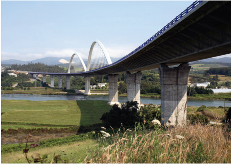
Foto de portada: Viaducto de Navia.
