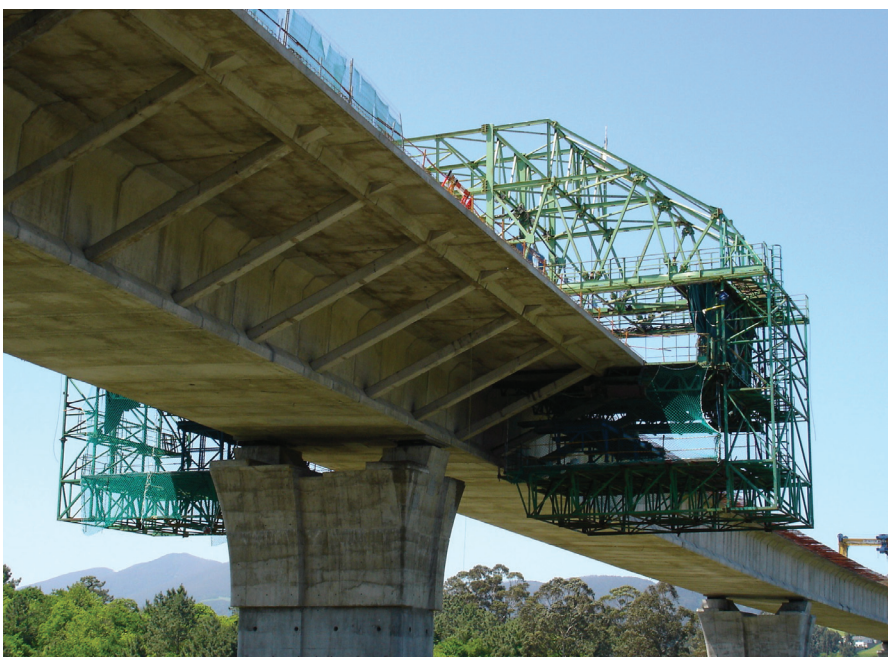
Figura 18. Hormigonado de voladizos. Figure 18. Cantilever casting.
