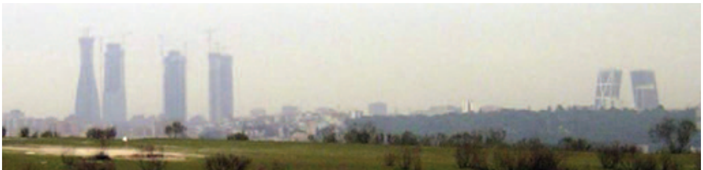
Figura 3. Imagen del avance de la construcción y su irrupción progresiva en el "skyline" de la ciudad. Figure 3. Image of the progress of the work and its growing presence in the city's skyline.
