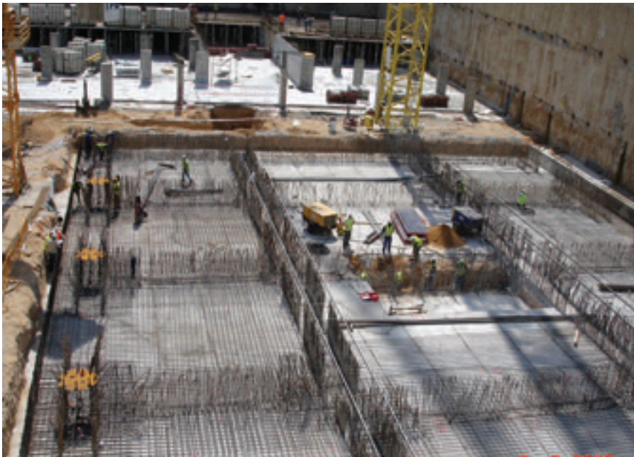
Figura 7. Armado de la losa de cimentación. Figure 7. Foundation slab reinforcement.
