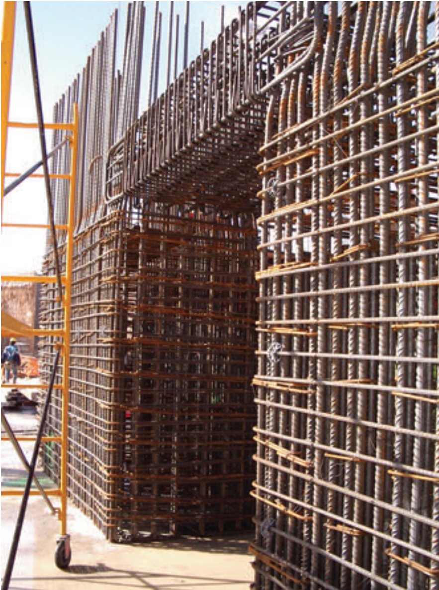
Figura 5. Armadura del núcleo central en sótano 6 de Torre Espacio. Figure 5. Torre espacio's central core reinforcement in basement 6 .
