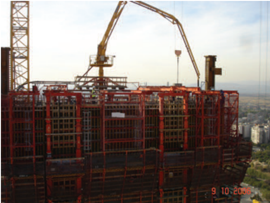
Figura 7. Distribuidor de hormigón. Figure 7. Concrete distributor.
