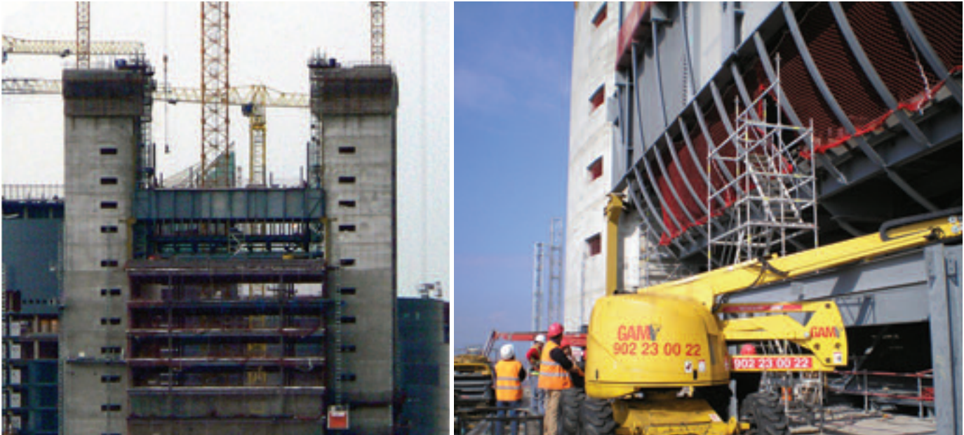
Figura 27. Vistas del arco previo a su izado. Figure 27. Arch prior to positioning.
