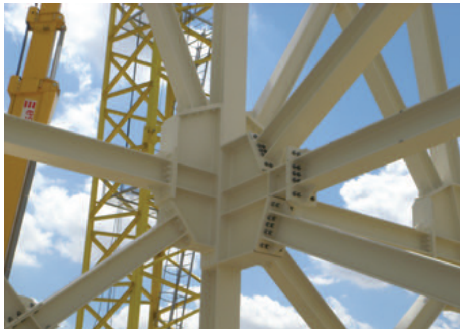
Figura 14. Nudo atornillado en la estructura de coronación. Figure 14. Bolted junction in the crown structure.
