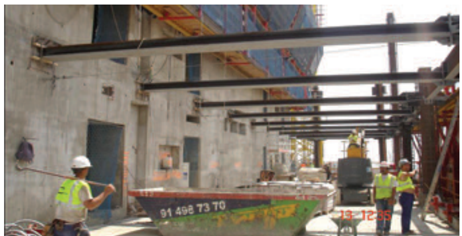
Figura 11. Vigas de soporte del forjado. Figure 11. Beams that support the floor slab.
