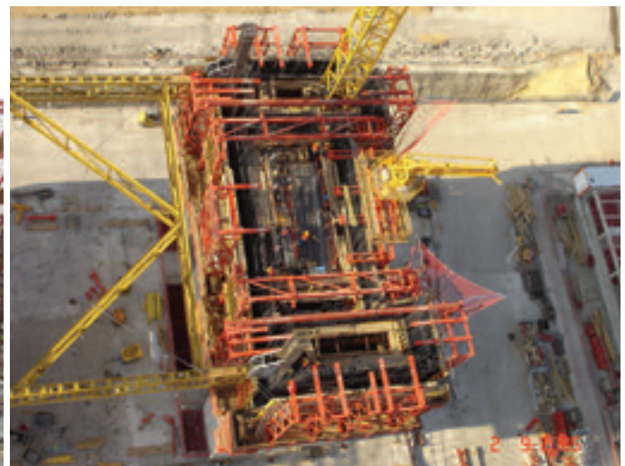
Figura 12. Estructura del encofrado autotrepante Figure 12. Slipform structure.
