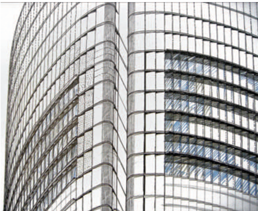
Figura 9. Pliegues entre las zonas en las que se divide la planta para poder facilitar el acceso de la luz al núcleo de comunicaciones. Figure 9. Folds between the different sections of the floors to facilitate the passage of light to the communications core.
