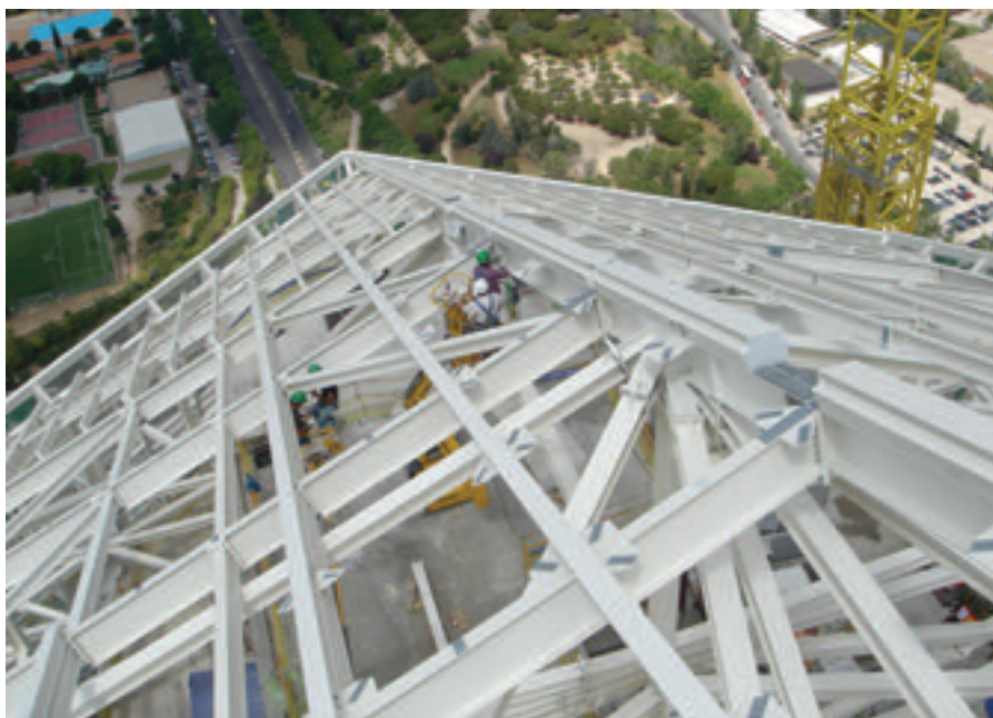
Figura 27. Vista superior de la Cubierta. Figure 27. Upper view of the roof.
