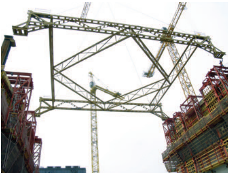
Figura 23. Escantillón para replanteo de pilares embebidos. Figure 23. Template for staking out embedded columns.
