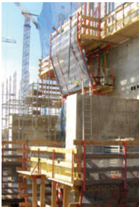
Figuras 12 y 13. Encofrado Autoretente. Figures 12 and 13. Slipforms.
