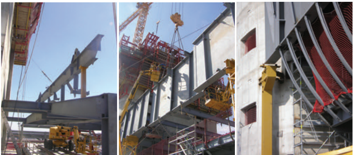
Figura 25. Fases de montaje de las jácenas y la estructura del arco. Figure 25. Girders and arch - three construction stages.
