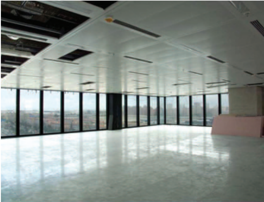
Figura 7. Vista de una planta diáfana desde el interior. Figure 7. View of an obstacle-free storey from inside.
