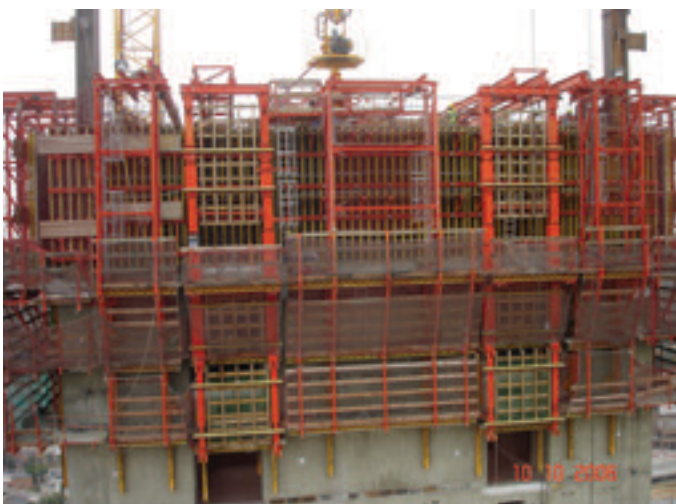
Figura 12. Estructura del encofrado autotrepante Figure 12. Slipform structure.
