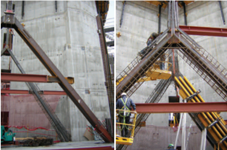
Figura 14. Montaje de la triangulación de la estructura de apeo de soportes. Figure 14. Assembly of the shoring structure of the supports.
