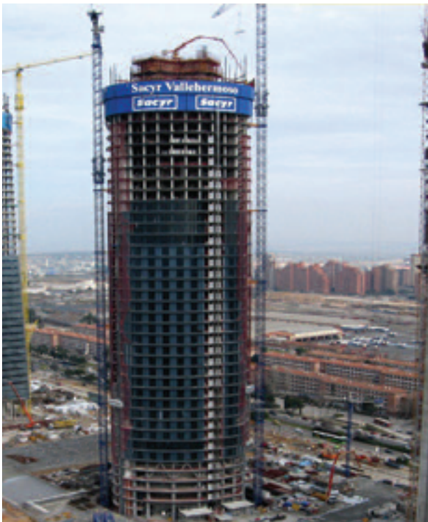
Figura 16. Ciclo tipo e instantánea de la obra en fase de máxima producción.
