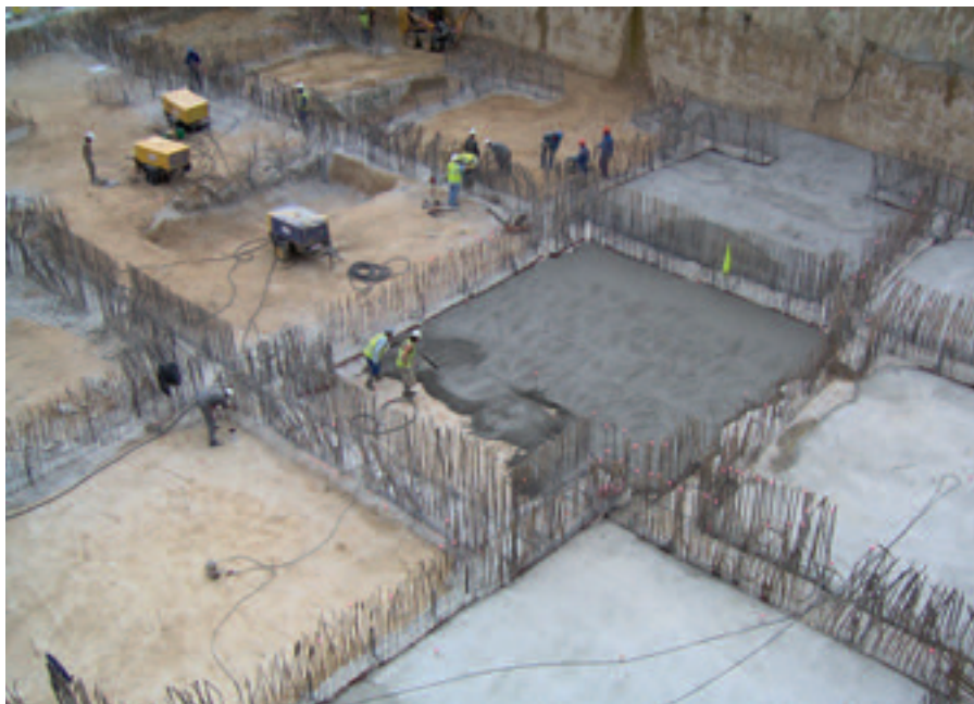
Figura 8. Cimentación. Vista general. Figure 8. Foundations. Overview.
