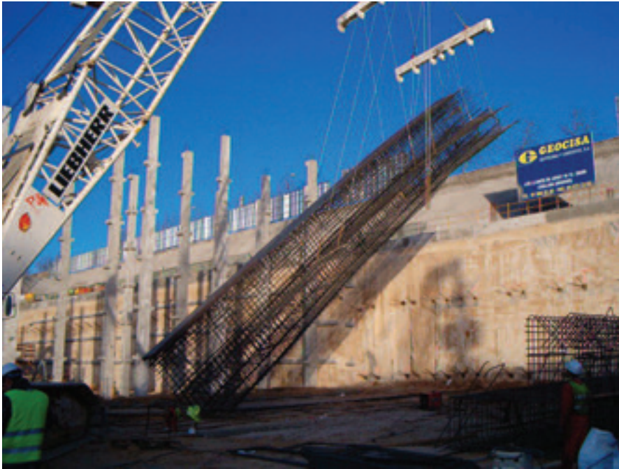
Figura 5. Izado de la ferralla de un panel de pantalla. Figure 5. Hoisting a diaphragm wall rebar panel.
