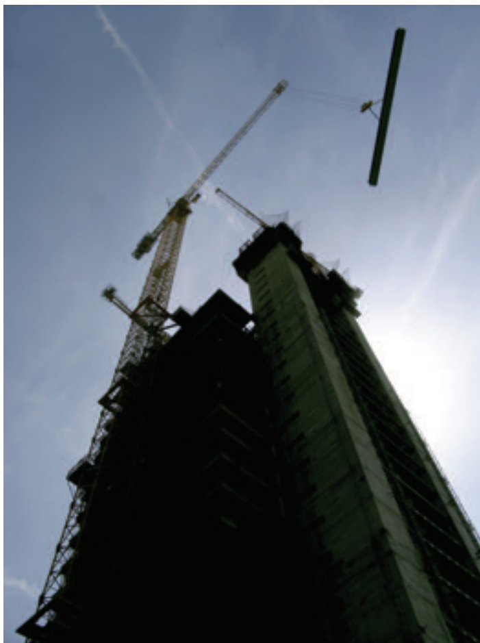
Figura 1. Vista general de construcción Figure 1. General view
