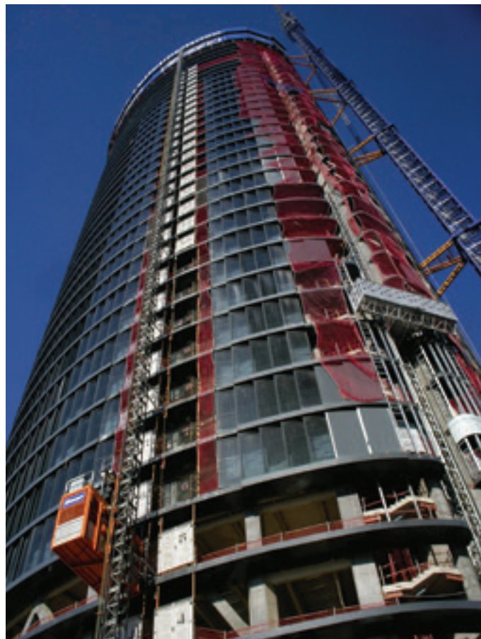
Figura 1. Vista general de la torre en una fase intermedia de su construcción. Figure 1. General view of the tower at an intermediate stage of construction.
