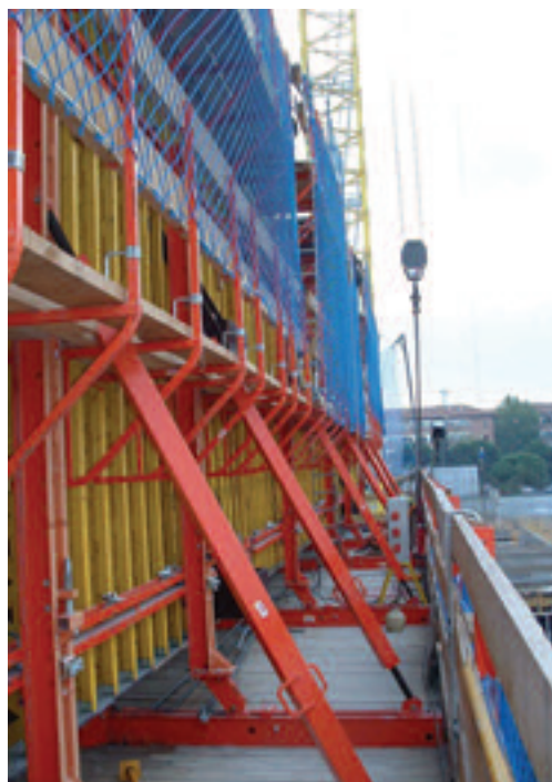
Figura 9. Encofrado autotrepante. Figure 9. Slipforms.
