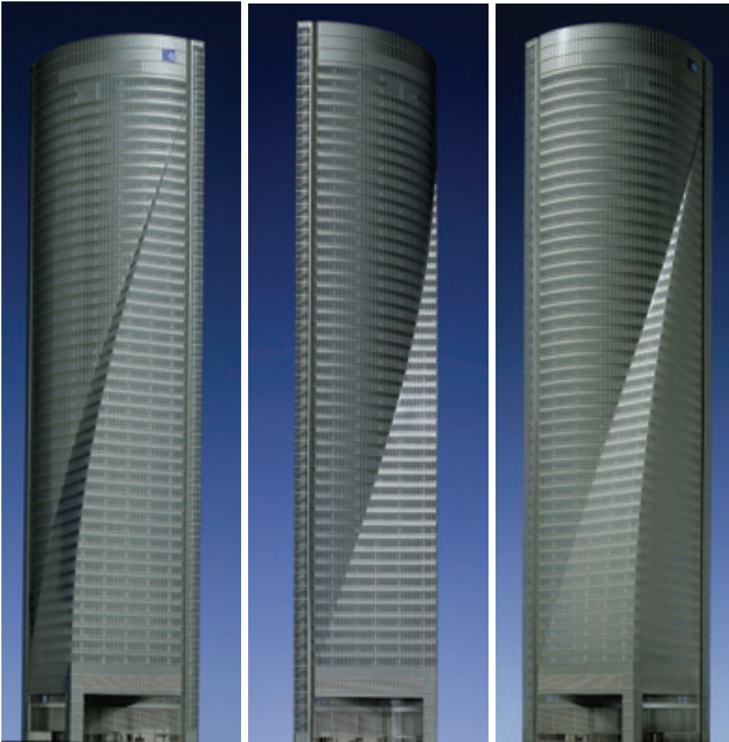
Figura 2. El modelo digital del edificio Torre Espacio desde diferentes puntos de vista. Figure 2 – The Torre Espacio building's digital model from different points of view.
