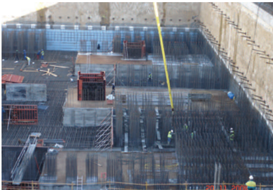
Figura 8. Fases de hormigonado de losa. Figure 8. Slab concreting.
