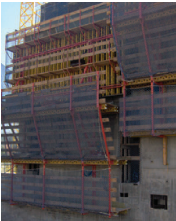
Figura 8. Encofrado autotrepante. Figure 8. Slipforms.
