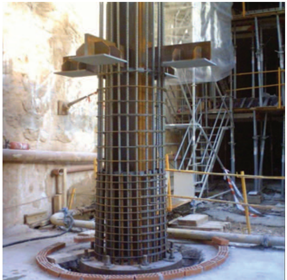
Figura 16. Detalle del pilar mixto en el arranque. Figure 16. Detail of the composite column base.
