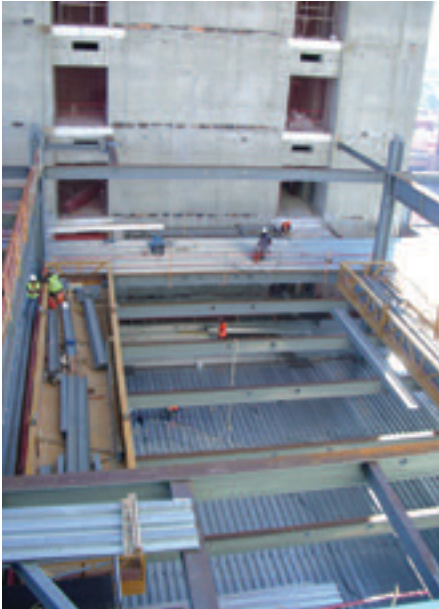
Figura 24. Batea de acopio intermedio en montaje de estructura de plantas. Figure 24. Stockpiling tray on intermediate storeys.
