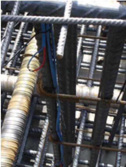
Figura 6. Colocación de Termopares en losa de cimentación y Gráfico de evolución de temperaturas en los termopares. Figure 6. Installation of the thermocouples in the basemat and chart with the evolution of the temperatures in the thermocouples
