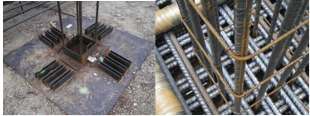
Figura 2. Disposición de armadura de torretas de cortante y plantilla de armadura. Detalle de paso de armadura longitudinal inferior entre las barras verticales de las torretas de cortante, en zona de solapo.
