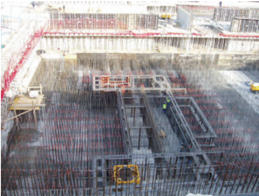
Figura 11. Plantilla para armaduras de espera de núcleo. Figure 11. Template for continuing steel in the core.
