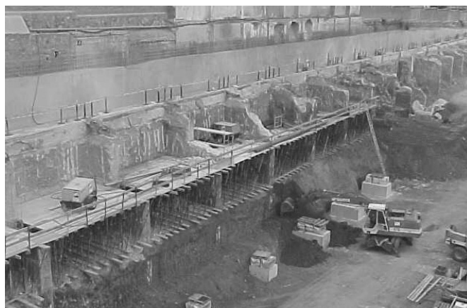
Figura 7. Muro pantalla con contrafuertes con la excavación completada. Ejecución de las losas de los forjados.
