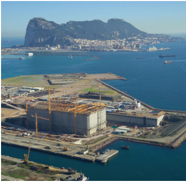
Foto de portada: Cajón Adriatic LNG terminal durante su construcción en Algeciras.
