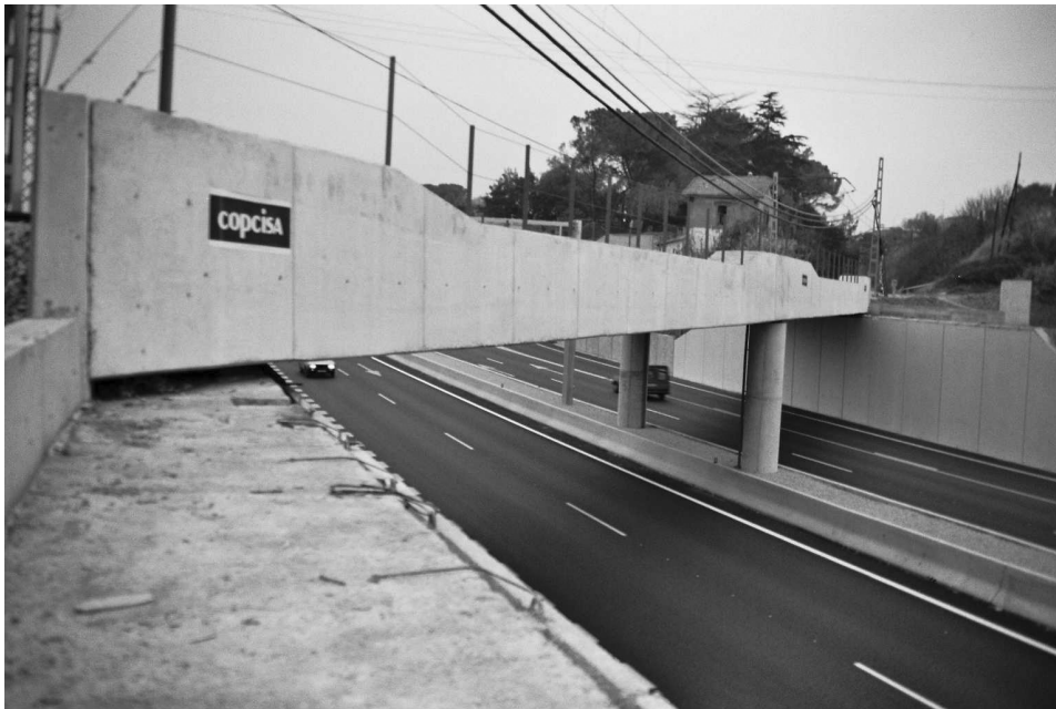
Figura 12. Vista lateral del tablero con la barandilla.
