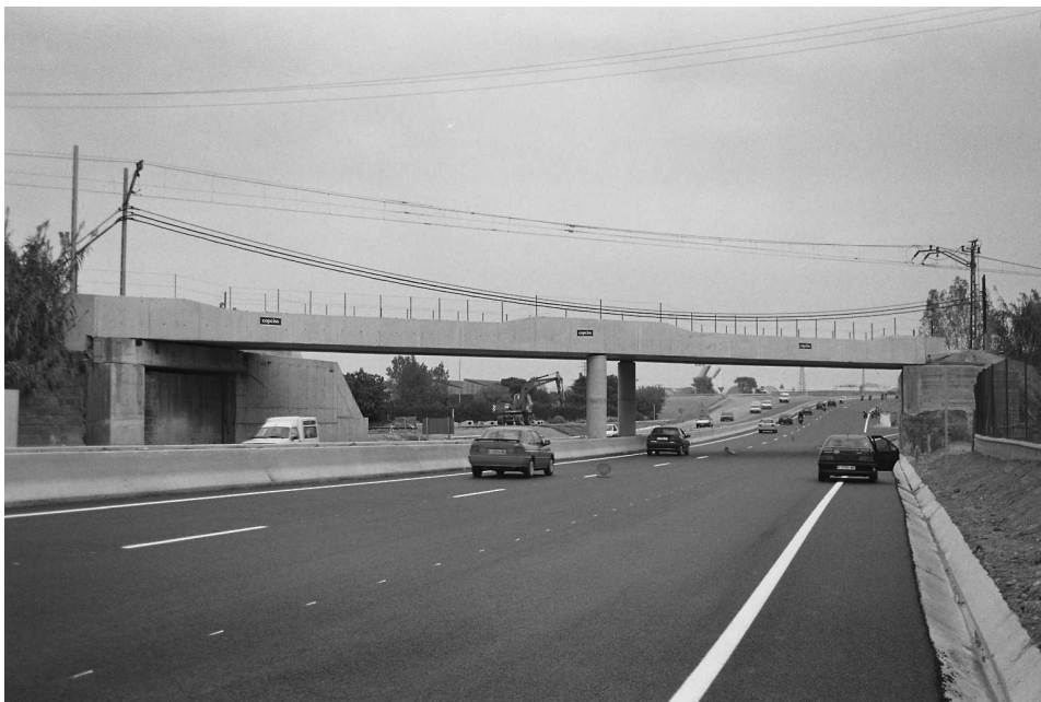
Figura 13. Vista general de la estructura.
