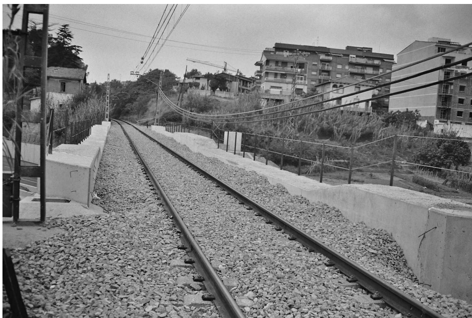
Figura 11. Vista de la superestructura
