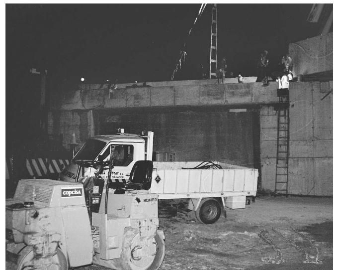
Figura 9. Montaje de la viga cargadero del estribo1.
