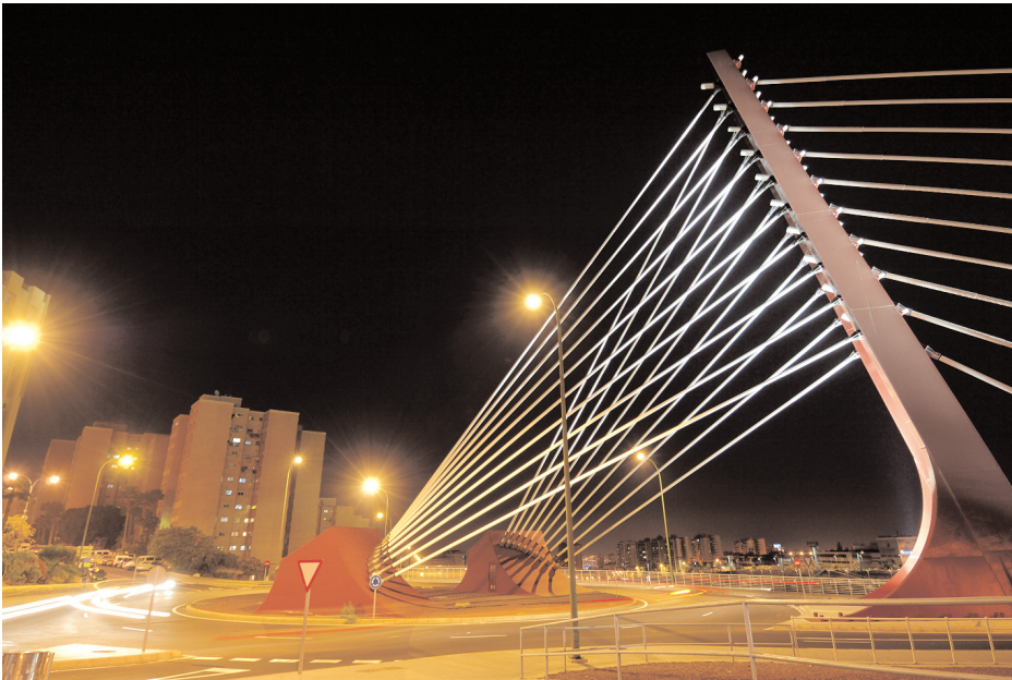
Figura 5. Vista del mástil en la glorieta 1. Toma realizada con gran angular. Figure 5. View of the pylon at rondabout 1. Wide angle picture.
