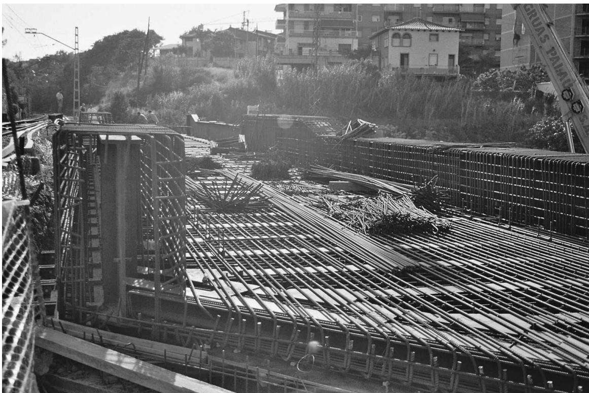
Figura 6. Armadura del tablero.
