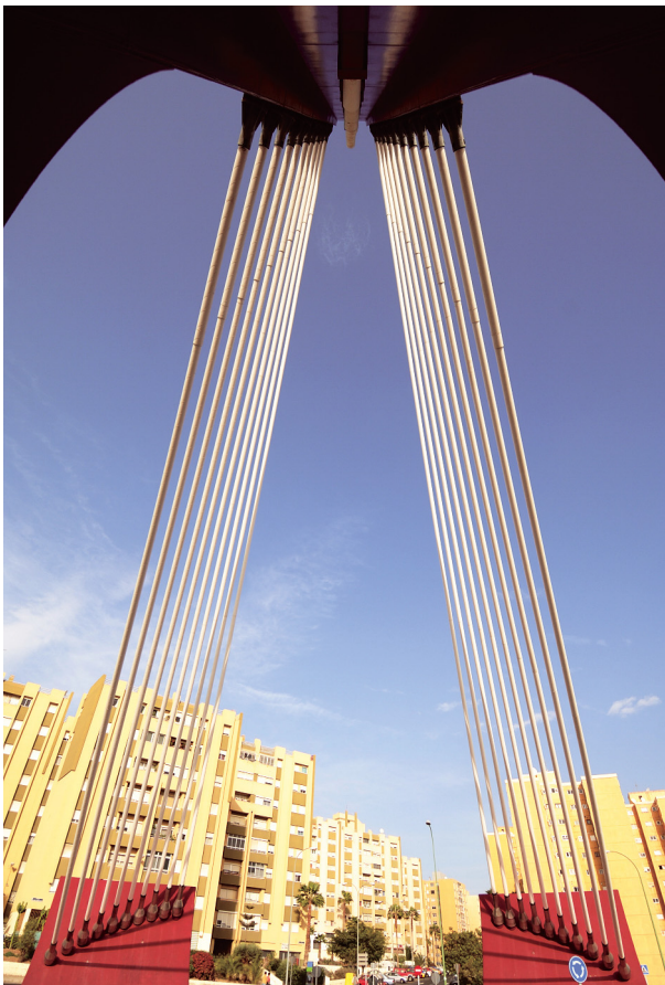
Figura 22. Vista trasera del mástil. Figure 22. Rear view of the pylon.
