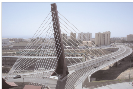
Foto de portada: Viaducto de Escaleritas
