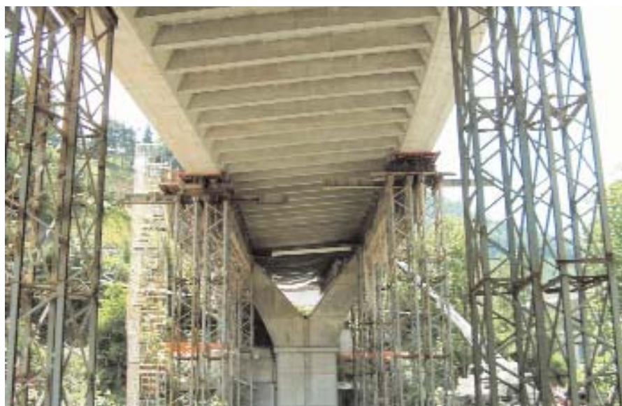
Figura 21. Tablero en fase de construcción. Vista inferior. Figure 21. Deck in the construction phase. Bottom view.
