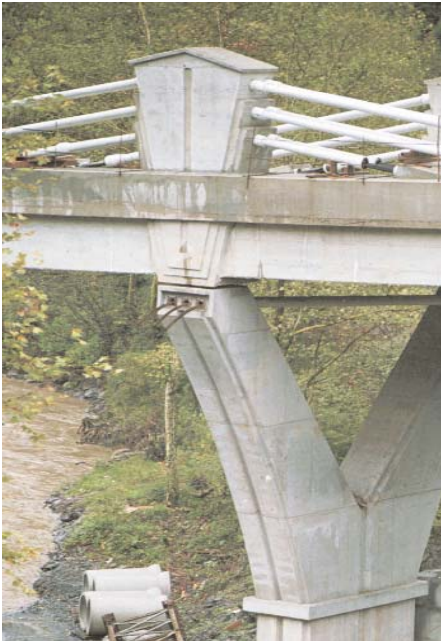
Figura 20. Detalle de la zona superior de una pila en proceso de construcción. Pueden apreciarse los extremos salientes de los tendones, que discurren por el interior de los tubos metálicos Figure 20. Detail of the top area of a pier in the construction process. The emerging ends of the cables running inside the metal tubes can be seen.
