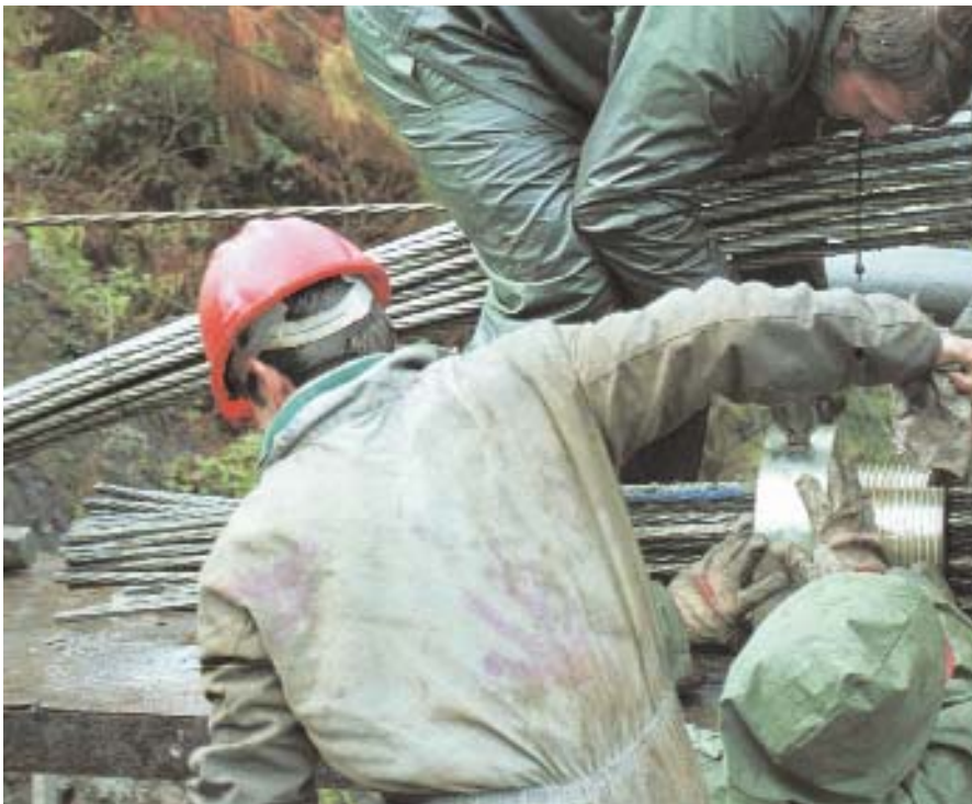
Figura 17. Anclajes de pretensado provistos de rosca. Montaje de una cabeza de anclaje, tras el enfilado de cordones.
