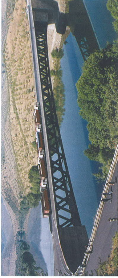
Puente sobre el Agueda (Salamanca)
