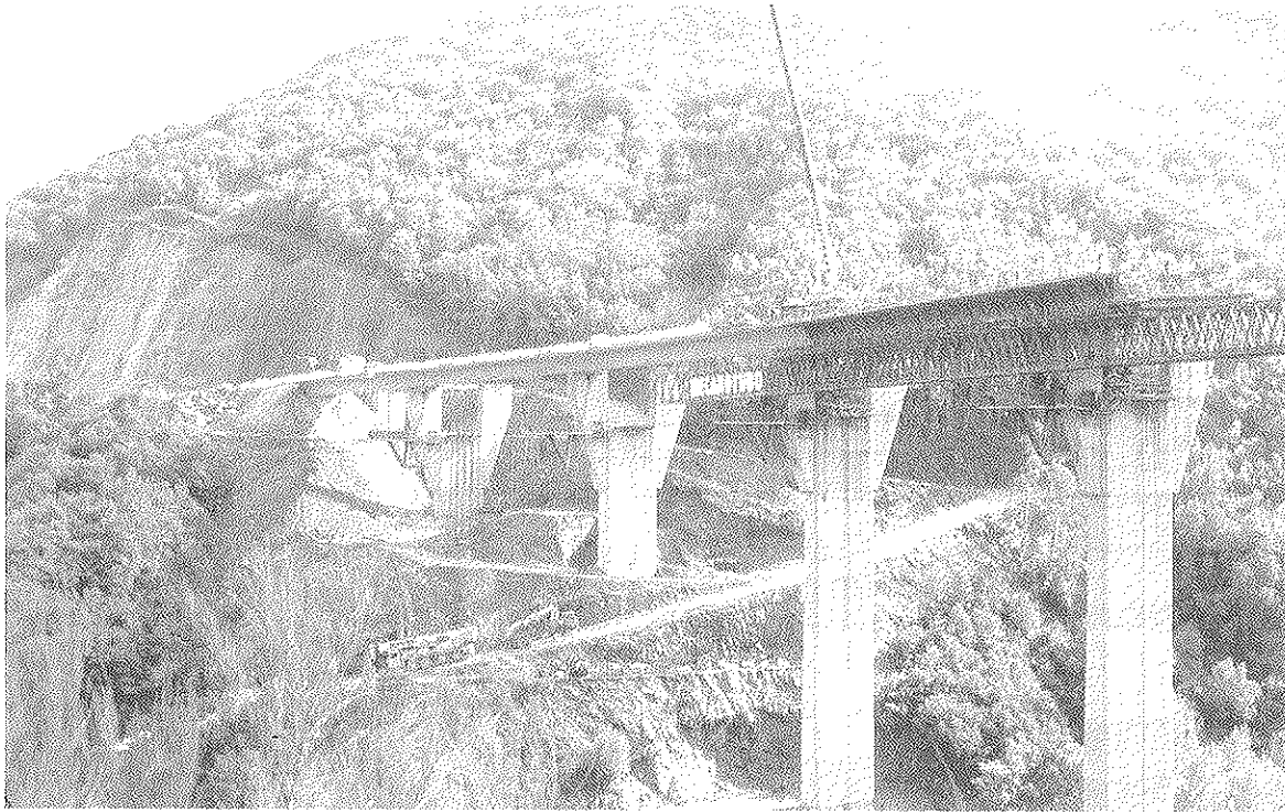
Fotografía 4.1.3-1 Vista del estribo de arranque.
