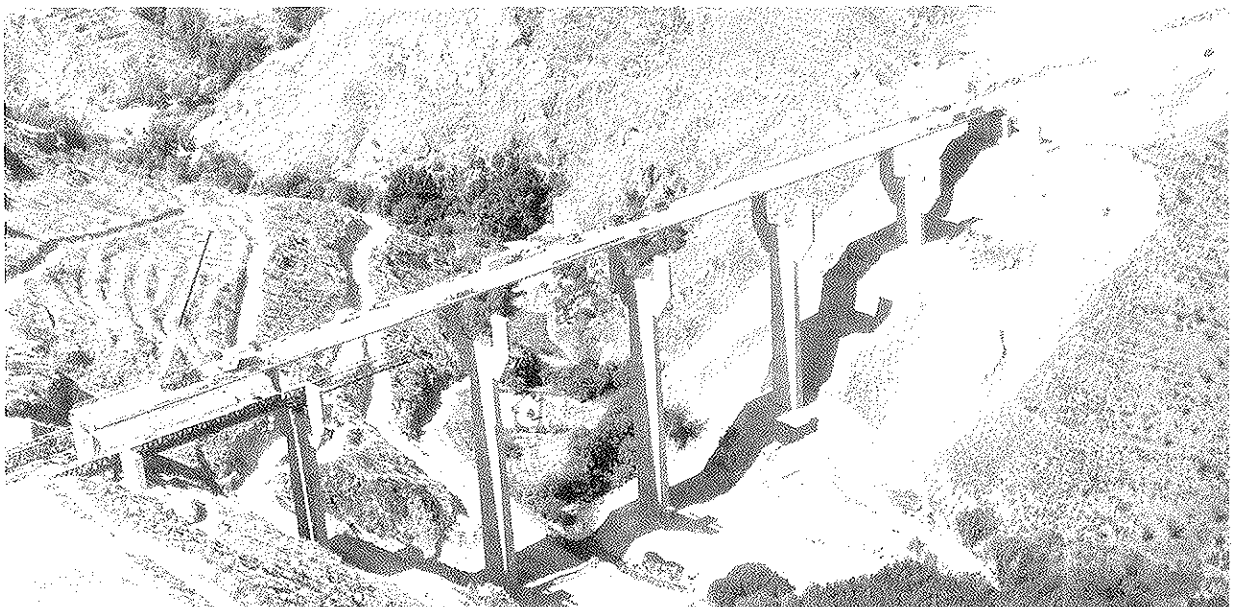
Fotografía 4.2.3-4 Vista aérea del inicio del segundo tablero.
