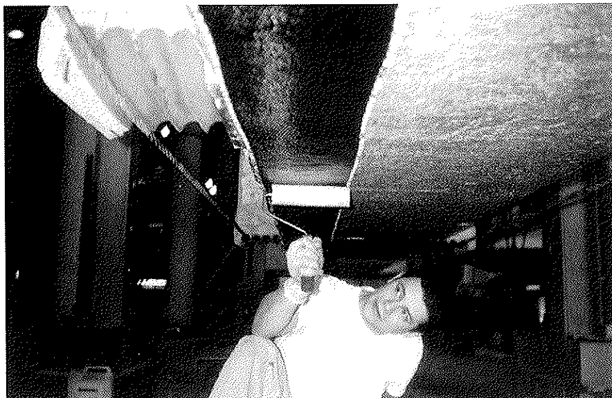
Figura 8. Aplicación de la resina epóxica sobre el tejido TFC.
