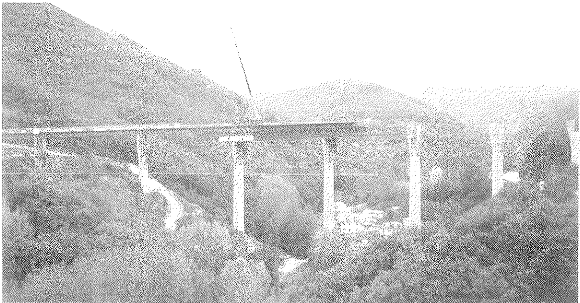
Fotografía 4.1.3-2 Vista general del viaducto en ejecución.
