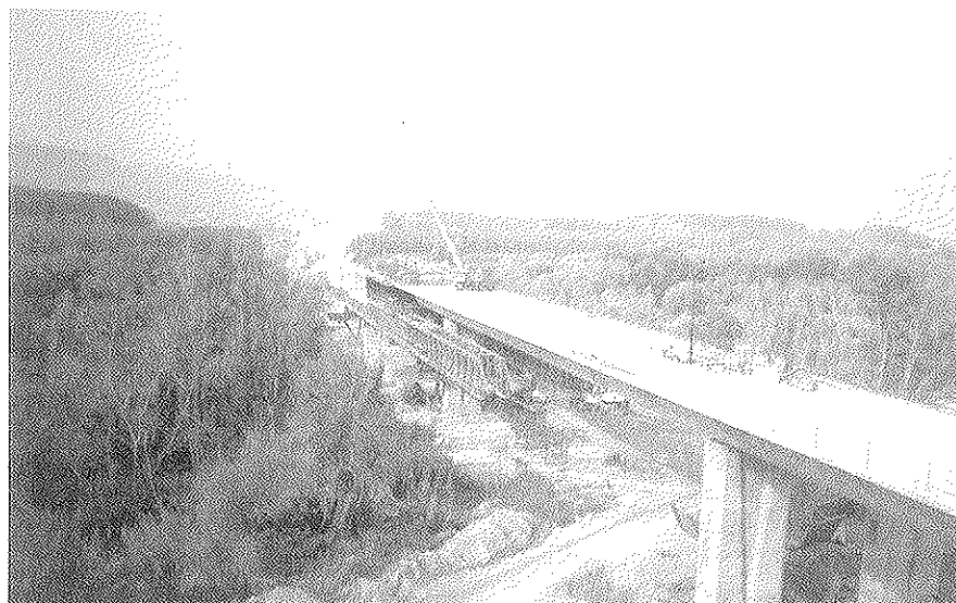
Fotografía 4.3.3-3 Vista del primer vano de 60 m ejecutado.
