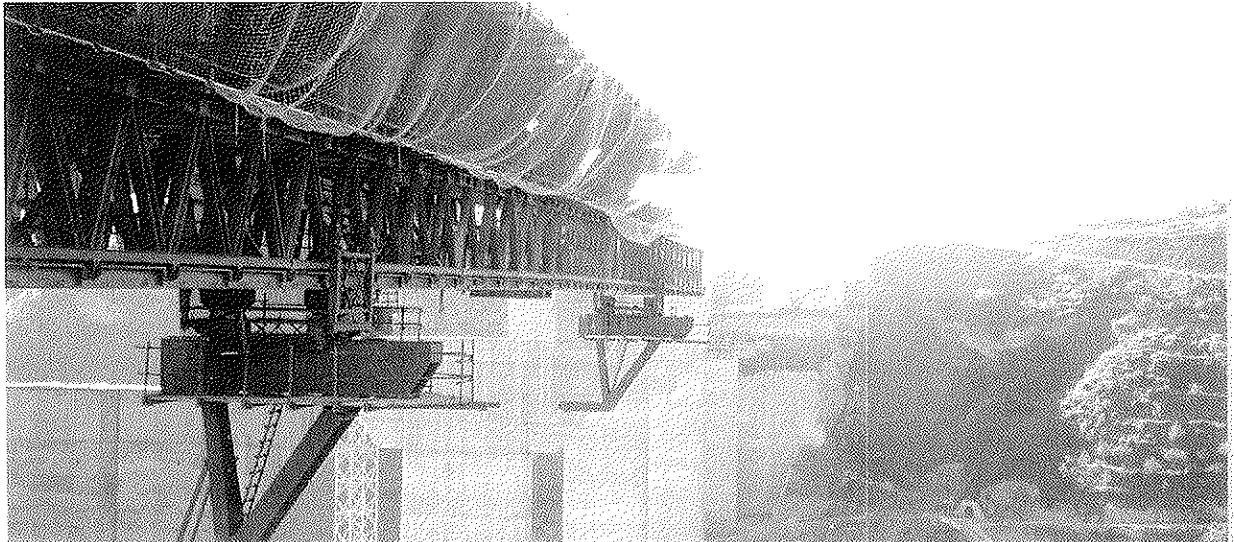
Fotografía 4.2.3-3 Vista del avance de ménsulas.
