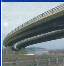
Puente sobre la N-IV y la M-30 de Madrid
