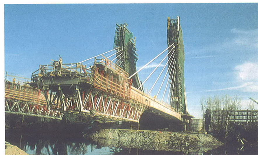
Foto 7. Carros de avance vistos desde la margen derecha.
