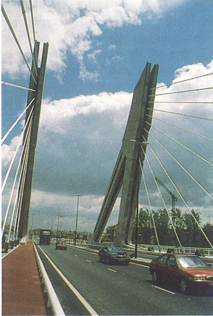
Figura 11. Los pórticos de hormigón vistos desde el vano principal. En la cabeza del mástil el rehundido central permite integrar al máximo los tirantes que allí se anclan. Figure 11. The elevated concrete frames seen from the main span. In the head of the inclined pylons, the central groove helps to visually integrate the stays that are anchored there.
