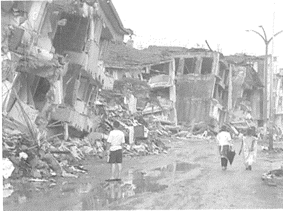
Foto 7. Edificios de varios pisos perdieron las primeras plantas.
