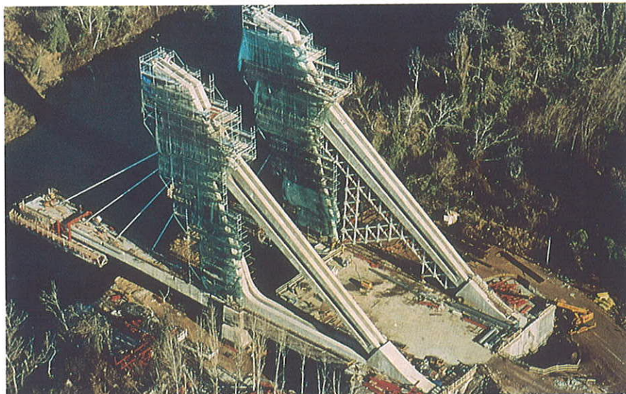
Foto 5. Construcción de nervios de borde por avance en voladizo sobre carros móviles, fabricando dovelas de 9 metros de longitud.
