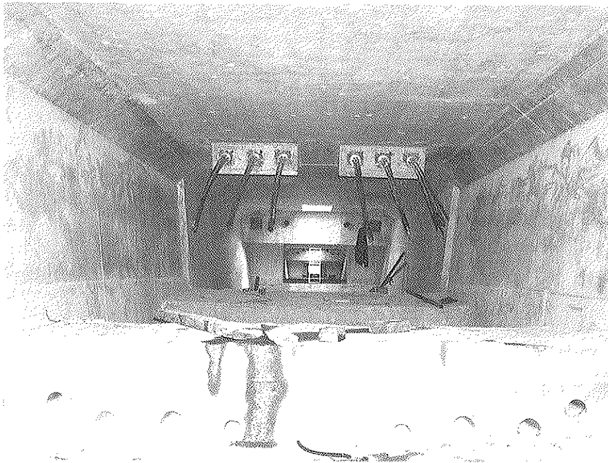
Figura 4. Interior del cajón con desviadores.
