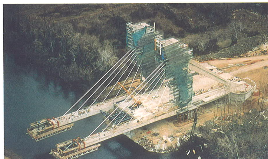
Foto 6. Avance en voladizo con carros. Se aprecian los tubos dispuestos en las nuevas dovelas para la salida de los tirantes.
