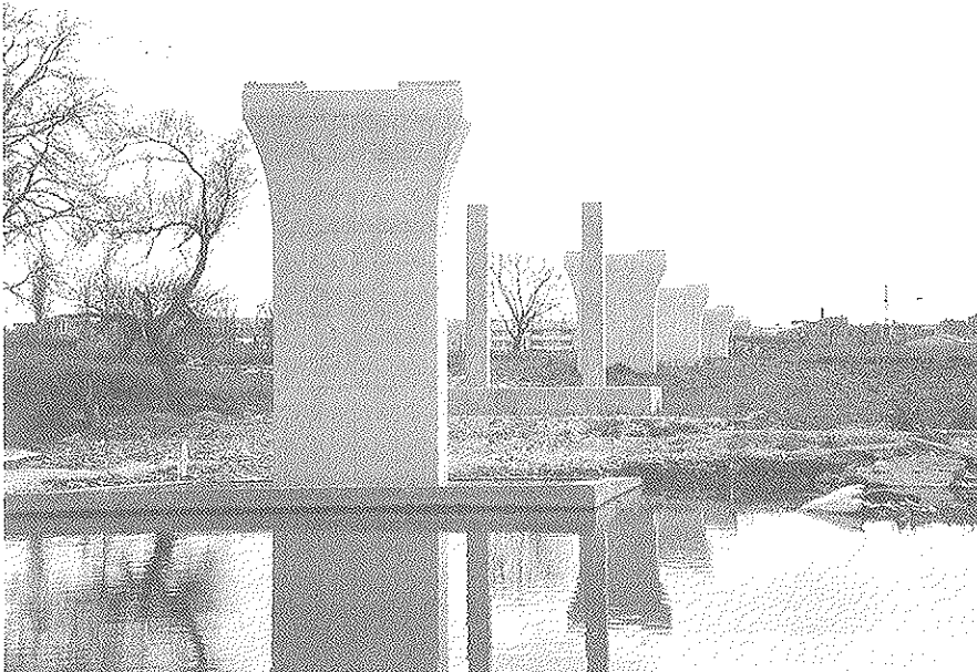
Figura 8. Vista general de pilas, con el apeo de montaje en el vano adyacente al río.
