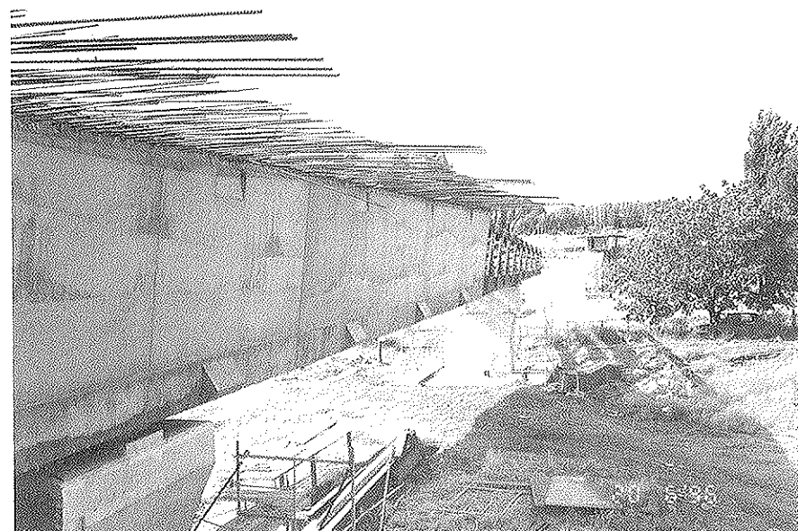
Figura 18. Cajón en fase intermedia de empuje.
