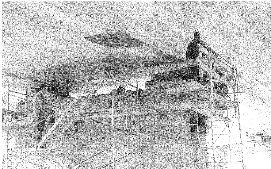
Figura 14. Coronación de la pila.
