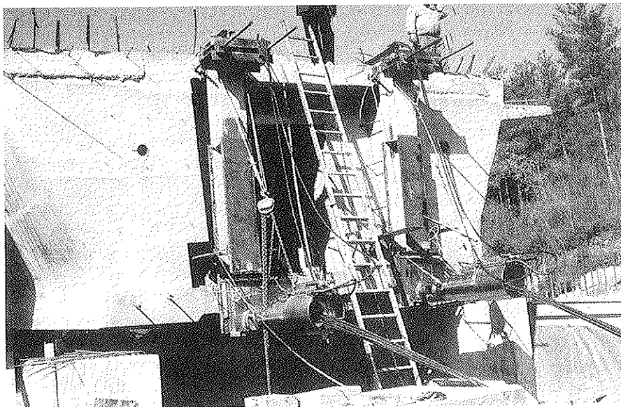
Figura 6. Mecanismo de retenida y empuje de tablero en la última fase, mediante tendones de pretensado.
