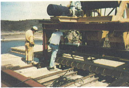
Figura 38. Colocación de forjados. Figure 38. Positioning deck slabs.
