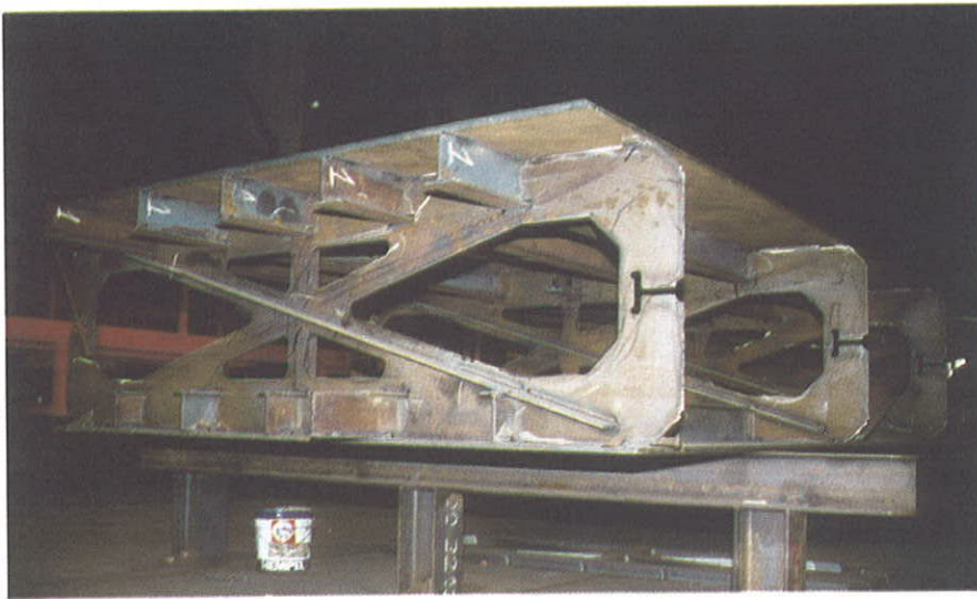
Figura 22. Fabricación de pilas. Figure 22. Pier production.
