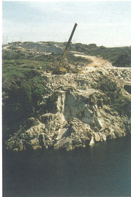
Figura 24. Excavación de los estribos. Figure 24. Abutment excavation.
