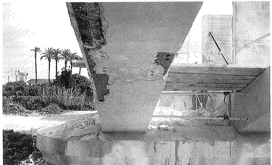
Figura 12. Estado de las pletinas inferiores.
