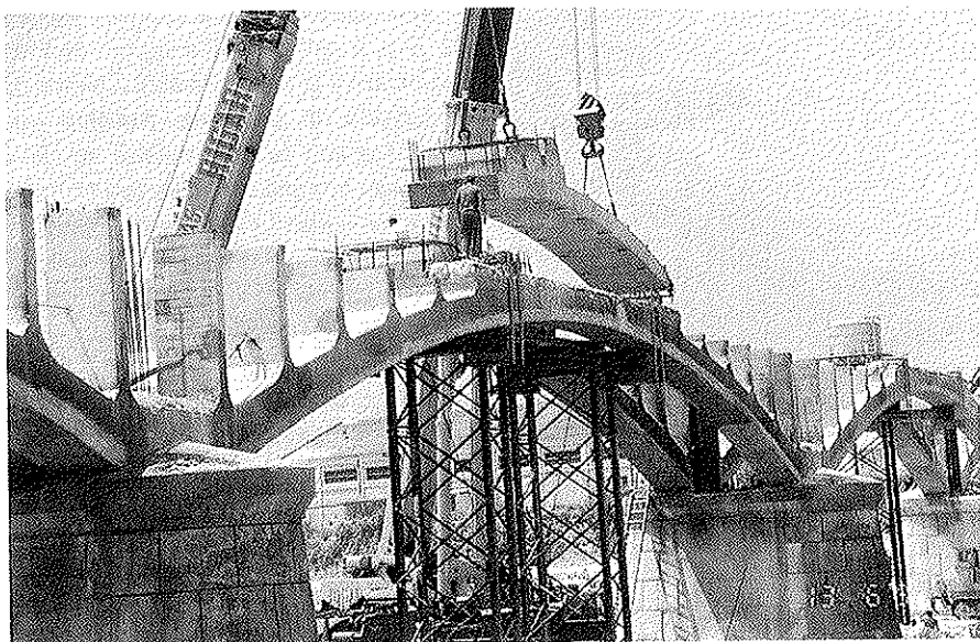
Figura 24. Montaje de arcos.
