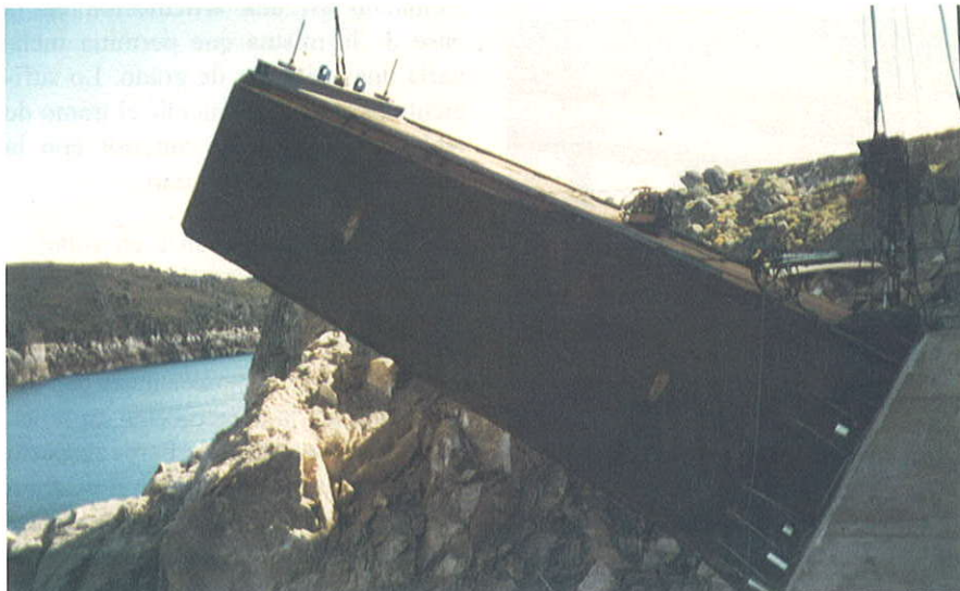
Figura 31. Primer tramo de arco. Figure 31. First arch segment.
