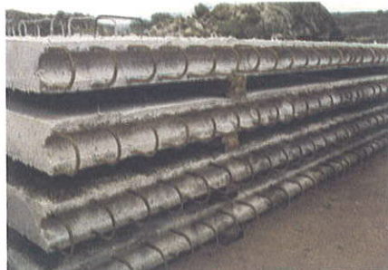
Figura 37. Forjados acopiados en obra. Figure 37. Deck slabs stockpiled on site.
