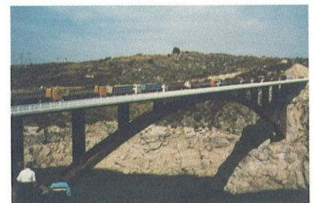
Figura 40 Prueba de carga. Figure 40 Load test.
