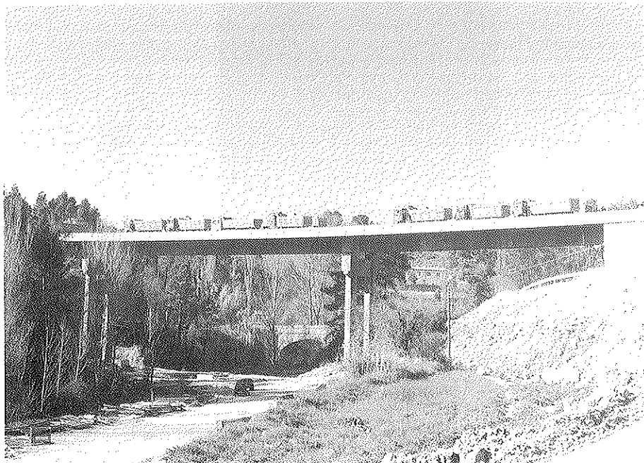
Fig. 27. Prueba de carga de la sección de apoyo en pilas. ¡El pretensado exterior funciona!
