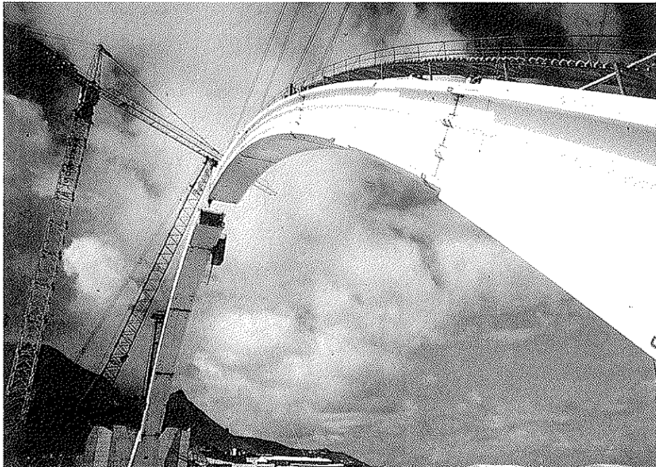
Figura 8. Montaje arco metálico. Fase anterior al cierre.
