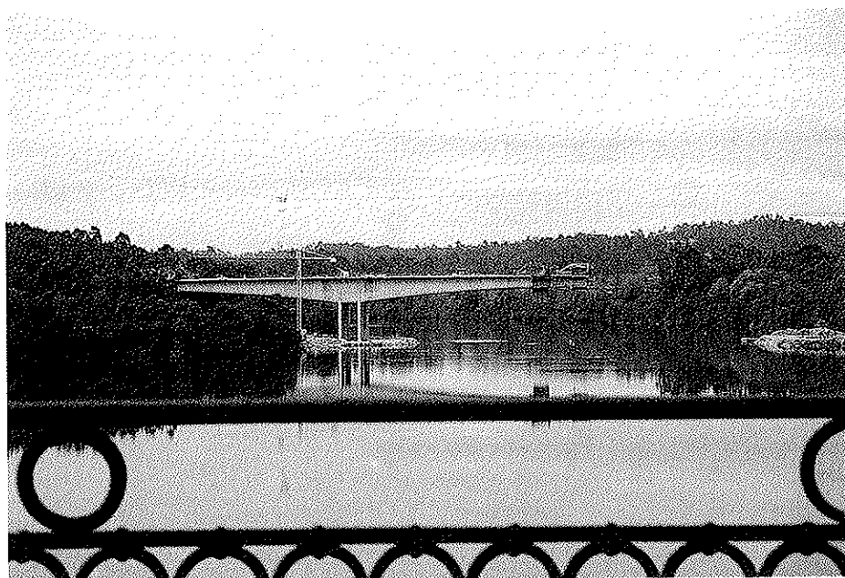
Fig. 1. Vista del avance en voladizo desde el puente antiguo.
