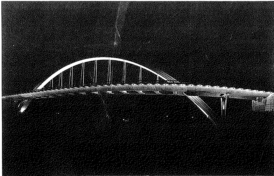
Figura 24. Vista general nocturna de la estructura.
