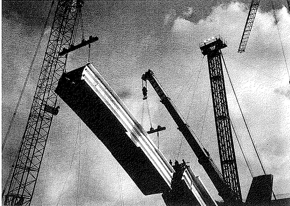
Figura 7. Montaje arco metálico. Izado de un tramo.
