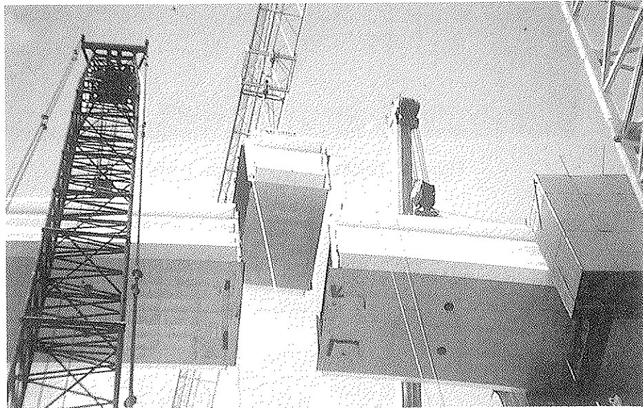
Figura 10. Cierre arco metálico.
