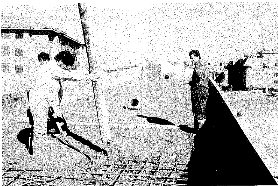
Fig. 11. Hormigonado del tablero.
