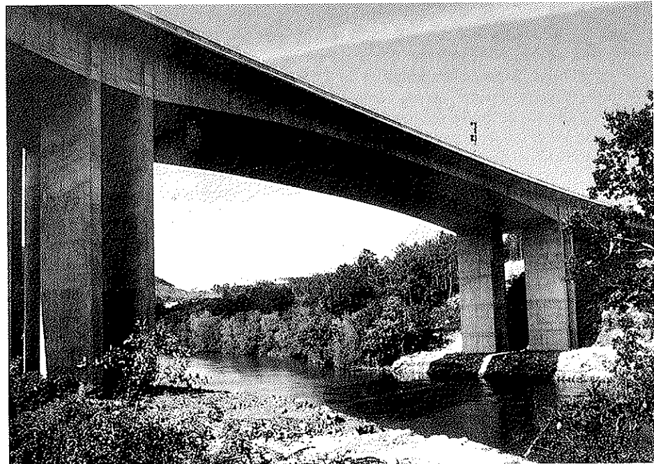
Fig. 4. Vista inferior del puente terminado.
