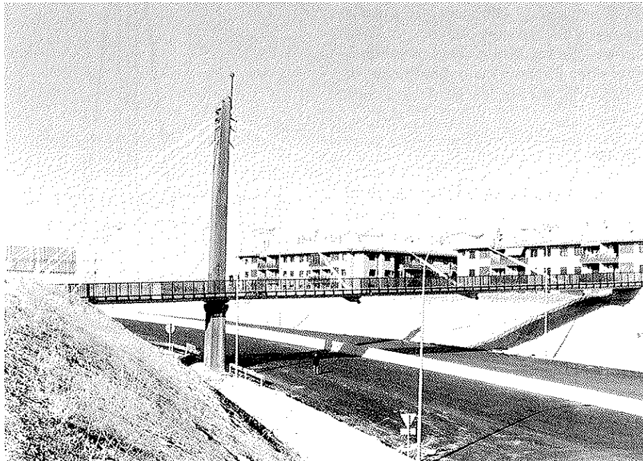
Fig. 8. Aspecto estético de la Pasarela del Mazo.
