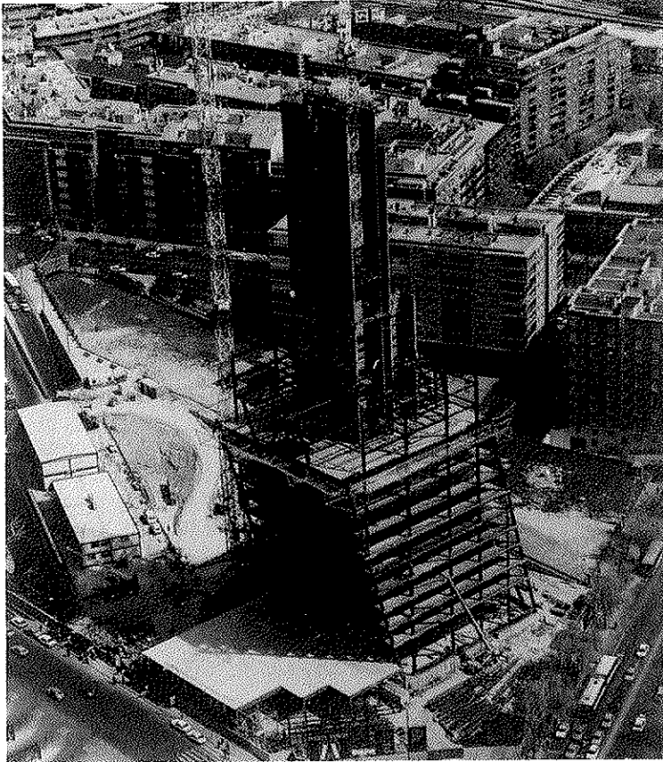
Fig. 8. Montaje estructura metálica.
