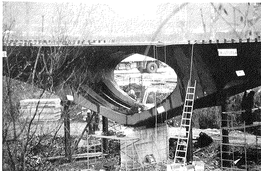
Foto 4. Montaje de la zona alveolada (Fase 1).
