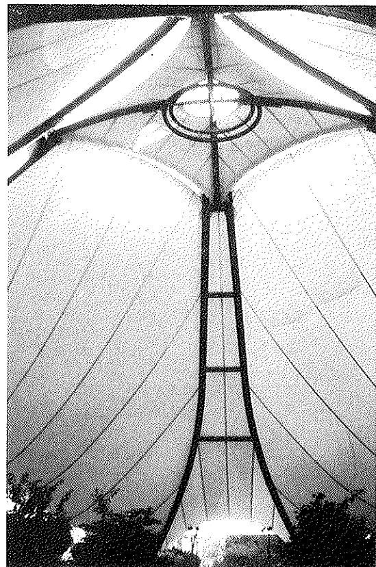
Fig. 73. Vista interior de la carpa bioclimática.
