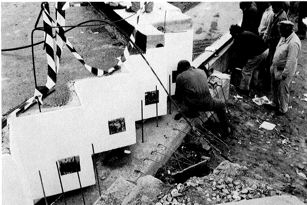
Fig. 15. Detalle del extremo del tablero tras el ripado. Puede observarse, en el extremo de cada viga, el correspondiente tope de neopreno para la coacción horizontal del estribo.
