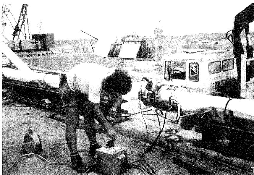
Foto 21. Soldadura de la vaina de los cables.
