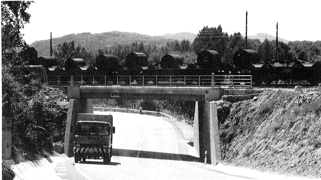
Fig. 20. Aspecto de la obra terminada, en estado de servicio.
