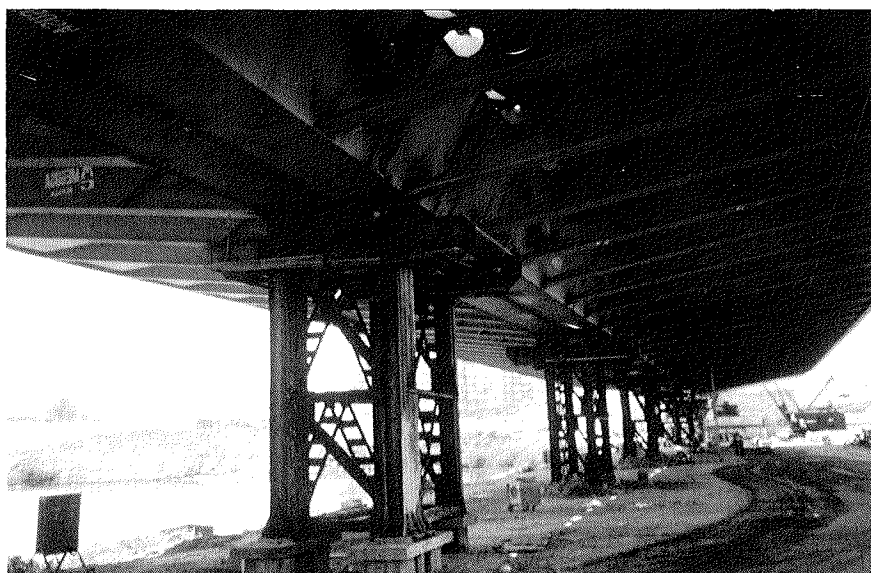
Foto 14. Apoyo del tablero en el estribo.
