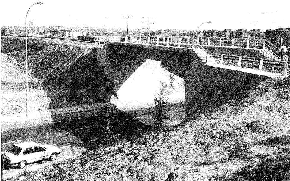
Fig. 7. Aspecto de la obra terminada, vista a la altura de la plataforma del Ferrocarril.
