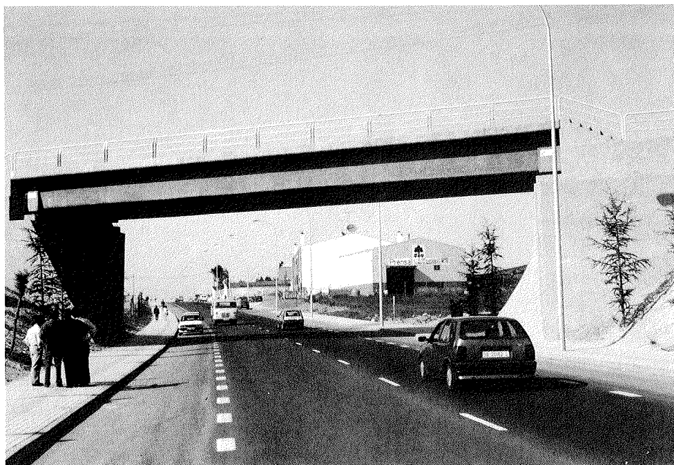
Fig. 8. Vista del puente desde el Paseo Federico Anaya. Puede observarse la peculiar forma del paramento de los estribos que compatibiliza la naturaleza de cruce oblicuo, con los apoyos del tablero dispuestos perpendicularmente a la vía.
