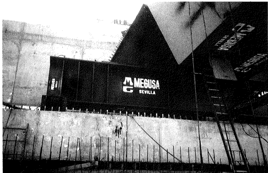
Foto 13. Montaje del tablero.
