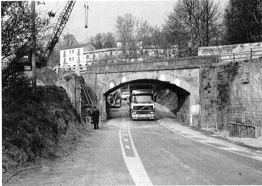
Fig. 9. Antiguo puente para el Paso Superior del F.C. sobre la Carretera N-630.
