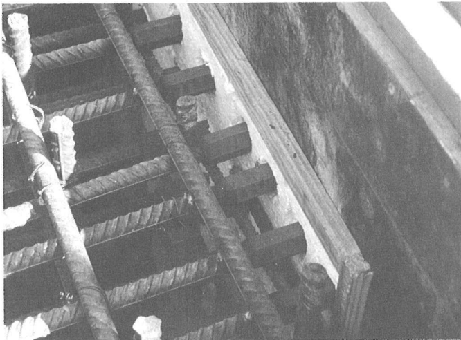
Foto 4. Puente del Centenario, en Sevilla. Encofrado.
