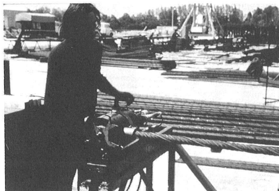
Foto 7. Manguito estampado. Colocación a pie de obra.
