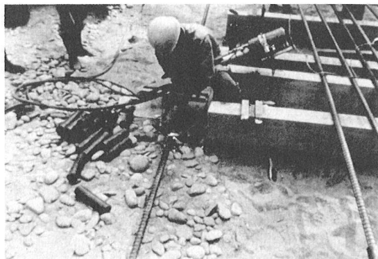
Foto 6. Manguitos ALCOR. Colocación a pie de obra.
