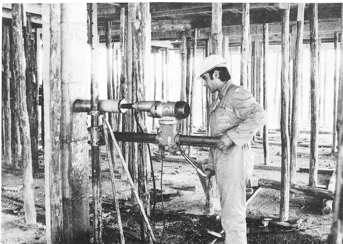
Extracción de probetas testigo de hormigón endurecido.
