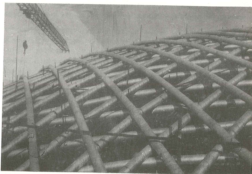
Central Nuclear de Lemóniz. Detalle vainas en cúpula
