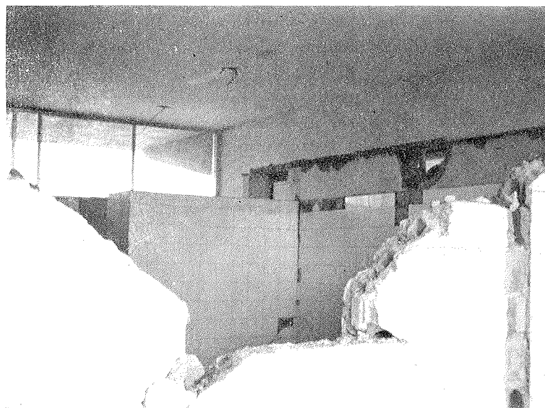
Foto 4. — Elementos no estructurales unidos a los marcos del edificio, que no fueron capaces de tolerar las deformaciones de éstos. Chimbote (Perú), sismo 1970.
