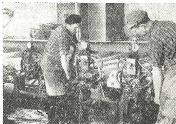
Fig. 4. Tesado de barras en traviesas postesadas.
