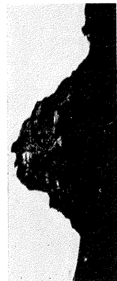
Fig. 7.—Picado superficial, indicio de que se ha iniciado la corrosión
