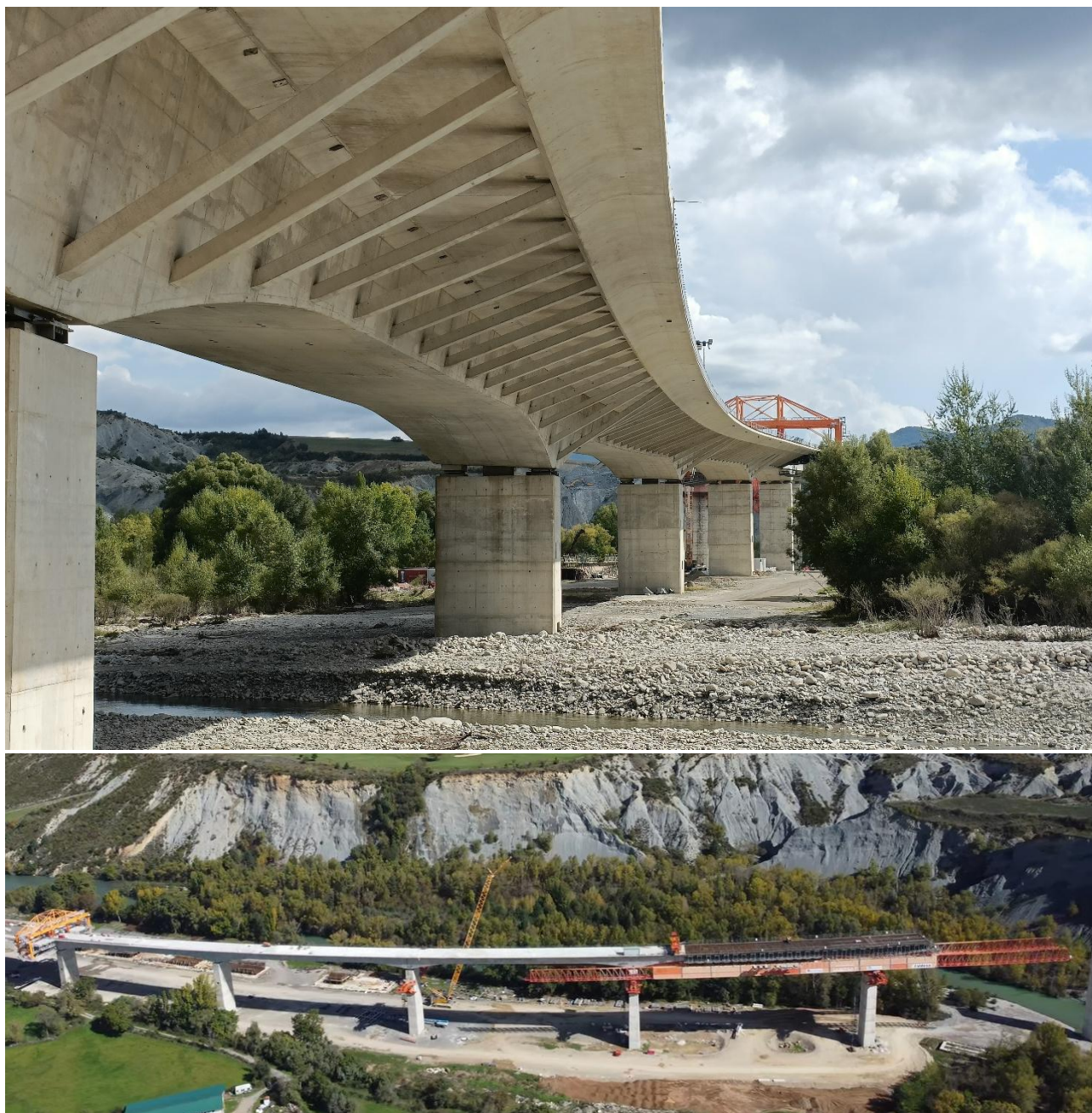
Figura 4. Superior: Vista inferior de la variación de canto (zona estribo 2). Inferior: Vista general de la ejecución del viaducto
