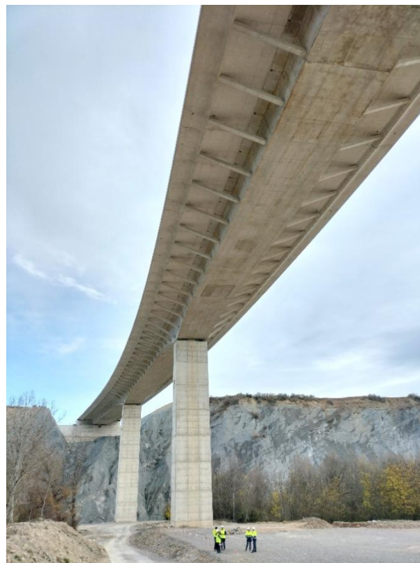
Figura 10. Vista longitudinal de los fustes de las pilas 1 y 2
