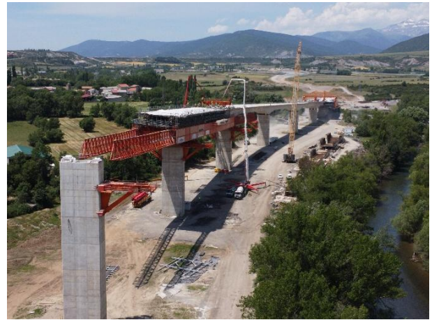
Figura 16. Hormigonado de la losa superior del cajón.
