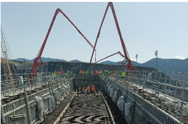
Figura 15. Vista del hormigonado de la sección parcial en U.
