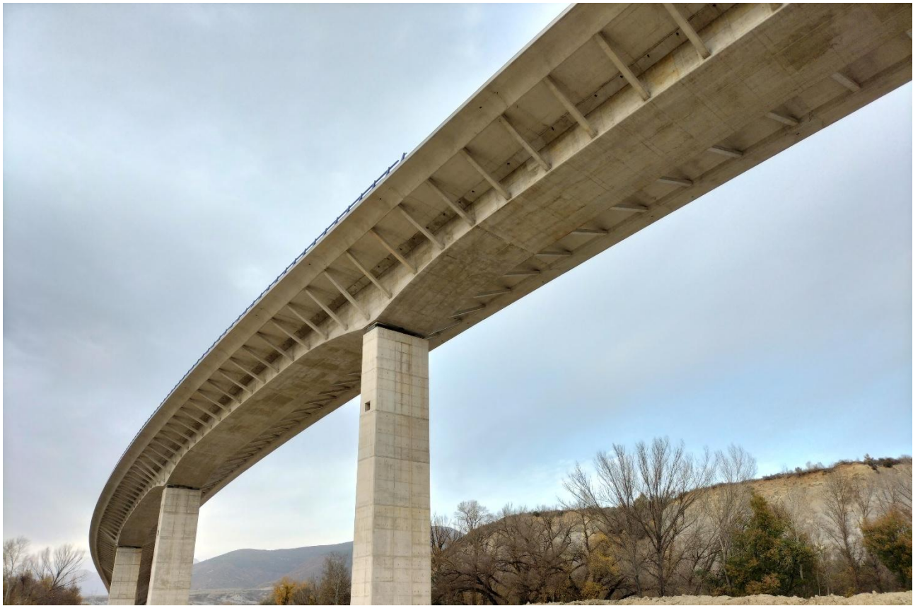
Figura 1. Visión inferior del viaducto acabado desde las proximidades del vano 2
