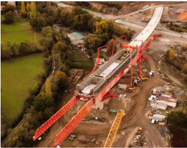
Figura 14. Imagen aérea del hormigonado de la sección parcial en U.
