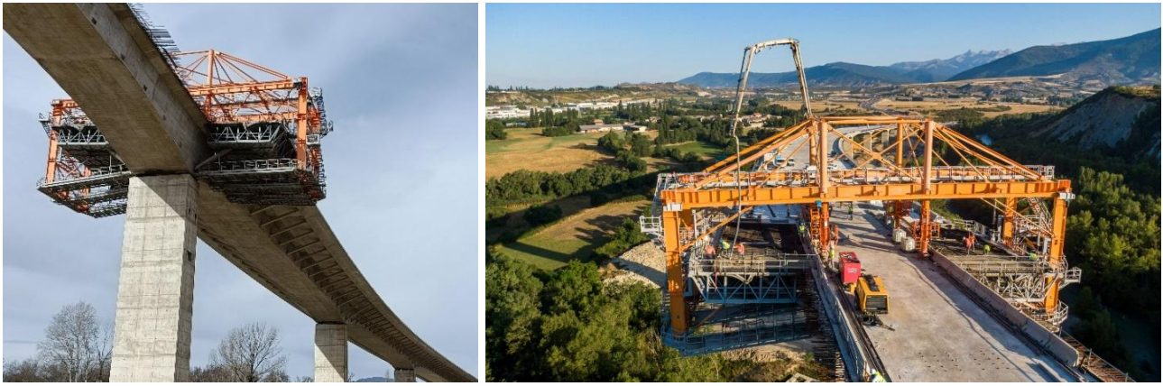
Figura 19. Izquierda: vista inferior del carro de alas. Derecha: vista superior del carro de alas
