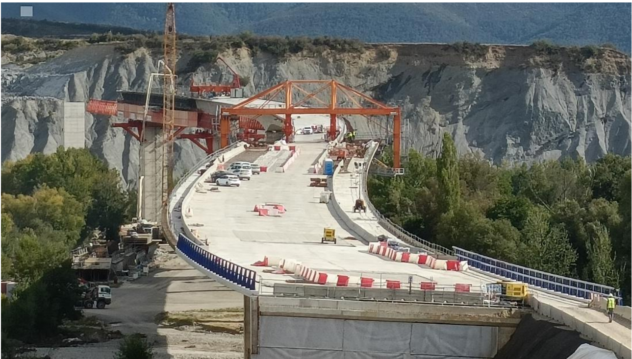
Figura 18. Vista del viaducto en ejecución desde el Estribo 2. En primer plano destaca el carro de alas. Al fondo se muestra la autocimbra.
