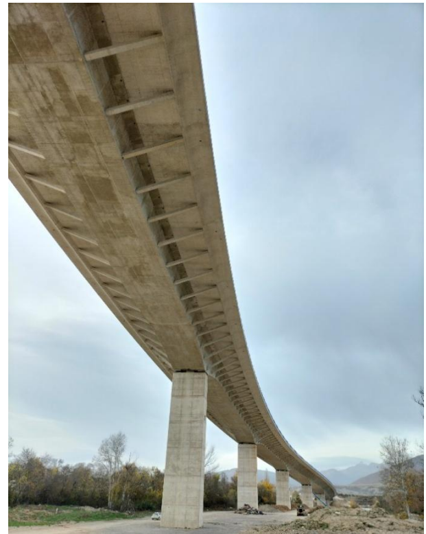
Figura 9. Vista longitudinal de los fustes de las pilas desde el vano 2 hacia PK+
