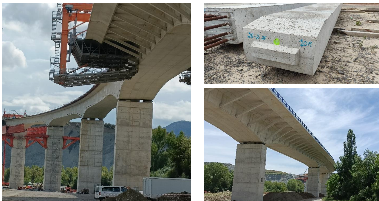
Figura 6. Izquierda e inferior derecha: Vistas inferiores del puente que muestran el alabeo del plano de los puntales prefabricados y la ejecución de las alas. Superior derecha: Puntal prefabricado acopiado en obra
