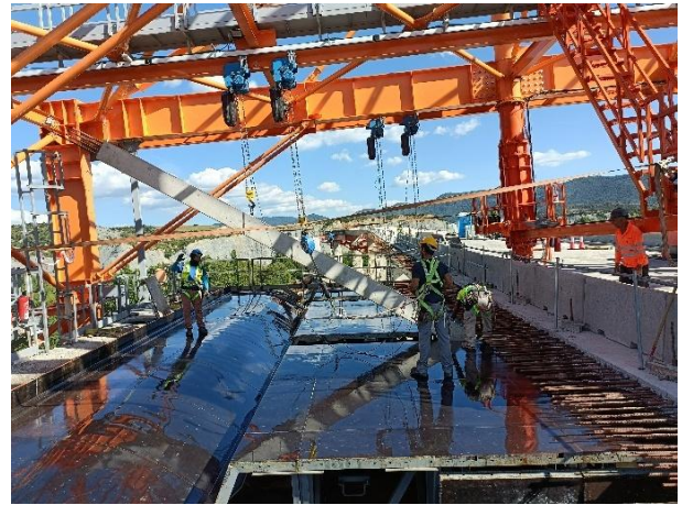
Figura 17. Colocación de puntal prefabricado mediante carro de alas.
