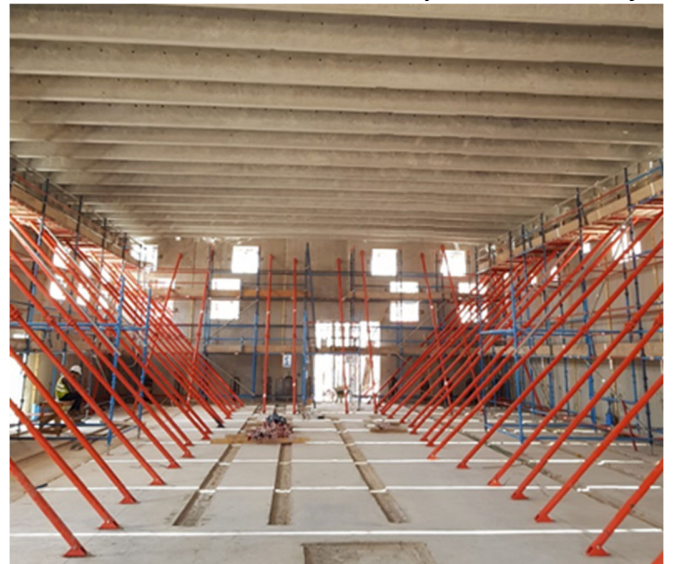
Figura 12. Subestación eléctrica totalmente prefabricada (arriba).
