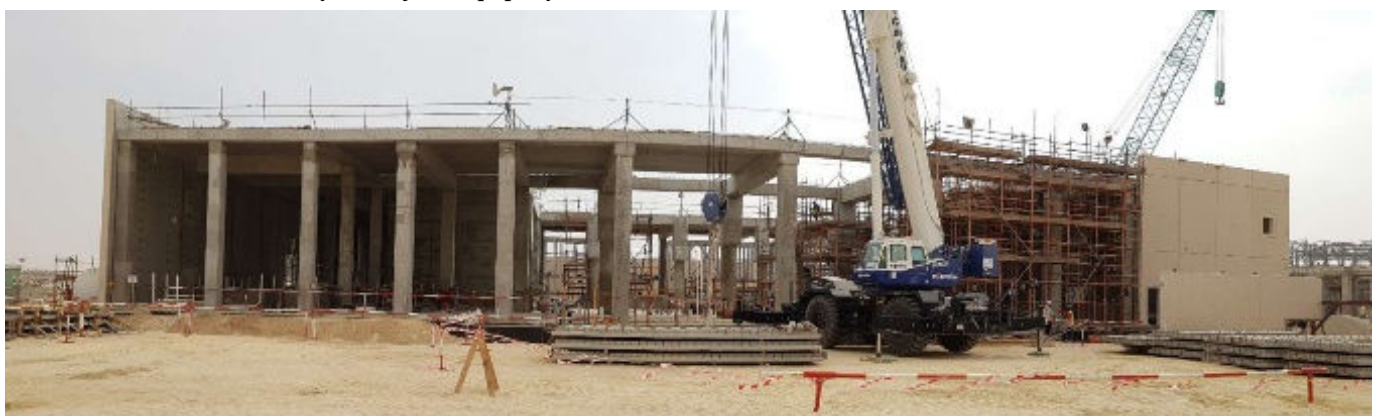
Figura 11. Edificio de control con solución híbrida (abajo).
