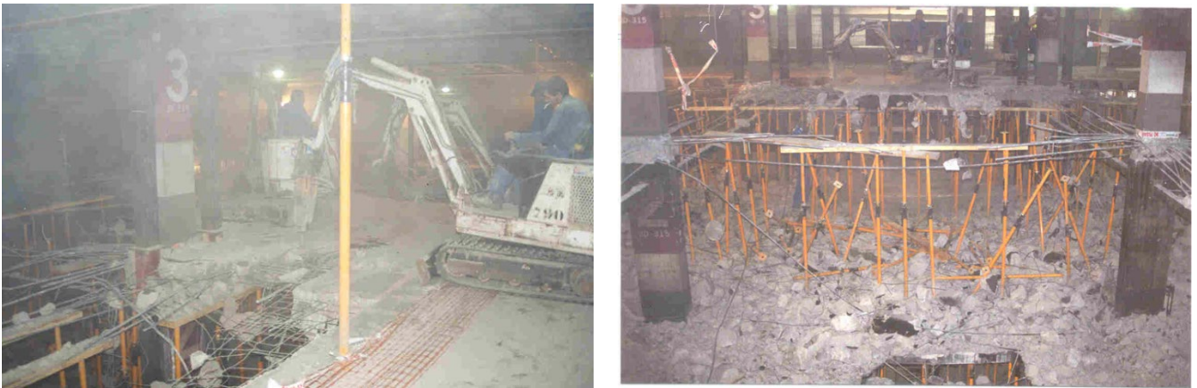
Figura 32: Aparcamiento P2. Proceso de demolición en la zona con daños irre recuperables.
