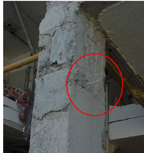
Fisuración por flexión en un pilar (fotografía superior izquierda) en un soporte al que el cerramiento estaba referido con llaves ancladas a los soportes
