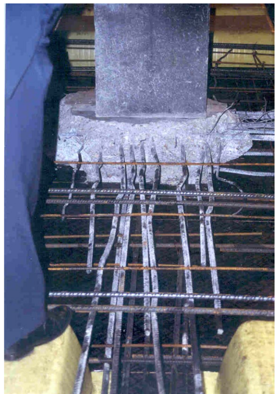
Demolición en el entorno del soporte. Se están dejando en los bordes superficies inclinadas descendentes alejándose del pilar
