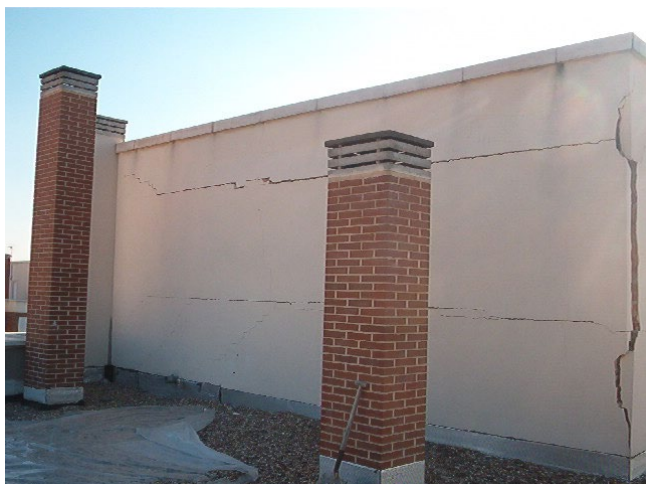
Edif. C/ Martín Gaité, Leganés, Madrid, 2004 (la onda expansiva subió por la caja de escalera provocando los daños que se muestran en el casetón de cubierta)
