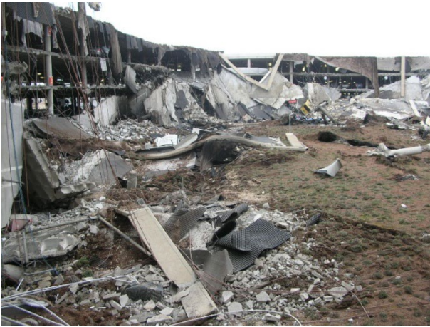
Figura 14: Colapso progresivo en un edificio de aparcamiento tras la explosión (Aparcamiento de Barajas, Madrid, 2006).
