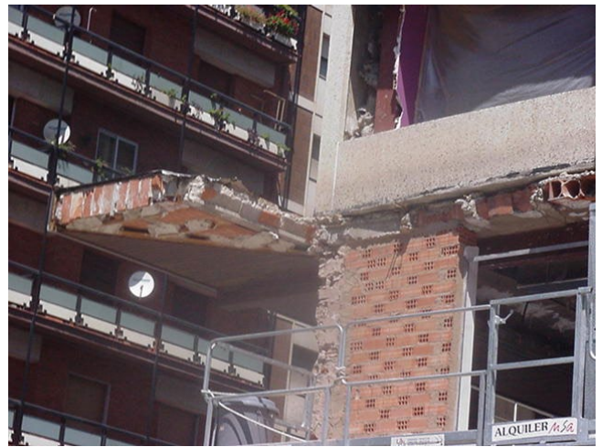
Figura 9: Fallo en los voladizos de un edificio por una explosión bajo ellos en planta baja (Edificio en la Gran Vía de Logroño, 2001).
