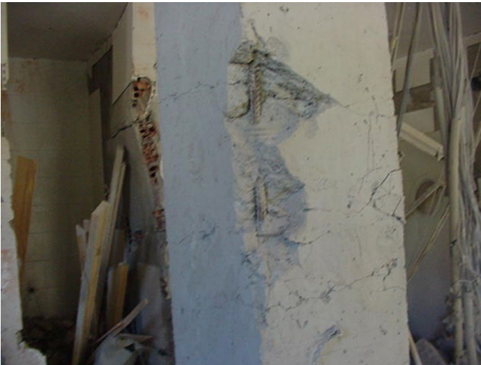
Fisuración por flexión en un pilar (fotografía superior izquierda) en un soporte al que el cerramiento estaba referido con llaves ancladas a los soportes
