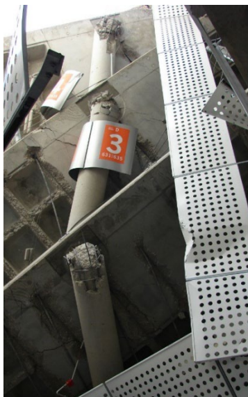
Figura 15: Pilares con daños graves o riesgo de inestabilidad tras la explosión (Aparcamiento de Barajas, Madrid, 2006).
