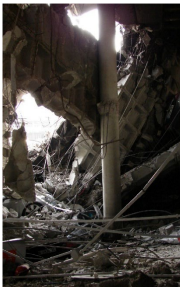
Figura 15: Pilares con daños graves o riesgo de inestabilidad tras la explosión (Aparcamiento de Barajas, Madrid, 2006).
