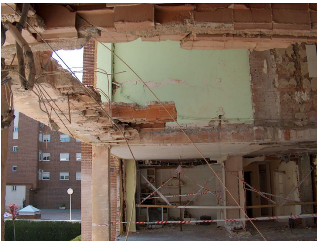
Figura 10: Colapso por inversión de esfuerzos en forjado de techo sobre el foco de la explosión (Edif. C/ Martín Gaité, Leganés (Madrid), 2004)
