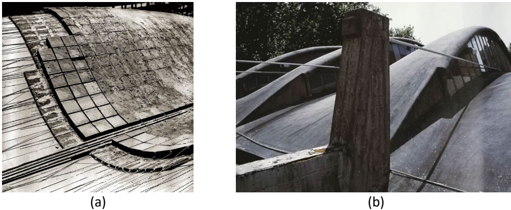
Figura 2: Refuerzo de la iglesia de Atlántida (a), cable de acero para controlar la acción de arco en las bóvedas gaussianas (b). Fuente [4].
