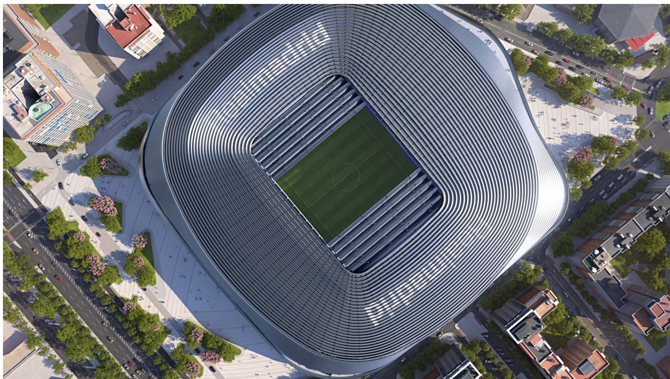
Figura 18. Vista aérea de la cubierta retráctil.
