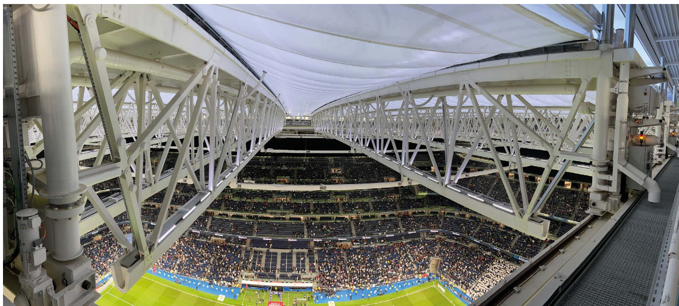
Figura 45. Vista interior de la cubierta retráctil.
