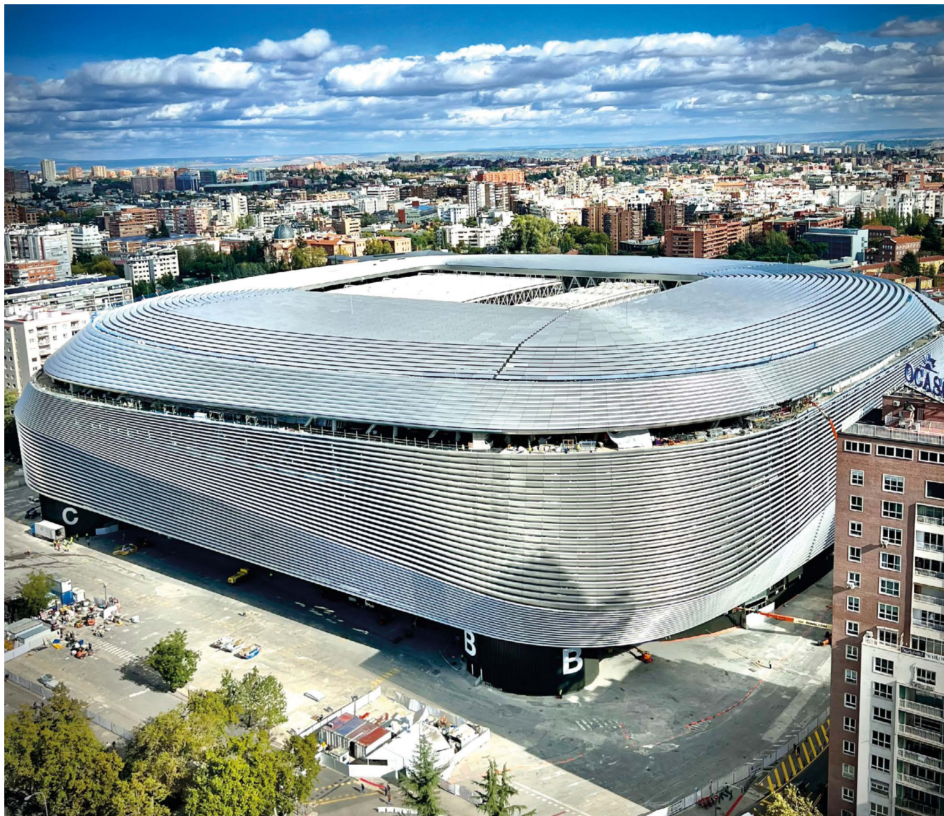
Figura 42. Vista exterior del estadio acabado.
