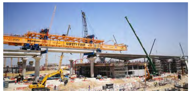
Figura 3. Proceso constructivo con viga lanzadora.
