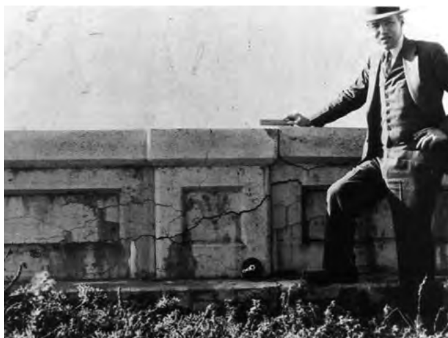
Figura 1. Thomas Stanton, de la California State Division of Highways, en 1940, uno de los primeros investigadores de las reacciones árido-álcali (cortesía FHWA).
