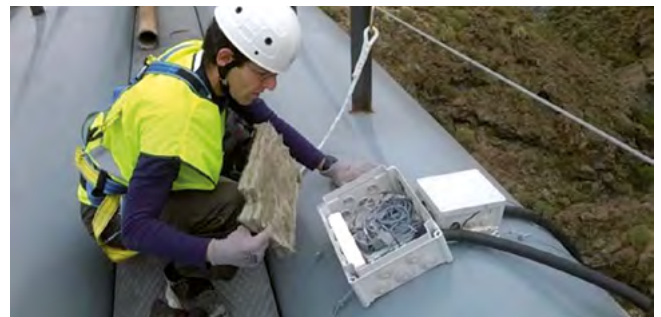
Figura 20. Colocación de equipos en arcos.
