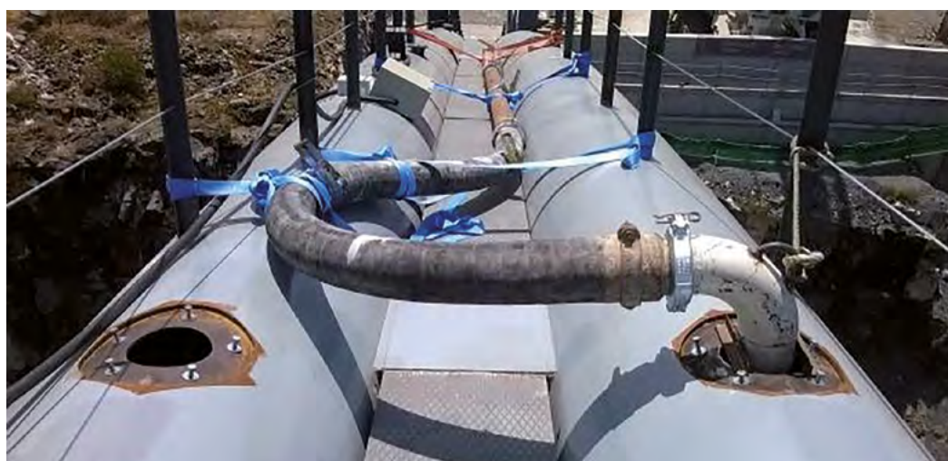
Figura 23. Hormigonado de arcos.
