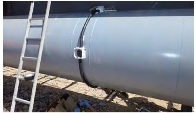
Figura 18. Colocación de la protección.
