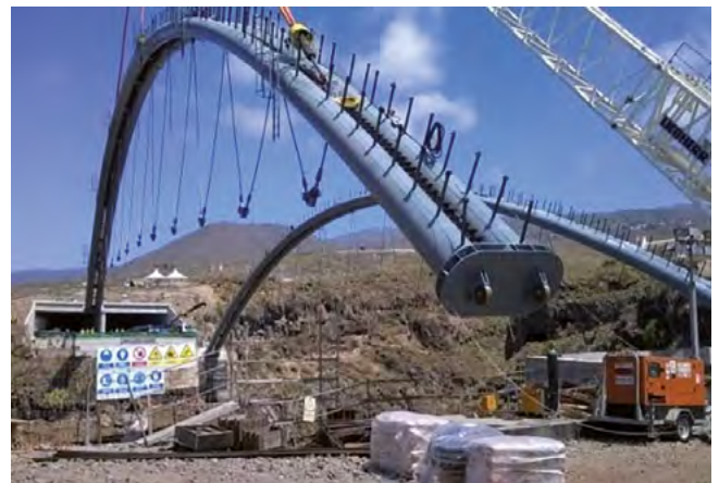
Figura 19. Colocación de Arcos en posición final.
