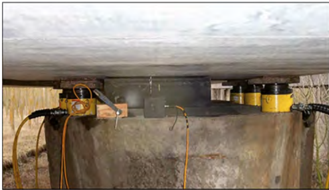
Figura 6. Gatos hidráulicos bajo el tablero.
