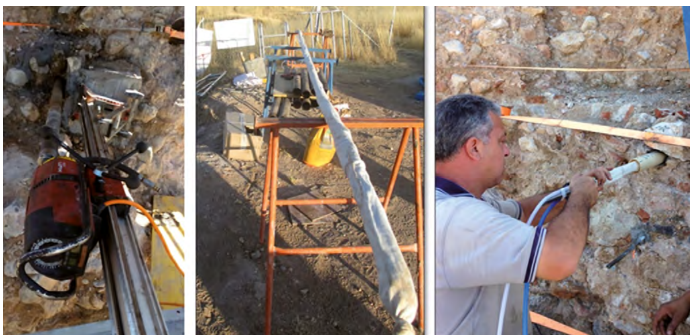
Figura 34. Perforación y montaje del anclaje.
