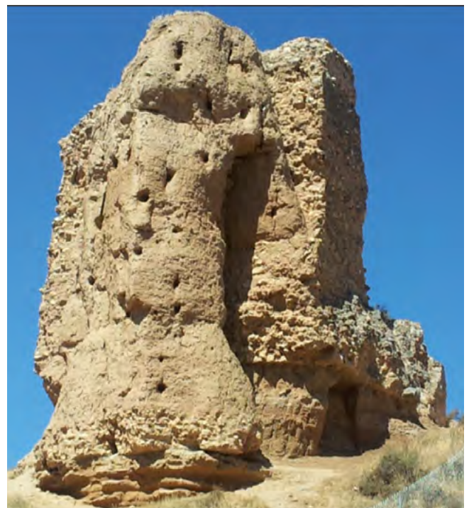
Figura 12. Estado de la torre en el año 2014.
