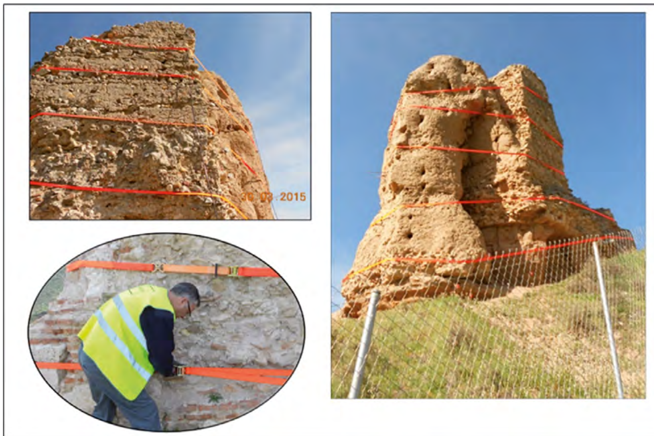
Figura 27. Montaje arriostramiento del bloque de tapial.
