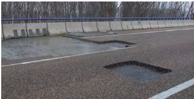
Figura 7. Reposición del hormigón deteriorado de la losa de compresión.
