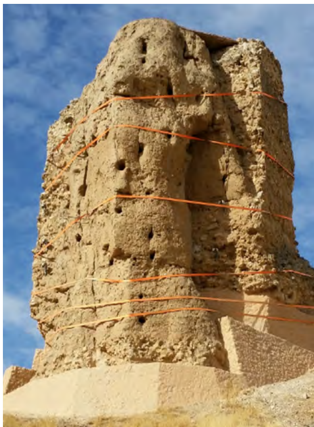
Figura 30. Aspecto final del recalce de la cimentación.
