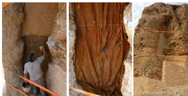
Figura 32. Puesta en obra de adobes, curado con arpilleras y acabado.
