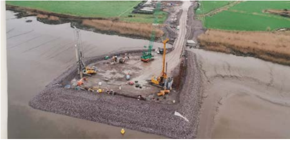
Figura 6. Península temporal para la pila central (P-4)
