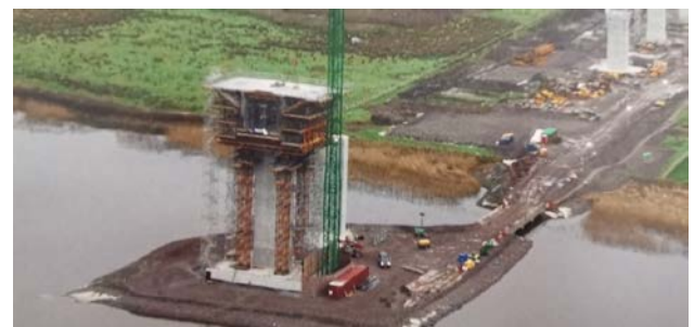
Figura 17. Dovela "0" sobre pila 4. Construída sobre cimbra
