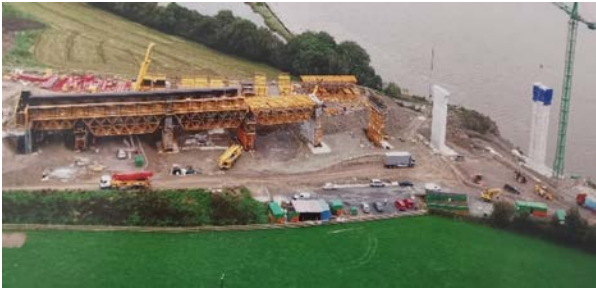
Figura 10. Tramo de cimbra sobre el vano 1 y 2
