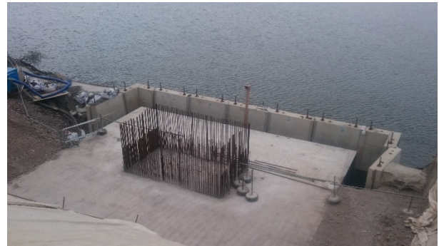
Figura 4. Cruce del río durante la construcción (P4 central -derecha- y P3 lateral -izquierda-)
