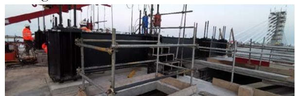
Figura 22. Vigas de bloqueo del voladizo
