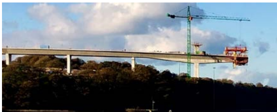
Figura 15. Pilas 1, 2, Temporal 1 y Pila 3
