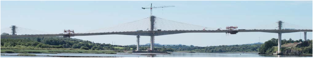
Figura 23. Alzado del puente durante el hormigonado de la última dovela de pila 4
