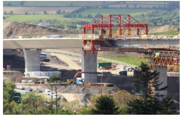
Figura 12. Carro de alas sobre vano 3
