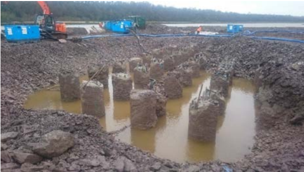
Figura 7. Pilotaje de la pila central
