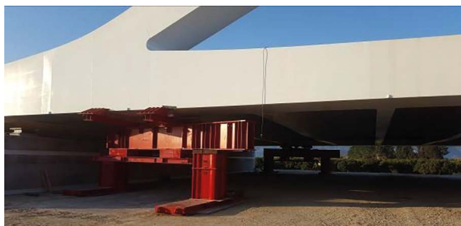
Figura 23. Apoyo mecánico provisional al terreno.
