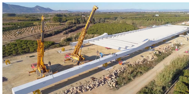
Figura 10. Fotografía aérea de una fase avanzada del montaje de estructura metálica.
