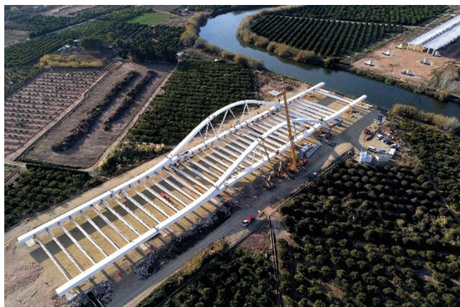
Figura 12. Fotografía aérea de una fase avanzada del montaje de estructura metálica.
