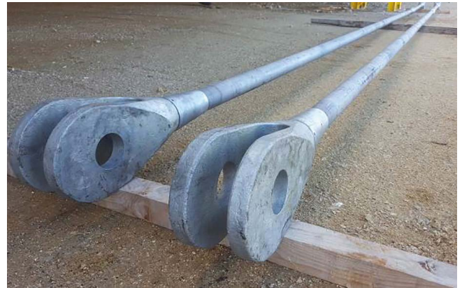
Figura 3. Vista de dos péndolas acopiadas.
