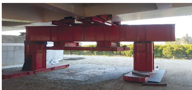
Figura 22. Vista del montaje en obra de la estructura metálica del tablero.
