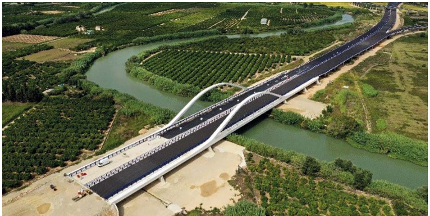
Figura 27. Vista aérea del puente a falta de algunos acabados.
