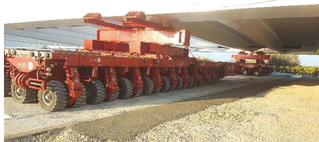
Figura 14. Vista del tablero apoyando sobre un conjunto SPMT, con topes transversales adicionales.
