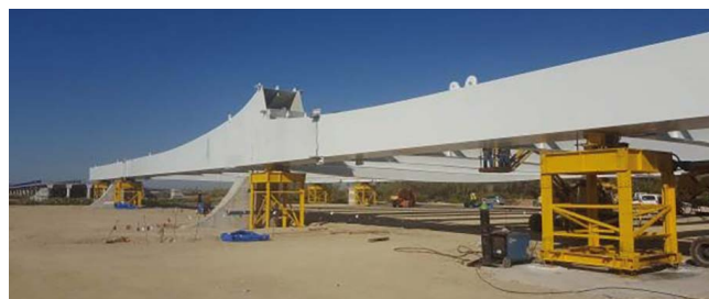
Figura 8. Vista del montaje en obra de la estructura metálica del tablero.
