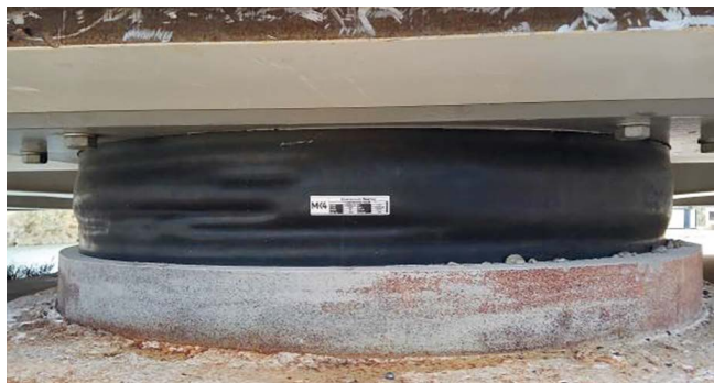
Figura 5. Aparato de apoyo de neopreno circular en carga.
