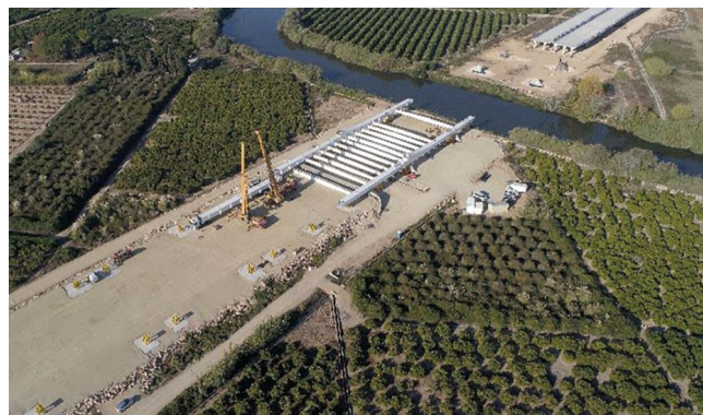
Figura 9. Fotografía aérea de una fase inicial del montaje de estructura metálica.
