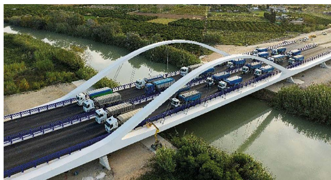
Figura 29. Vista aérea durante la prueba de carga.
