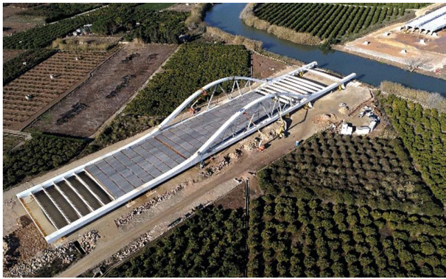
Figura 15. Vista del montaje en obra de la estructura metálica del tablero y prelasas previa al lanzamiento.
