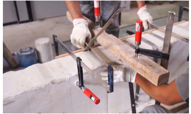
Figura 3. Colocación refuerzo externo. Sección en T.
